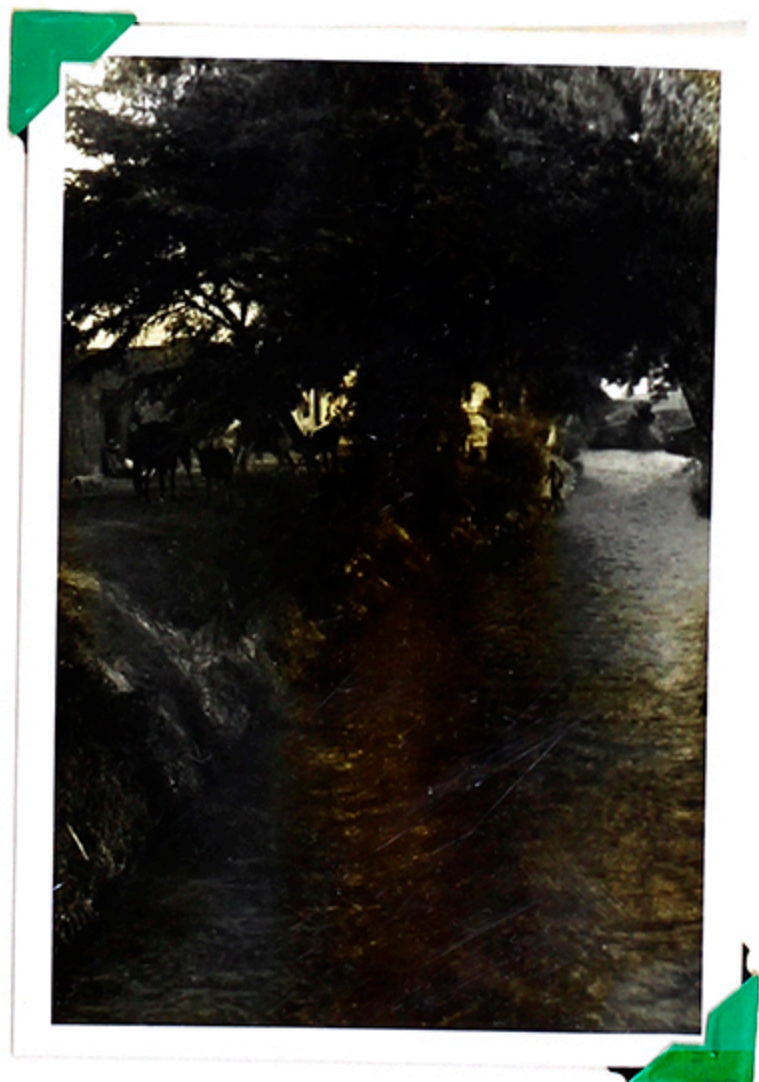
Acequia de Riego que cruza la población y sirve de fuente de abastecimiento a las viviendas cercanas
