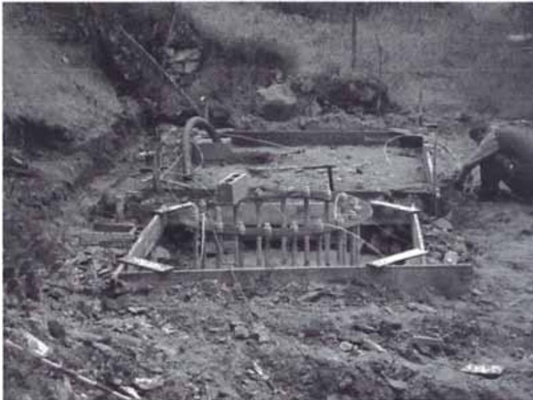
**Figura N° 2.9.- Cimentación para torres tipo monopolo**
