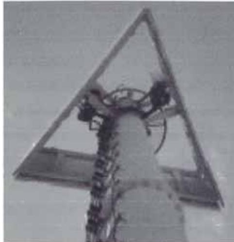
**Figura N° 2.8.- Mimetizado de torre monopolo**
