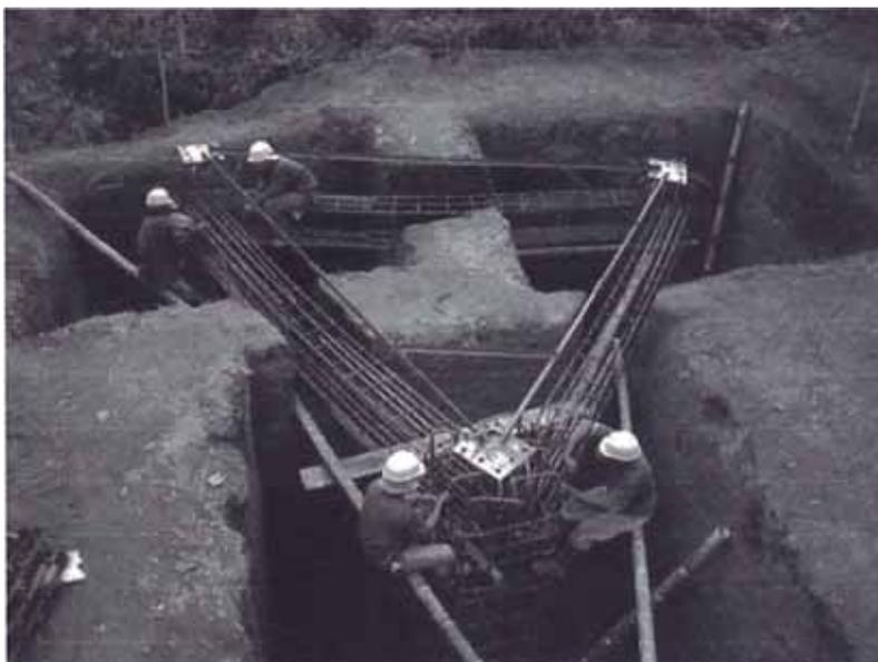
**Figura N° 2.10.- Cimentación para torres autoportadas triangulares**
