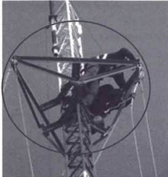
Figura N° 2.5.- Estrella estabilizadora, para torres ventadas
