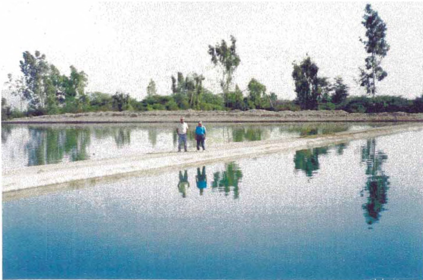
LAGUNAS DE ESTABILIZACION EN EL PERIODO DE LLENADO
