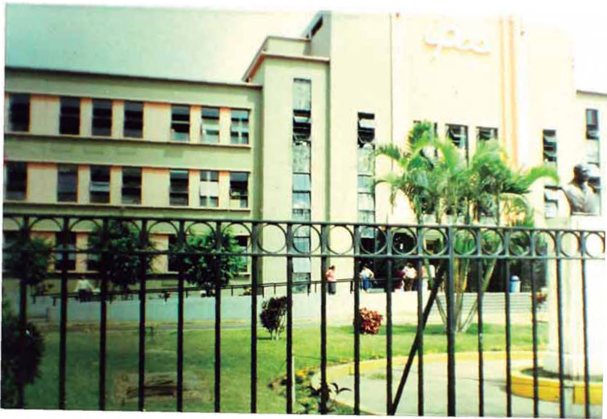
AL FONDO DEL EXTREMO IZQUIERDO SE UBICAN LAS DOS CISTERNAS CENTRAL DEL HOSPITAL NACIONAL "GUILLERMO ALMENARA IRIGOYEN"
