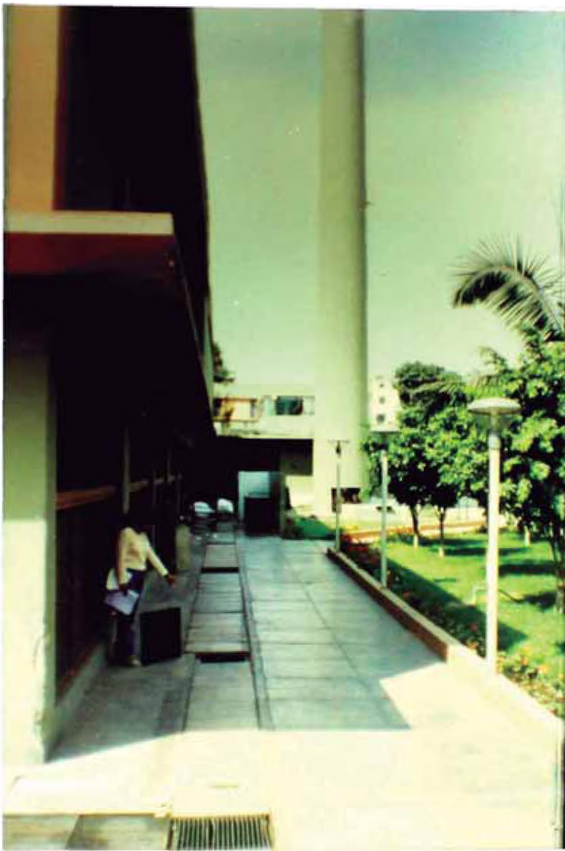
PASES DE TUBERÍA EN DUCTO BAJO N.P.T.
