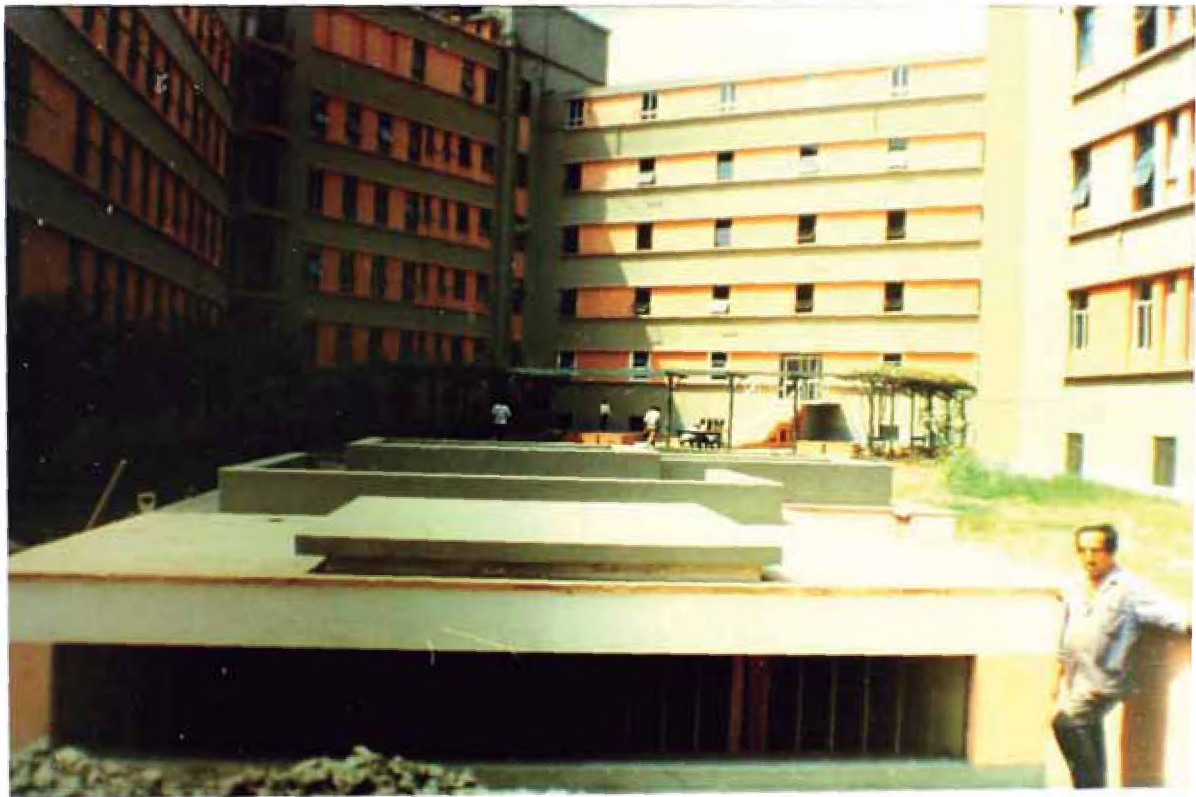
UBICACIÓN DEL POZO PROFUNDO. CASETA DE BOMBEO. AL FONDO SE APRECIA LA BATERÍA DE CUATRO CISTERNAS
