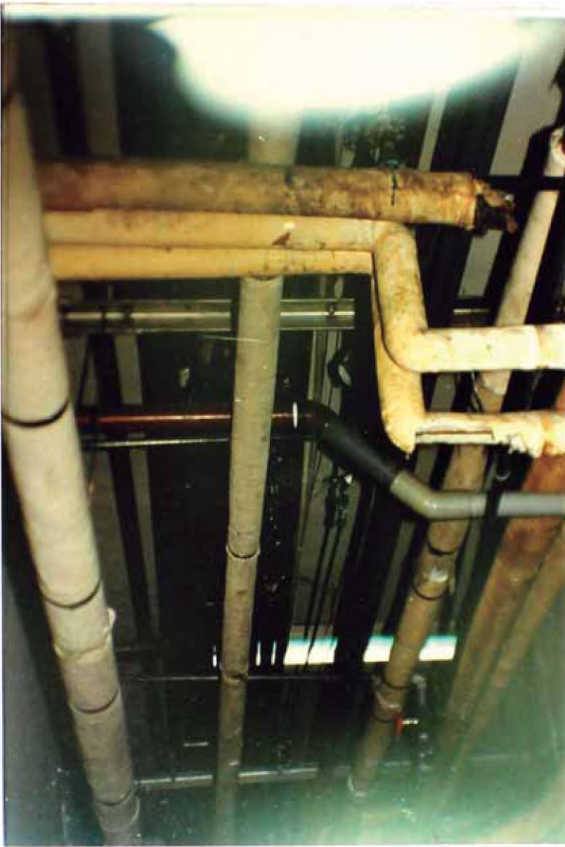
DERIVACIÓN DE EMPALME DE TUBERÍA CONTRA INCENDIO DE F°G° A PVC PARA AGUA DURA
