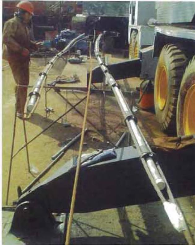
Figura 13: Armado de anclaje de cable.
