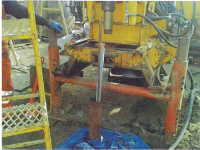
Figura 14: Colocado de anclaje de cable en sondeo.
