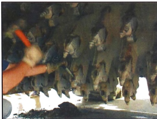
Figura N°19.- Reemplazo de picas
