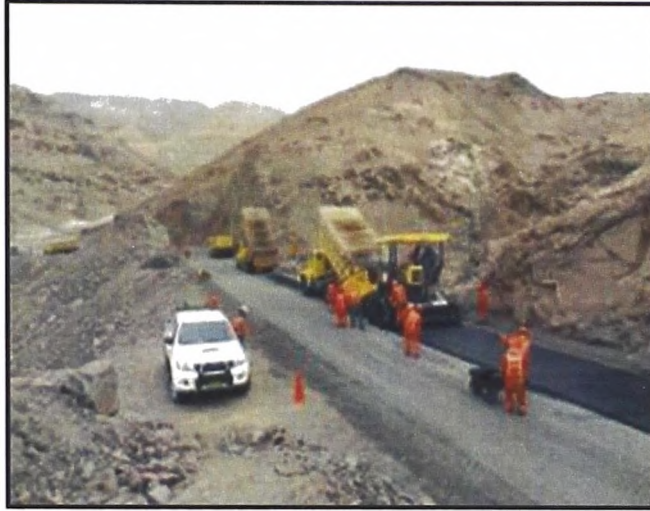
Figura N°24.- Colocación de mezcla asfáltica en caliente, sobre base reciclada.
