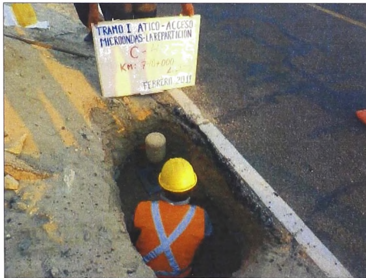
Figura N°01.- Ejecución de calicatas y toma de muestras
