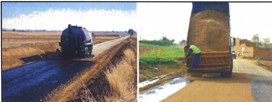
Figura N°23.- Riego de curado y protección con arena
