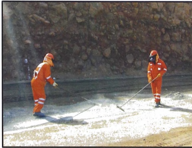
Figura N°18.- Extendido manual de cemento
