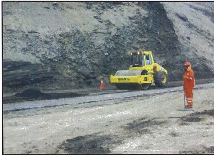
Figura N°21.- Compactación de la base reciclada con cemento
