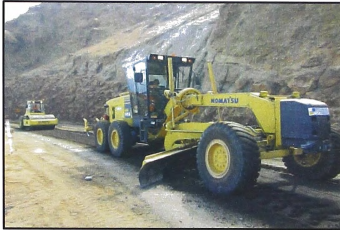
Figura N°22.- Perfilado de material reciclado
