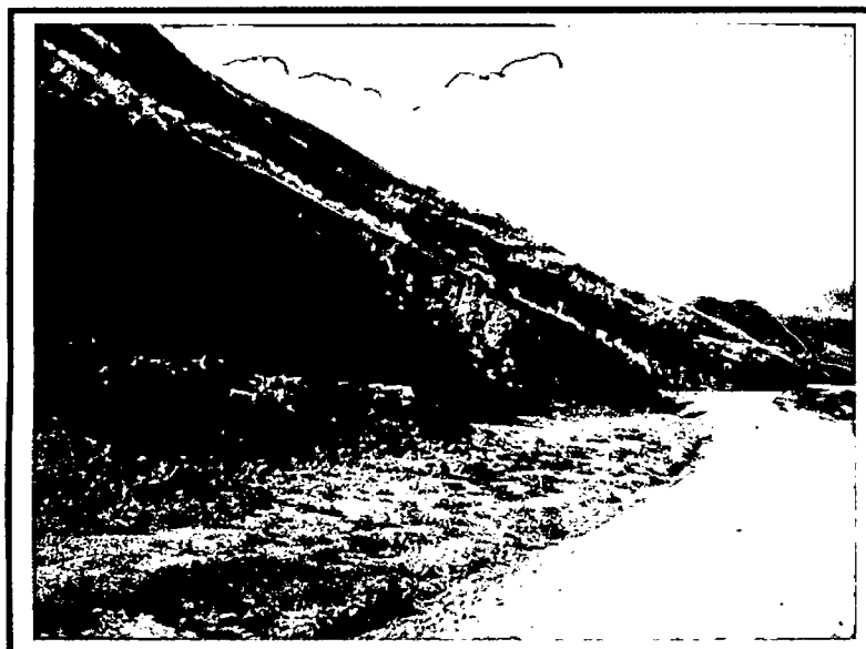
Vista del talud de la cantera km 15+100.
