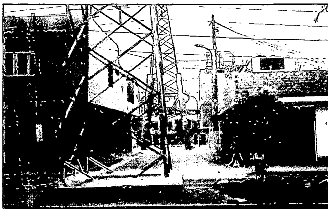
FOTOGRAFÍA 8.10 Urb. Residencial Primavera, torres de alta tensión
