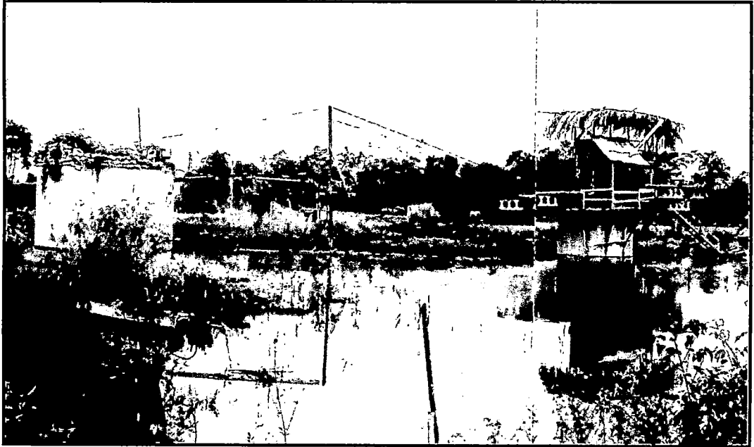
FOTO 1: Los cajones de cimentación para el pilar y estribo del puente Yuracyacu no llegaron a su cota final de diseño en ambas márgenes del río Mayo. Nótese en la vista el detalle de la campana neumática y la plataforma de lastrado en estribo de la margen izquierda.
