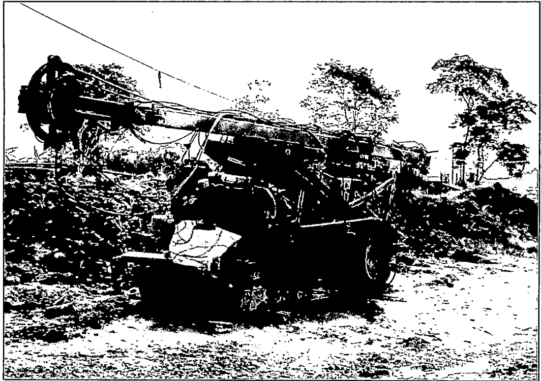
FOTO 7: Equipo "air lift" utilizado en la excavación del material al interior del cajón de cimentación
