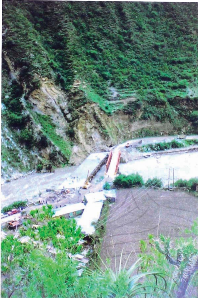
Foto N° 22: Vista general del puente Cuicua tomada desde el margen izquierdo en la culminación de la colocación del concreto sobre la losa superior f'c 320 Kg/cm 2 .
