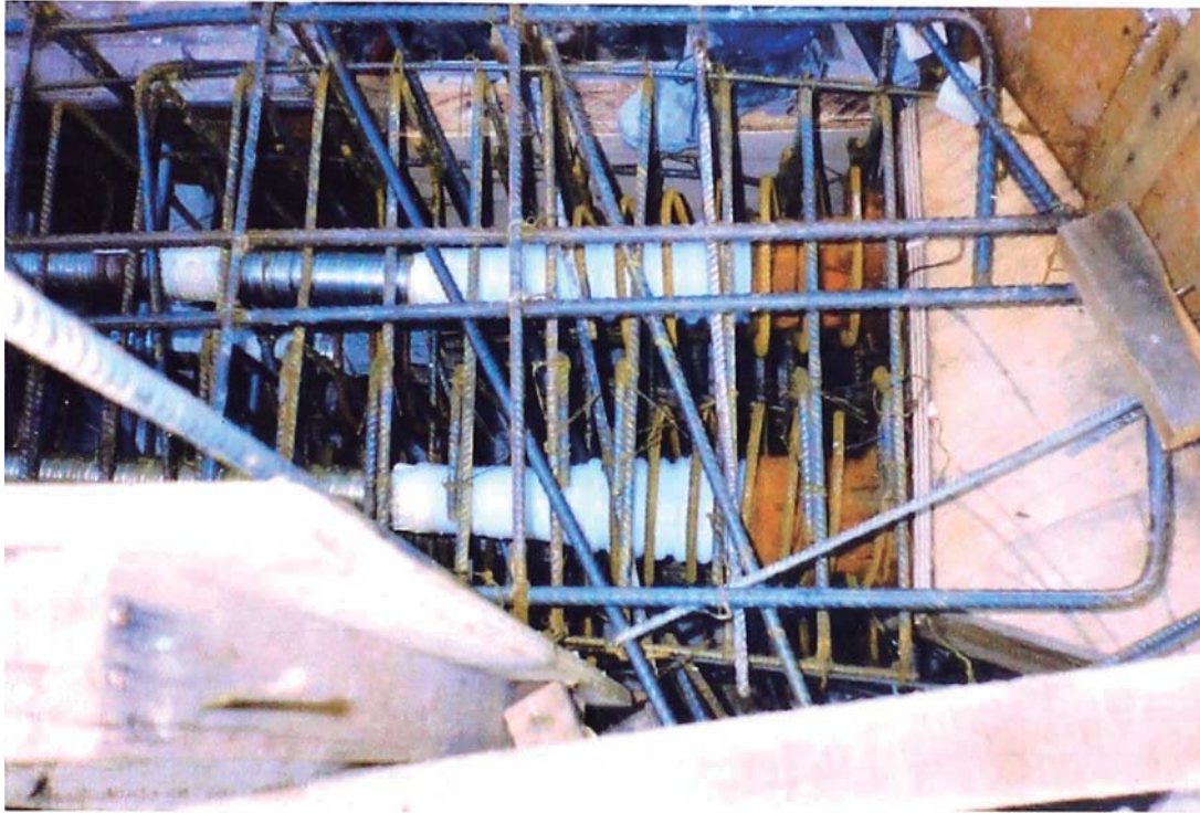
Foto N° 18: Anclaje del tipo móvil colocado en la viga, son 04 tendones de 10 torones de \varnothing 5/8" por viga con una fuerza final de 1250 toneladas, la cajuela de entrega se dispone según el esviaje del puente.
