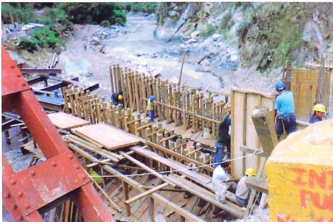
Foto N° 08: Detalle del avance del encofrado de vigas y losas, tal como se muestra en la lámina CU 6/7, aún el nivel de aguas del río es bajo.
