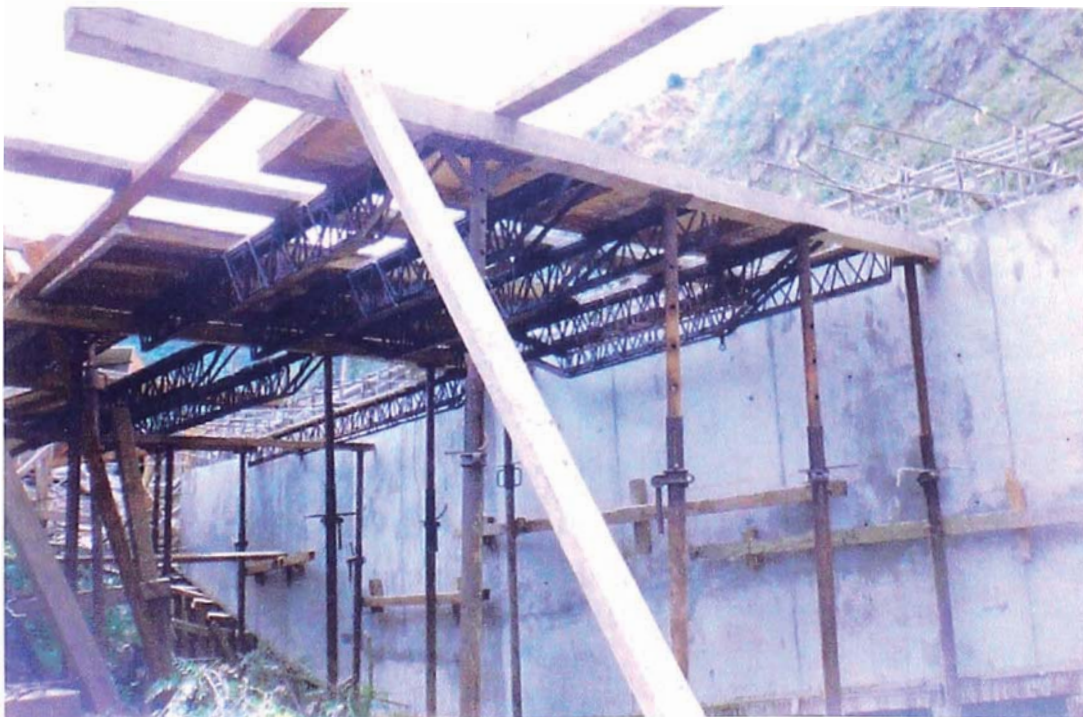
Foto N° 12: Detalle del encofrado de los voladizos de la losa superior, segunda etapa del encofrado de la superestructura.
