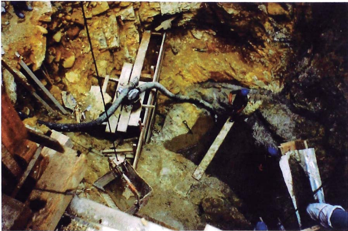
Foto N° 01: Excavación de la cimentación de la margen izquierda, se aprecia el empleo de motobombas para drenar la napa.
