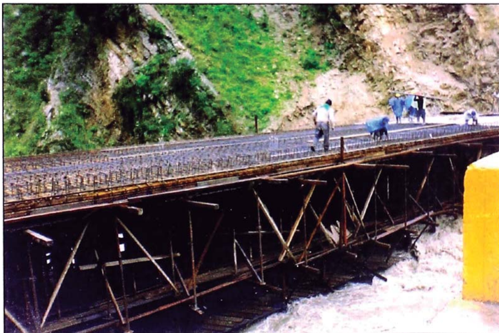
Figura N° 5. Observamos el nivel de aguas cruzando por encima del entablado del falso puente, para los llenados de concreto se empleó aditivo acelerante de fragua de la mezcla. El concreto para poder ser postensado tenía que alcanzar una resistencia mínima de 255 Kg/cm 2 .
