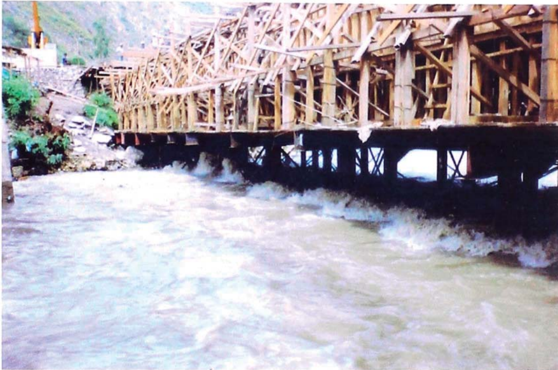
Foto N° 09: Se aprecia el incremento del nivel de aguas, el material que arrastra el río es atrapado por los arriostres del falso puente.
