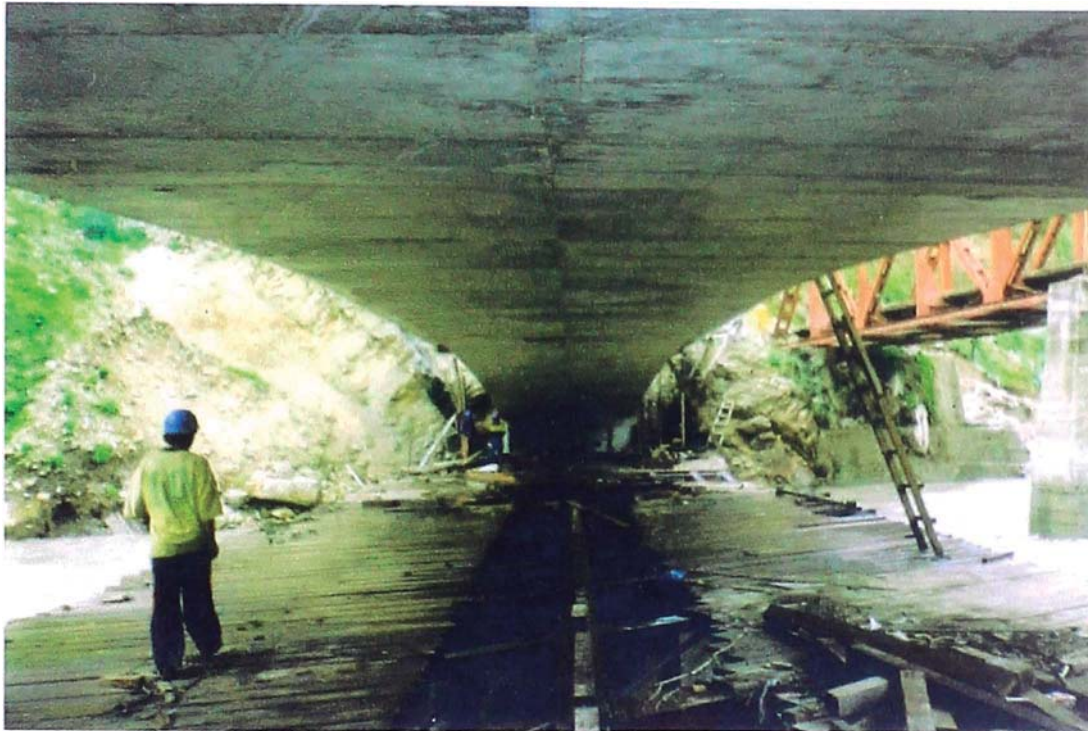
Foto N° 15: Se retiró el encofrado a los 21 días, luego de haber tensado columnas y vigas, se observa el entablado sobre el falso puente.
