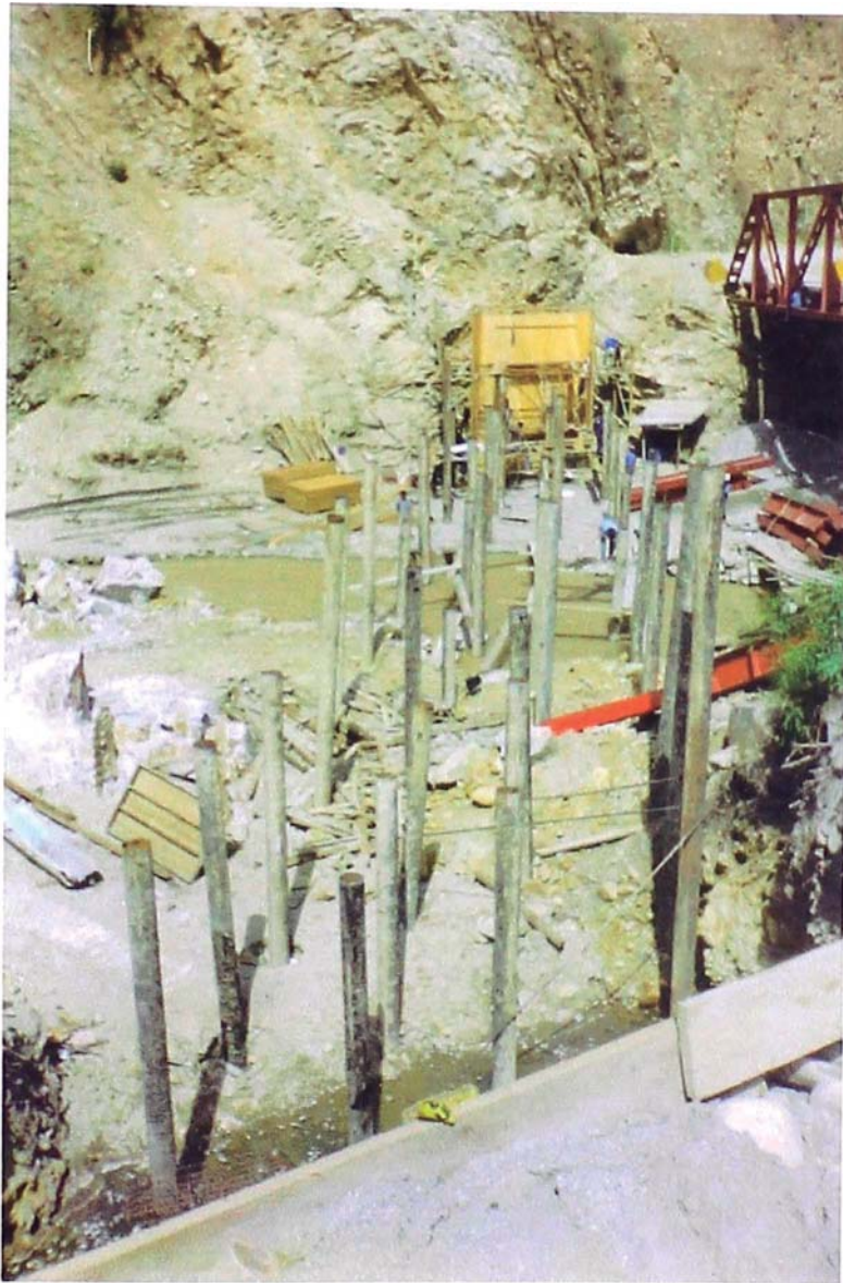
Foto N° 06: Finalización del hincado de pilotes; la imagen se muestra desde el margen izquierdo, la labor que continua es realizar el entramado de las vigas de acero. Previamente se deben cortar los pilotes de tal forma que el acabado de la estructura incluyendo las vigas alcancen el nivel 2670.34 msnm. Se puede apreciar el bajo nivel de aguas (noviembre 1998), el lecho se compone de conglomerado con bolonería \varnothing 1.20 m en promedio lo cual dificultó el hincado de algunos pilotes que se ven inclinados, además; se observa el encofrado de la columna del margen derecho.
