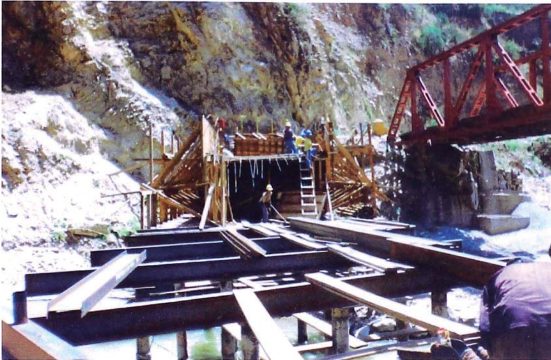
Foto N° 07: Proceso de encofrado del tercio derecho de la superestructura, simultáneamente se avanza con el entramado de vigas metálicas del falso puente.
