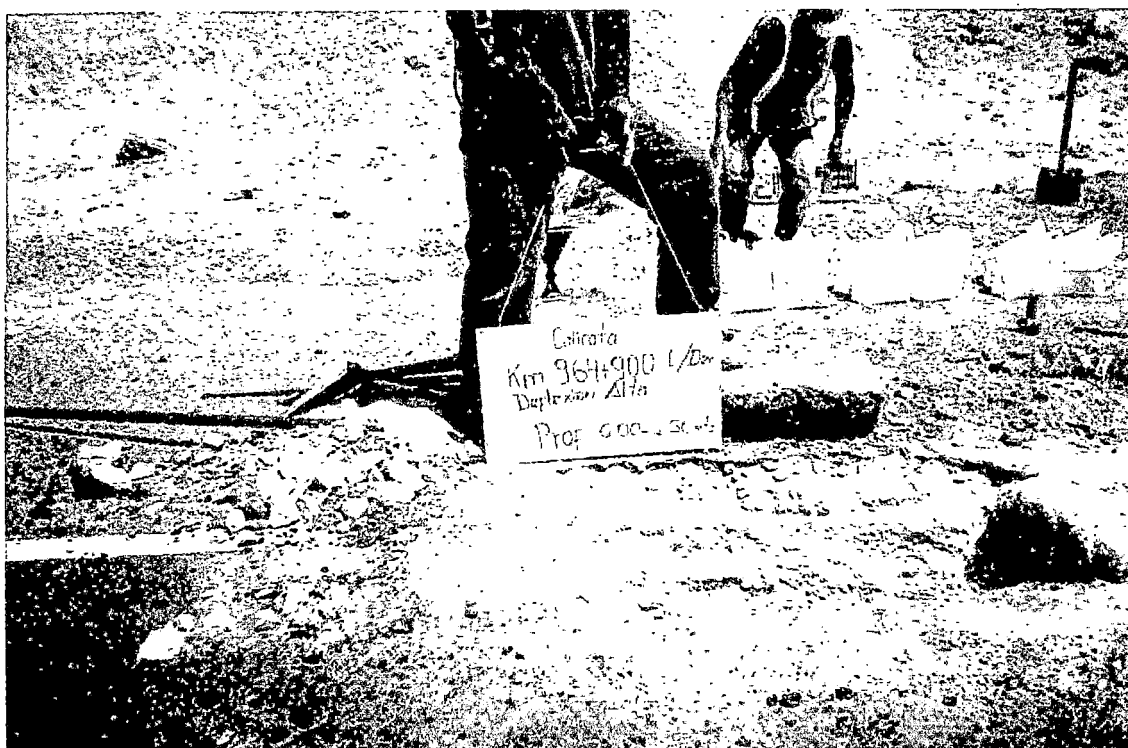
Calicata en el Km. 964+900 Lado derecho.
