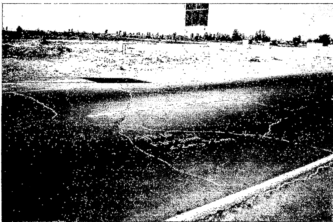
Fisuramiento en bloque > 3mm. Km. 913+160.
