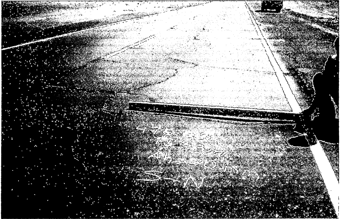
Ahuellamiento > 20 mm y fisuras en bloque Km. 979+650.
