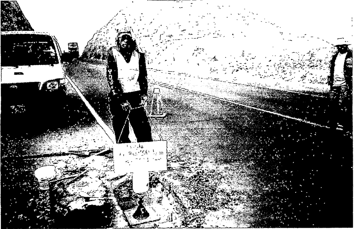
Calicata en el Km. 943+900 Lado derecho.
