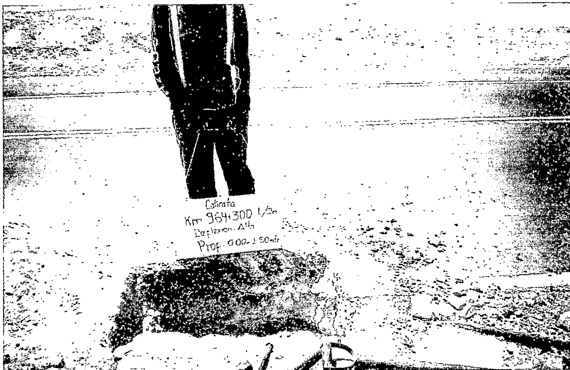
Calicata en el Km. 964+300 Lado derecho.
