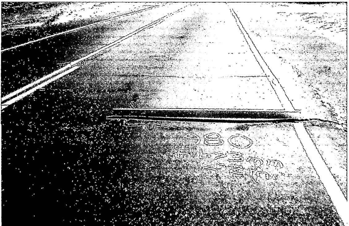
Casi al final del tramo, fisuras en bloque y ahuellamientos Km. 980+000.
