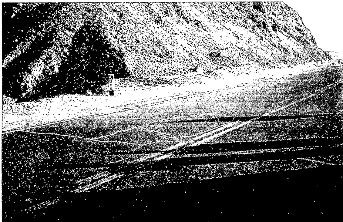
Se Observa la formación de la fisuras en Bloque Km 919+000.
