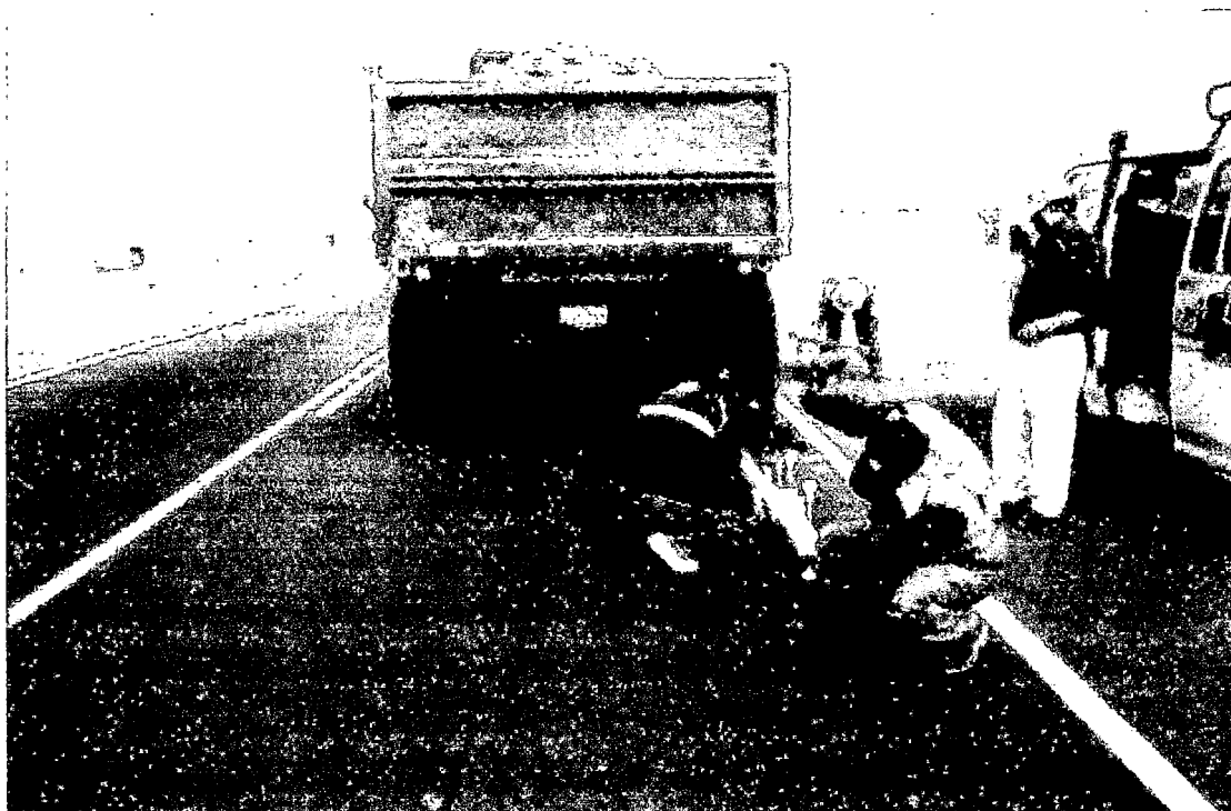
Preparando el equipo y muestreando el espesor de la carpeta.
