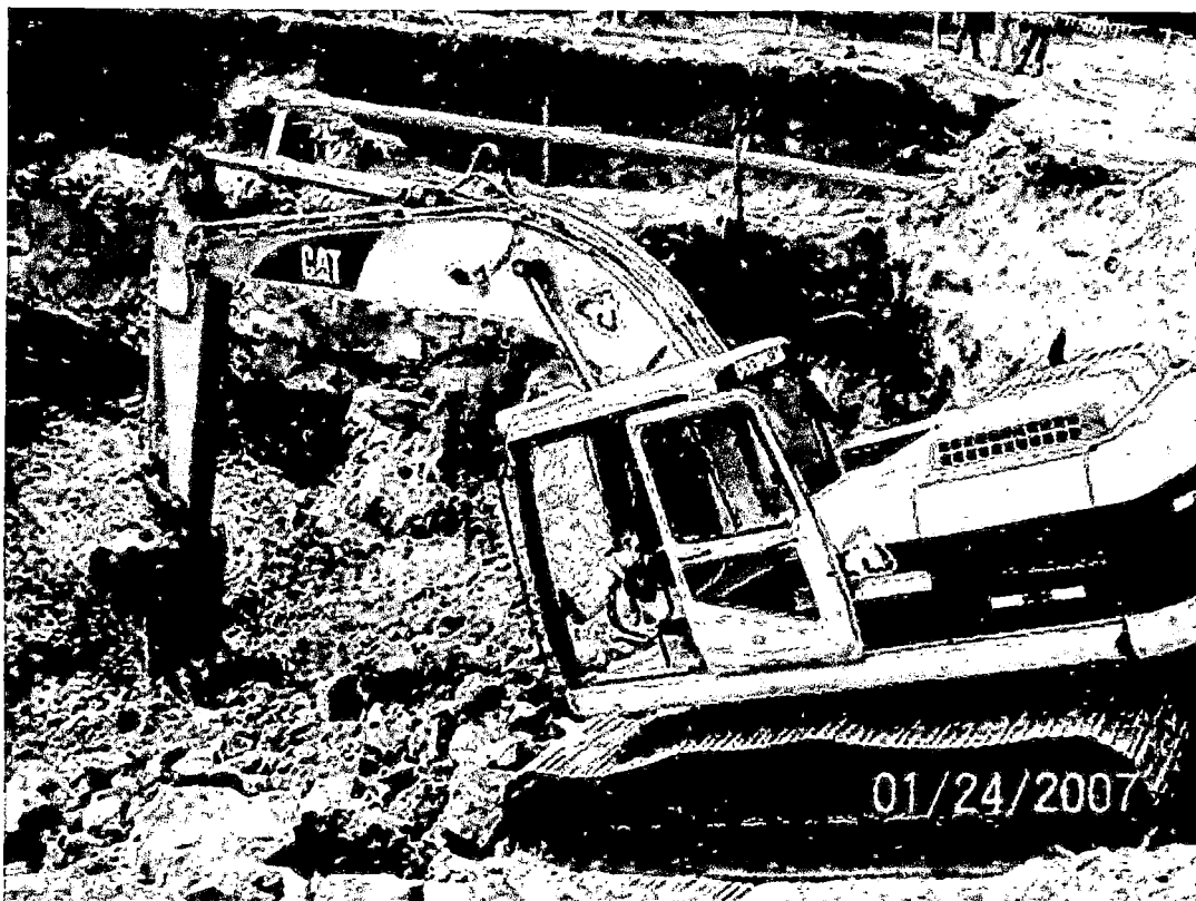
Fotografía 5.6 Excavación Masiva en terreno Rocoso para alcanzar el nivel de piso de una cisterna enterrada.
