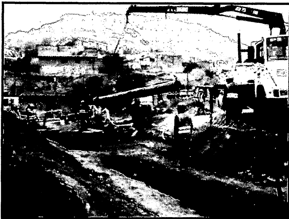
Fotografía 5.8 Colocación de Tubería en Zanja con Grúa
