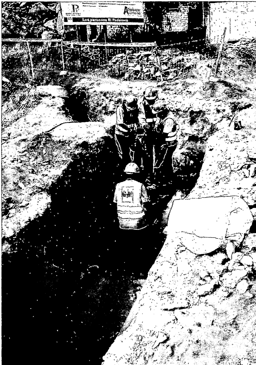
Fotografía 5.3 Excavación en Líneas en Terreno Rocoso en zonas planas
