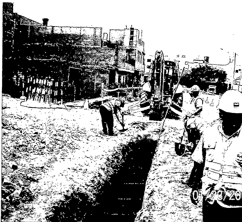
Fotografía 5.1 Excavación en Líneas en Terreno Normal en zonas planas
