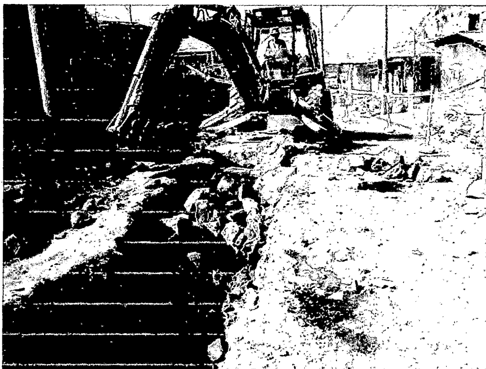
Fotografía 5.2 Excavación en Líneas en Terreno Semirrocoso en zonas planas
