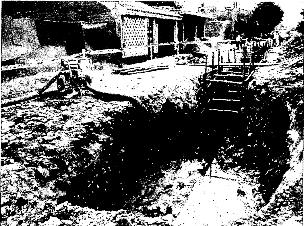
Fotografía 5.4 Excavación en Líneas en Terreno saturado con colocación de entibados para estabilizar los taludes y bombeo para desalojar el agua de la zanja
