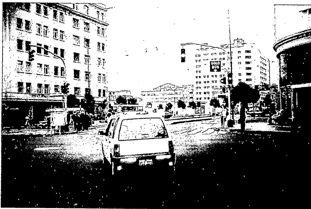
FOTO N° 32: Otra vista de la intersección Av. Tacna – Av. Nicolás de Piérola. Aquí se aprecia parte de la señalización vertical (Indicando el tipo de vehículo que debe pasar por el carril, entre otros), que esta adosado al poste tipo pastoral donde se encuentra los semáforos vehicular y peatonal. [Fuente: Propia]
