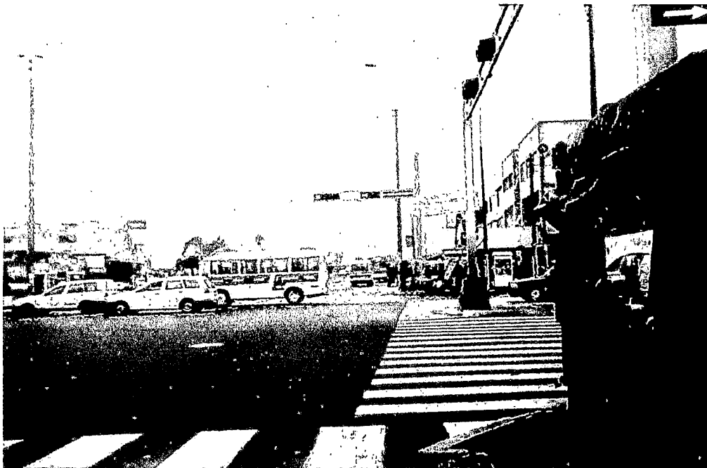
FOTO N° 55: Vista de la intersección Av. Aviación – Av. Canadá. Aquí se puede apreciar que el soporte de los semáforos vehiculares son del tipo pórtico y bandera. Además el color que presenta el soporte no es amarillo por tanto no existe uniformidad. [Fuente: Propia]
