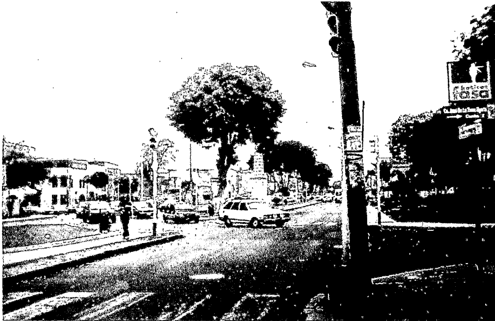
FOTO N° 37: Vista panorámica de la intersección Av. Arequipa – Av. José de la Torre Ugarte. El tipo de ubicación del semáforo es japonés (N – S) y americano en el otro sentido. Falta mantenimiento en pintado, respecto al cruceo peatonal. [Fuente: Propia]
