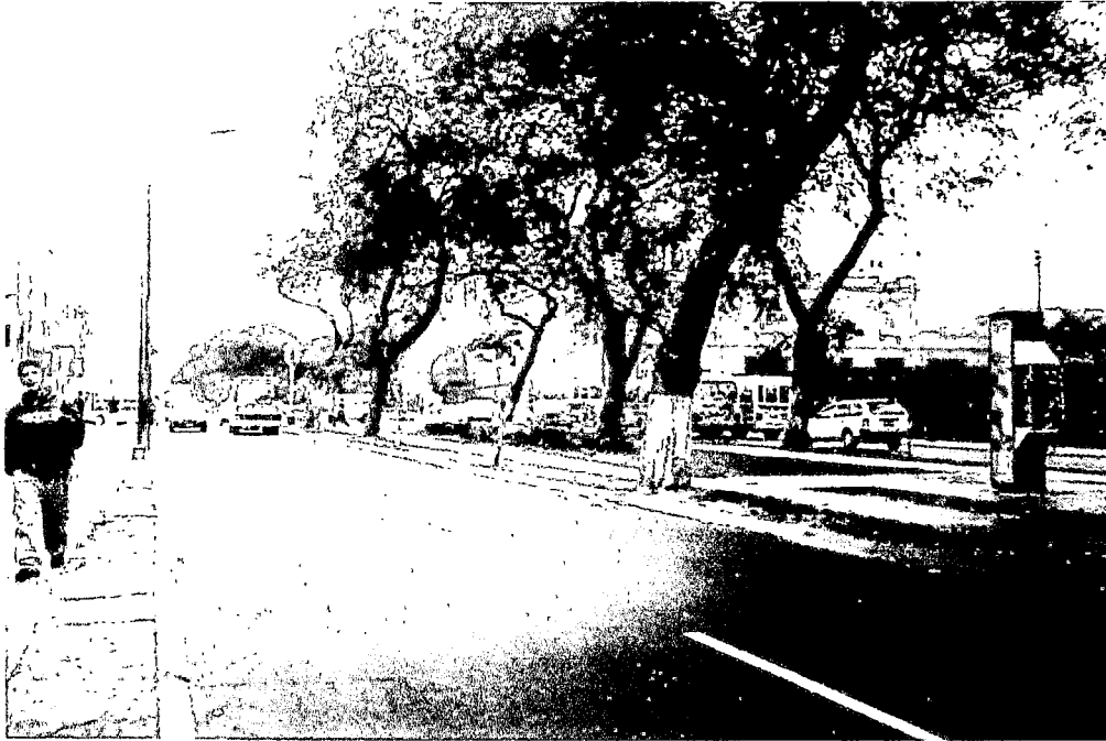
FOTO N° 33: En esta vista se aprecia parte de la sección de vía en la Av. Arequipa, el deterioro de la acera, los diferentes tipos de vehículos que transitan por ella, así como los postes semafóricos. [Fuente: Propia]
