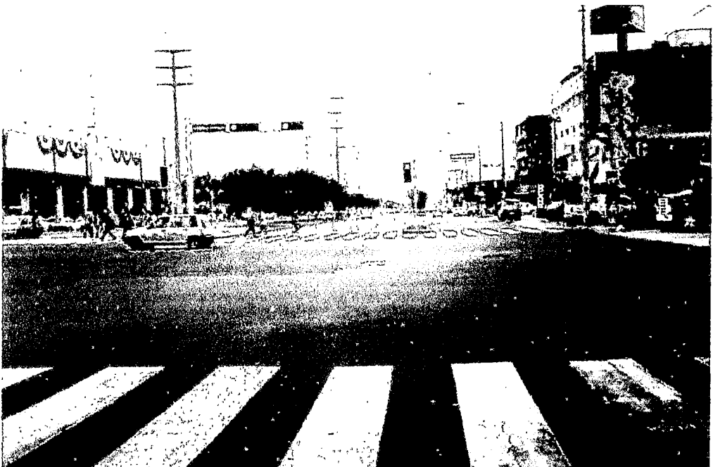
FOTO N° 69: Es otra vista de la intersección Av. Canadá – Av. Nicolás Arriola, en el cual se puede apreciar la sección de vía de la Av. Nicolás de Arriola. El soporte del semáforo es tipo bandera y pedestal. [Fuente: Propia]
