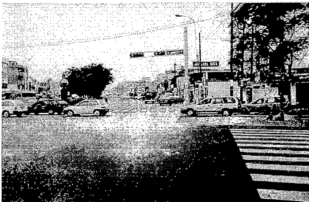
FOTO N° 62: Vista de la intersección Av. Canadá – Av. Rosa Toro. Aquí se puede observar un soporte de semáforo tipo bandera, el cual está ubicado cruzando la intersección (es del tipo americano). Su señalización horizontal está bien demarcada. [Fuente: Propia]
