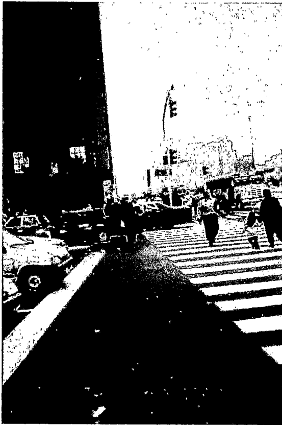
FOTO N° 9: Otra vista de la intersección Av. Abancay – Av. Nicolás de Piérola. Se aprecia el semáforo vehicular y peatonal adosado al poste tipo pastoral. El tipo de ubicación del semáforo es americano en esta intersección. [Fuente: Propia]
