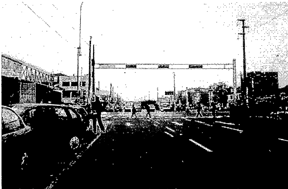
FOTO N° 66: En esta vista se puede apreciar el soporte del semáforo tipo pórtico, en el sentido de la Av. Canadá, así como su señalización horizontal. Esta vista pertenece a la intersección Av. Canadá con Av. Aviación. [Fuente: Propia]
