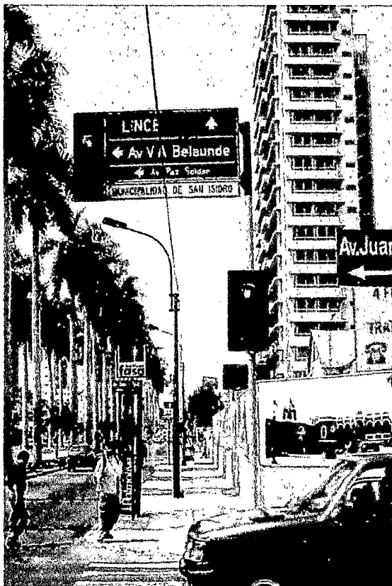
FOTO N° 37: Vista panorámica de la intersección Av. Arequipa – Av. José de la Torre Ugarte. El tipo de ubicación del semáforo es japonés (N – S) y americano en el otro sentido. Falta mantenimiento en pintado, respecto al cruceo peatonal. [Fuente: Propia]
