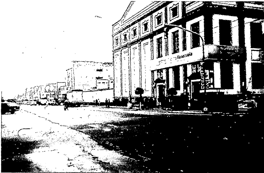
FOTO N° 47: Vista de la intersección Av. Venezuela – Jr. Huaraz. Aquí se puede apreciar que el semáforo se encuentra cruzando la intersección (Sistema tipo europeo), así como la falta de mantenimiento (pintura) en la señalización horizontal y el deterioro de la calzada. [Fuente: Propia]
