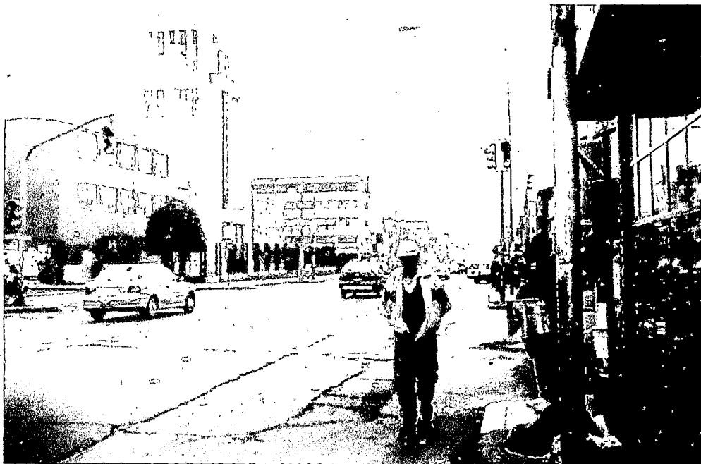
FOTO N° 48: Vista de la intersección Av. Venezuela – Jr. Aguarico. Aquí también se puede observar que el semáforo se encuentra cruzando la intersección (sistema tipo europeo), así como la falta de mantenimiento (pintura) en la señalización horizontal y el deterioro de la calzada. [Fuente: Propia]
