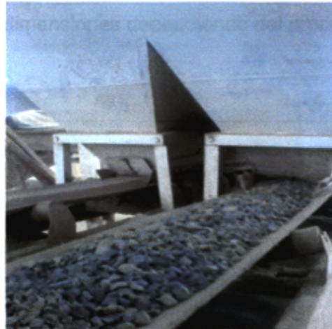
Figura 1.1 Agregados saliendo de las tolvas de almacenamiento.
