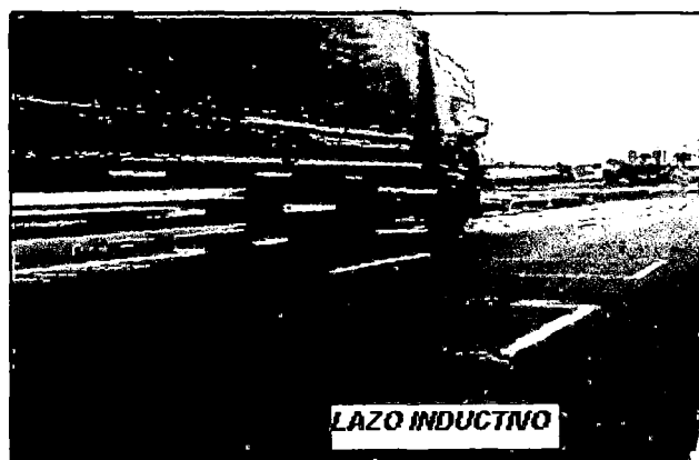
Fotografía N° 3.16: Lazos Inductivos en la Pista.
