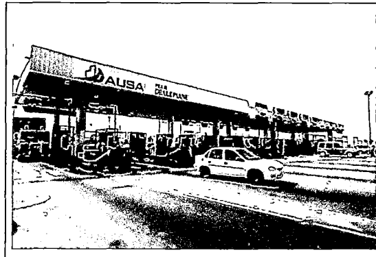
Fotografía N° 4.40: Autopista Urbana Dellepiane
