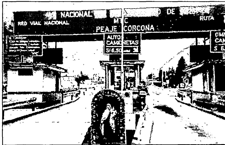
Fotografía N° B.71: Estación de Peaje Corcona-Afueras de Lima.
