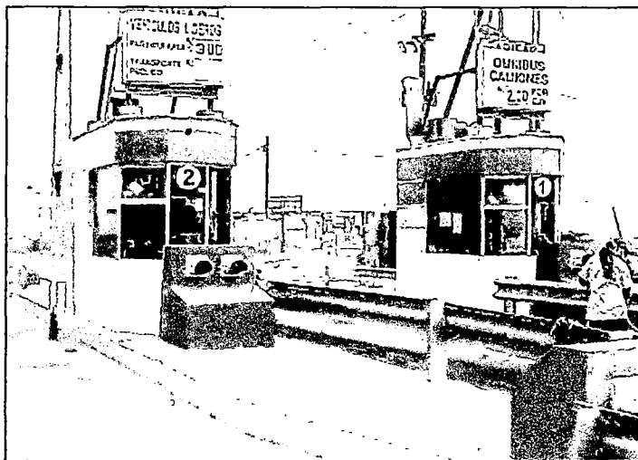
Fotografía N° B.61: Estación de Peaje de Villa (II)-Panamericana Sur
