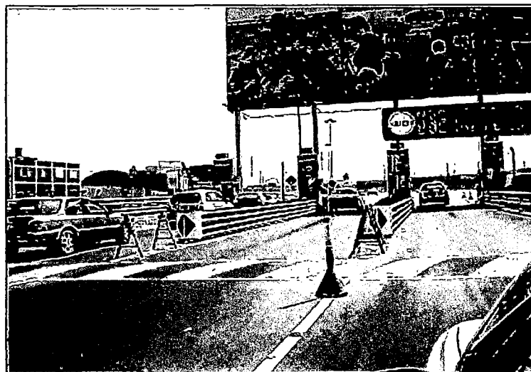
Fotografía N° B.70: Estación de Peaje Separadora Industrial.
