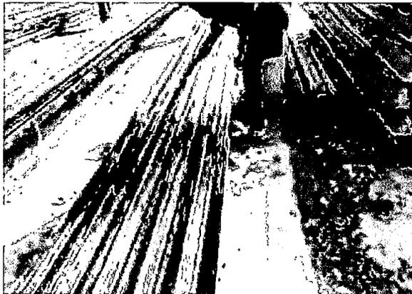
Fot.02. Limpieza y aplicación de desmoldante.
