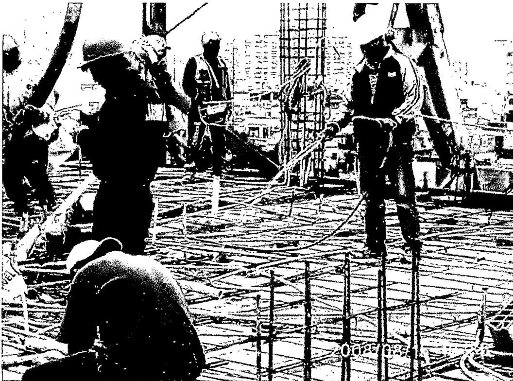
Fot.54. Regado de la losa previo al vaciado
