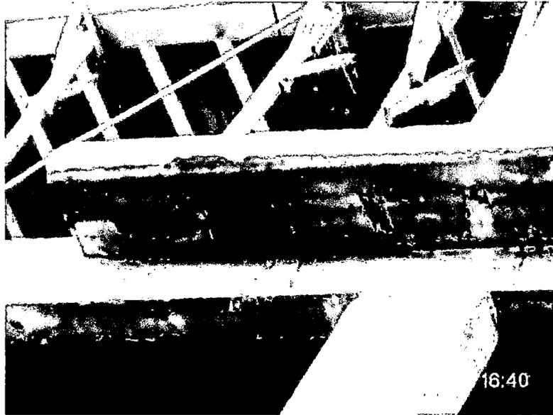
**Fot.28. Ladrillos de techo mal colocados**
