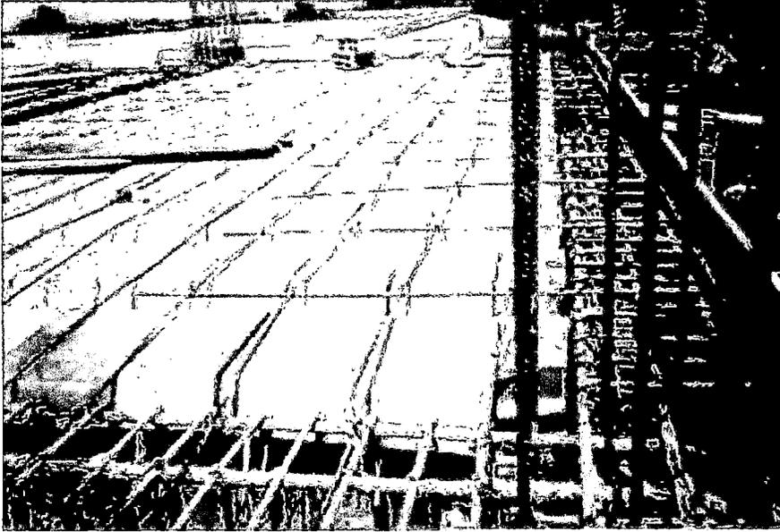
Fot. 46. Colocación del acero de temperatura
