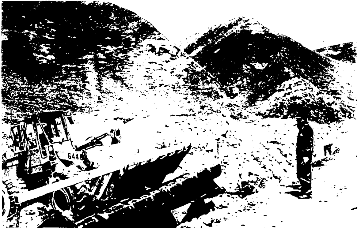
F-5 AQUÍ SE PUEDE VER EL POSICIONAMIENTO DEL CARGADOR CON EL ROLLO DE GEOMEMBRANA PARA INICIAR SU TENDIDO
