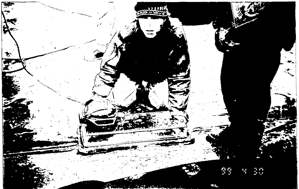
F-15. AQUÍ SE PUEDE VER EL MOMENTO EN EL CUAL SE EFECTUA EL CONTROL DE CALIDAD CON LA VACUM BOX A UNA REPARACION HECHA SOBRE LA GEOMEMBRANA
