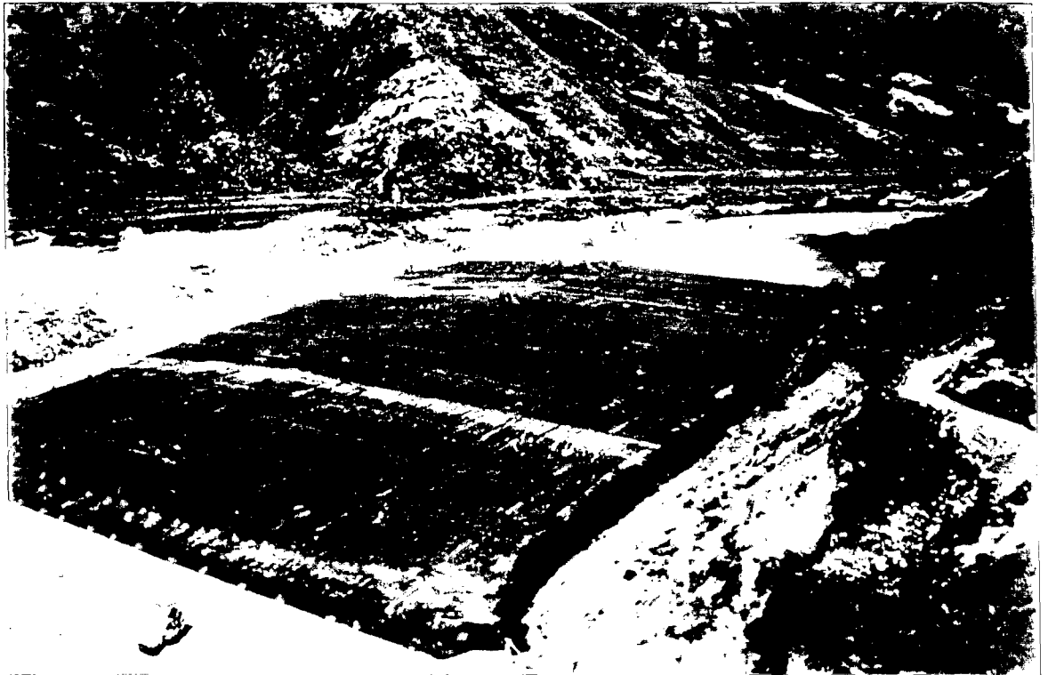
F-19. VISTA PANORAMICA DEL DEPOSITO DE TRIOXIDO DE ARSENICO EN LA QUE SE PUEDE VER EL AVANCE DE LA INSTALACION DE LA GEOMEMBRANA
