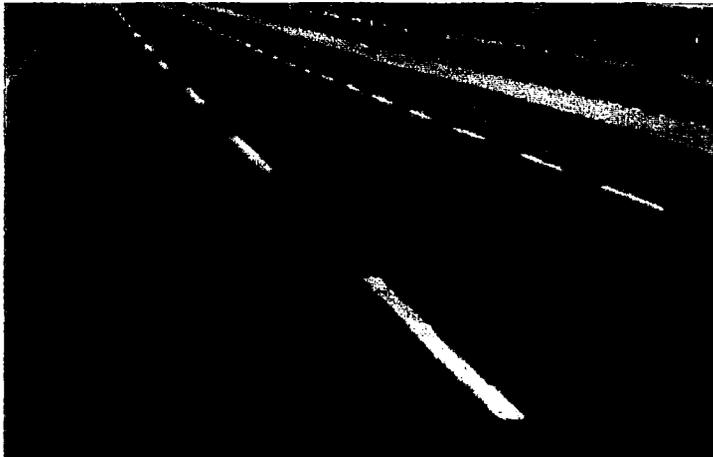
Vista 2.- Areas reparadas (Falla N°6, 7, 8, 9). Se observa en la N°9 Un ligero desnivel (sobrecompactado de las capas).
