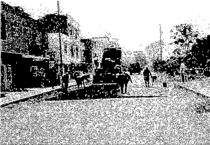
Vista 5.- Colocación de la Mezcla Asfáltica en Caliente ( $e=2''$ ).
