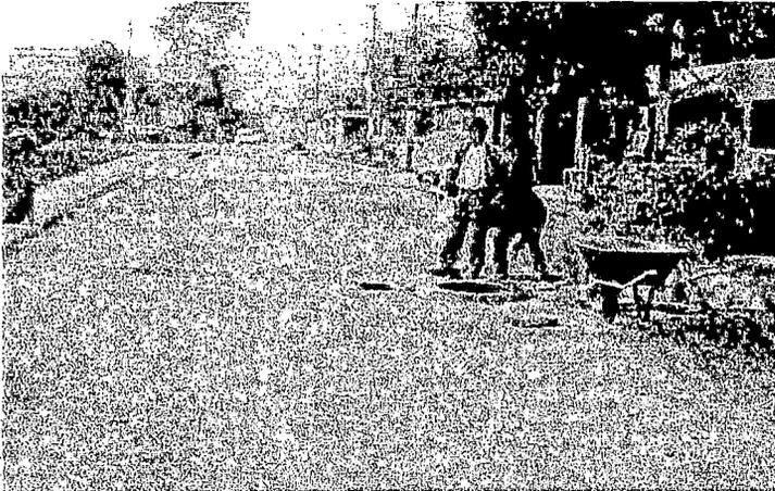
Vista 2.- Nivelación de Buzón. Se observa el Firme terminado. [ Ubicado en el Tramo con Falla N° 16 ]
