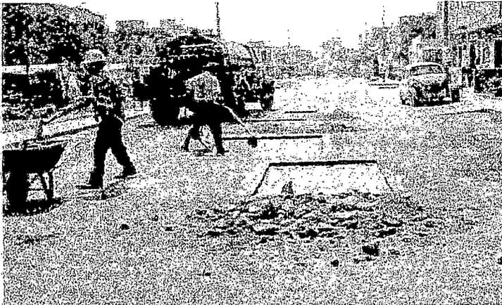
Vista 3.- Momento del Riego de Imprimación con Asfalto Líquido. Nótese el material excedente que debería haberse recogido antes de aplicar el ligante. [ Areas Parchadas N° 6, 7, 8 y 9 ]
