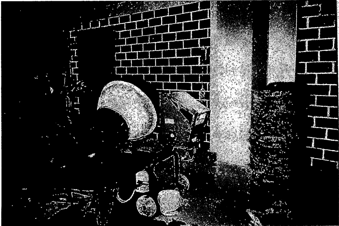
Foto N° 01 Elaboración del concreto con la mezcladora de 1/2 p3
