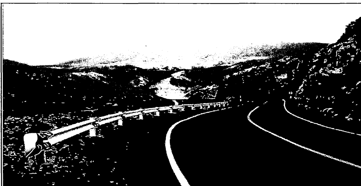
FOTO N° 2: KM 006 + 900, VISTA DE SUR A NORTE
