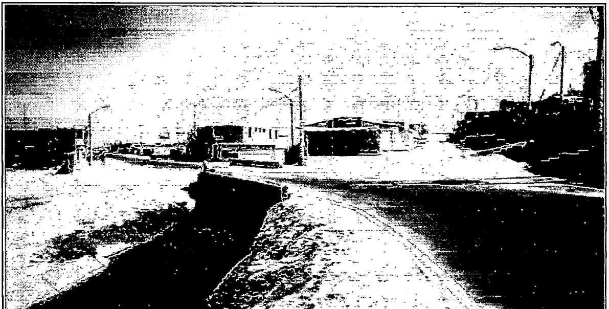
FOTO N° 18: KM 041 + 800, VISTA DE SUR A NORTE
