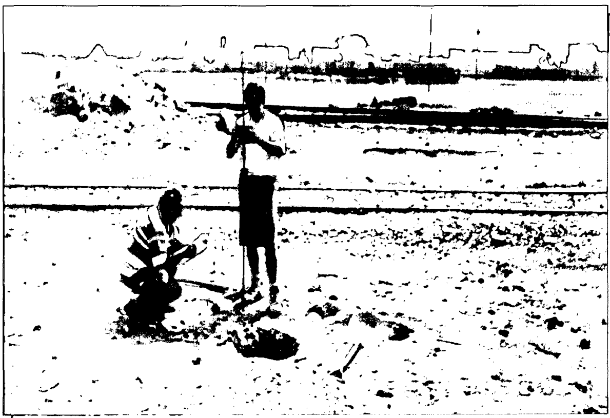
Foto N°16 Ensayo de PDC sobre el nivel del terreno natural y a lado de la calicata, ubicada en la Av. Gambeta del Proyecto Litoral Norte.
