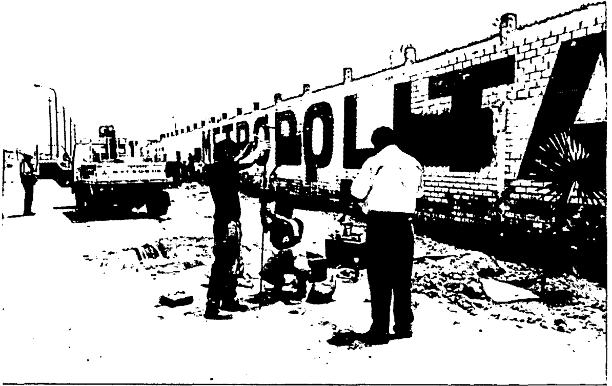
Foto N°9 El ensayo de PDC cerca al lugar del ensayo de CBR in situ, en la evaluación del pavimento de la Av. Naranjal.
