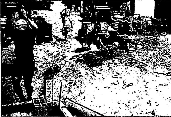
Debido al volumen de concreto a colocar conjuntamente en vigas y losas aligeradas se usan mezcladoras (7, 9, 12 ó 16 pies cúbicos); la proporción en volumen para la dosificación es (cemento : arena : piedra) = 1 : 3 : 3 + 26 lts de agua por bolsa de cemento aproximadamente.
