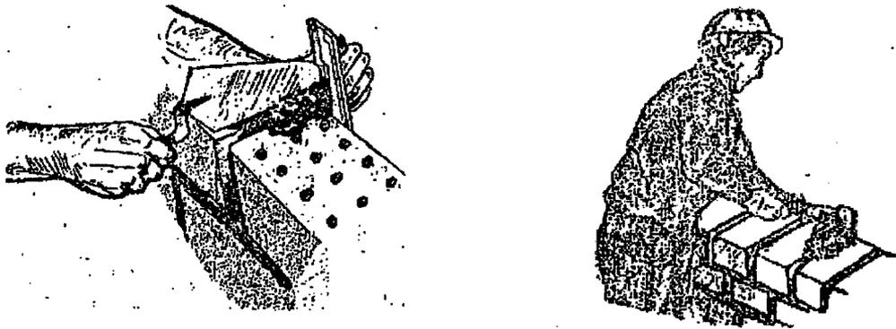
*Muchas veces hay que utilizar partes de un ladrillo para completar una hilada esta operación de corte se realizará con la picota.*
