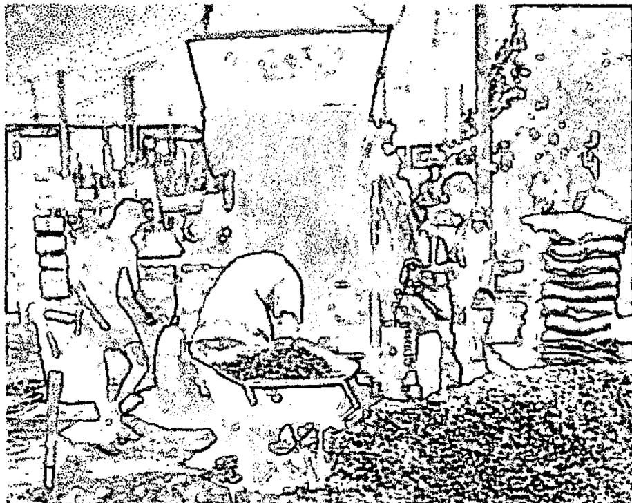
*Después de mojar las caras interiores de los encofrados, iniciamos la colocación de concreto, Primero en la Vigas Principales
