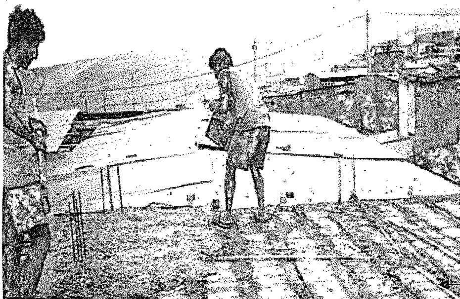
*Al momento de colocar el concreto debemos tener cuidado de no pisar los tubos de las instalaciones eléctricas o sanitarias, ya que al quedar empotradas en la losa y si están rotos se obstruirán con concreto.*
