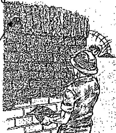
Proceder a colocar el mortero en toda la superficie de tal manera que cubra los puntos de aplome con un espesor de 1 cm.
