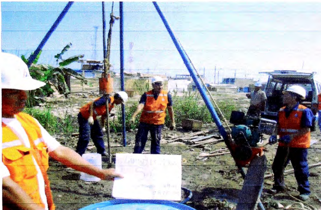
Foto 18; Perforación SPT S-6.
