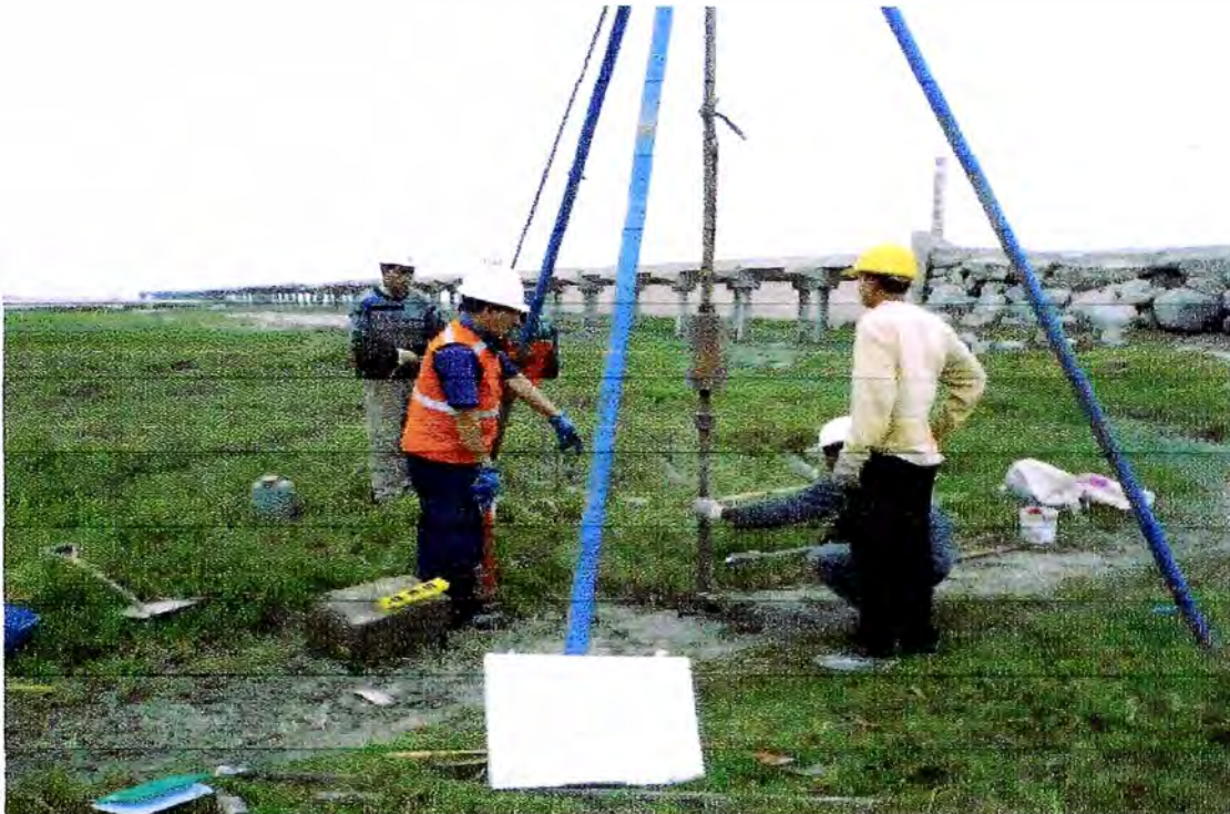
Foto 23; Perforación SPT S-15.
