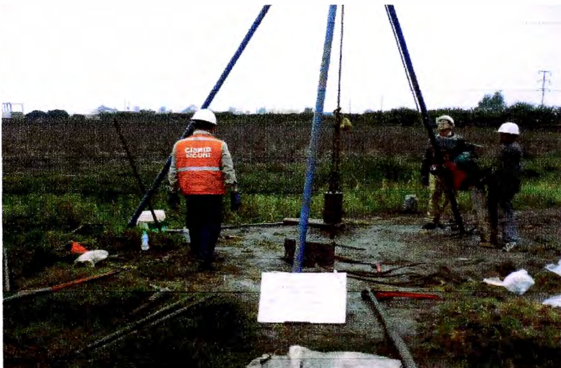
Foto 24; Perforación SPT S-17.
