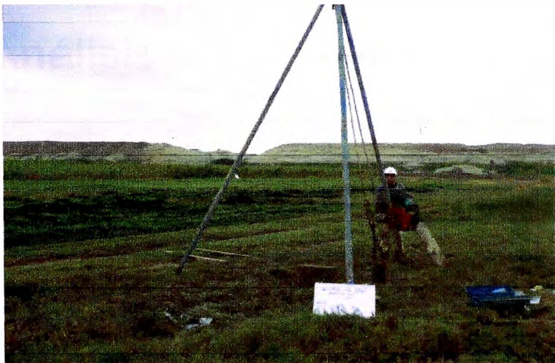
Foto 26; Perforación SPT S-19.
