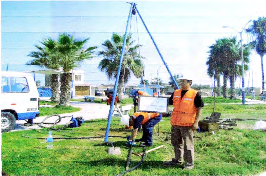
Foto 17; Perforación SPT S-4.
