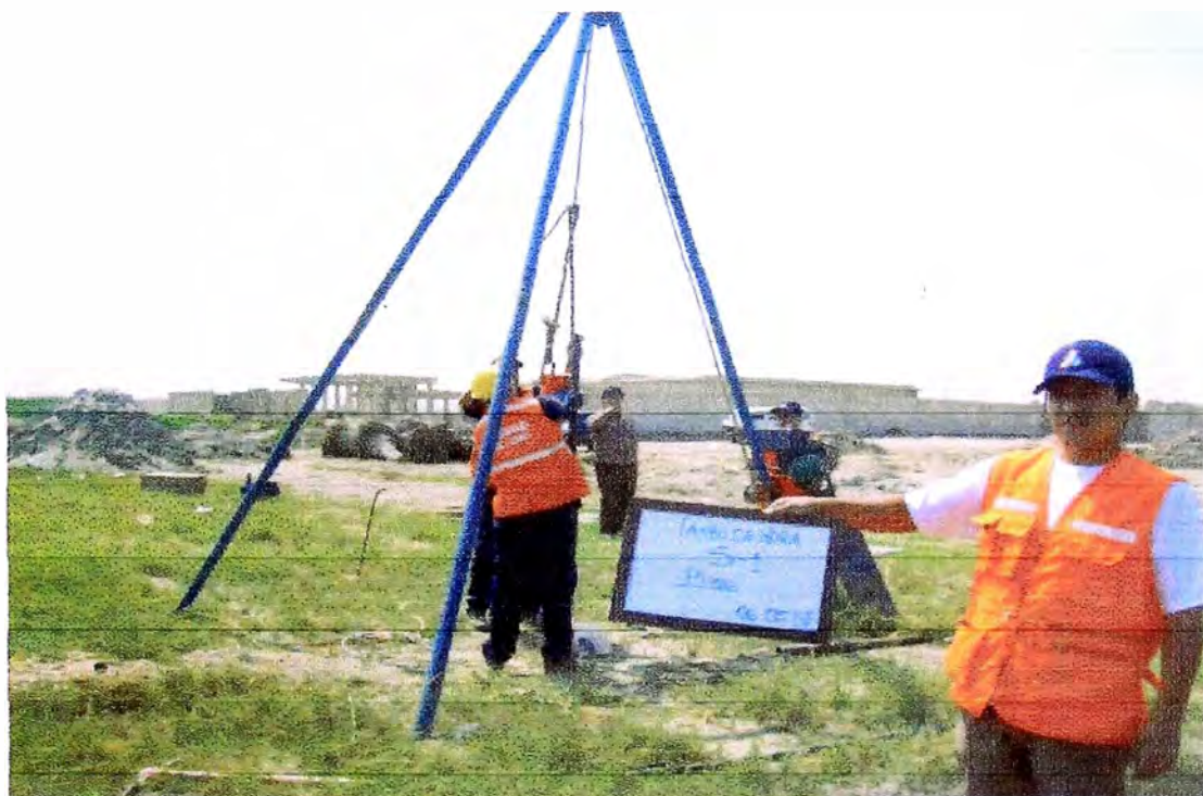
Foto 16; Perforación SPT S-1.
