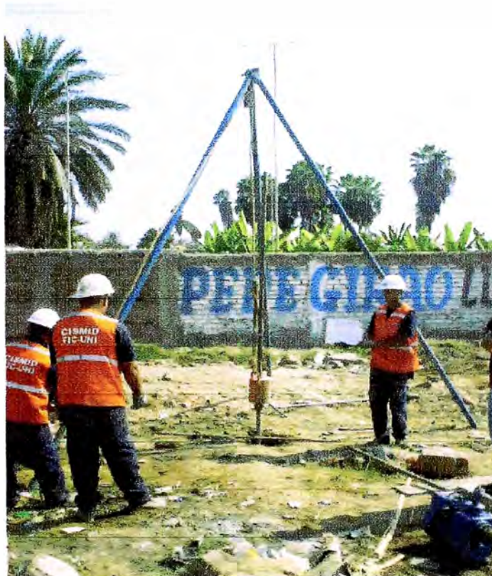
Foto 19; Perforación SPT S-7.
