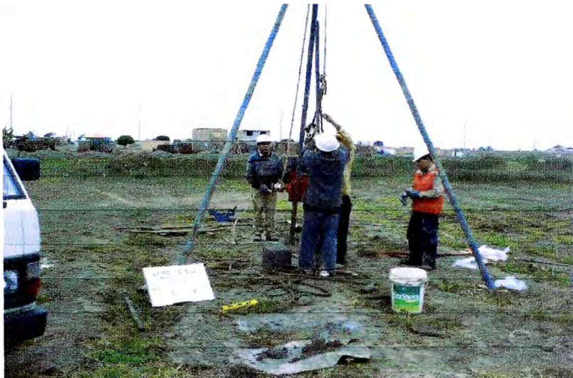
Foto 25; Perforación SPT S-18.
