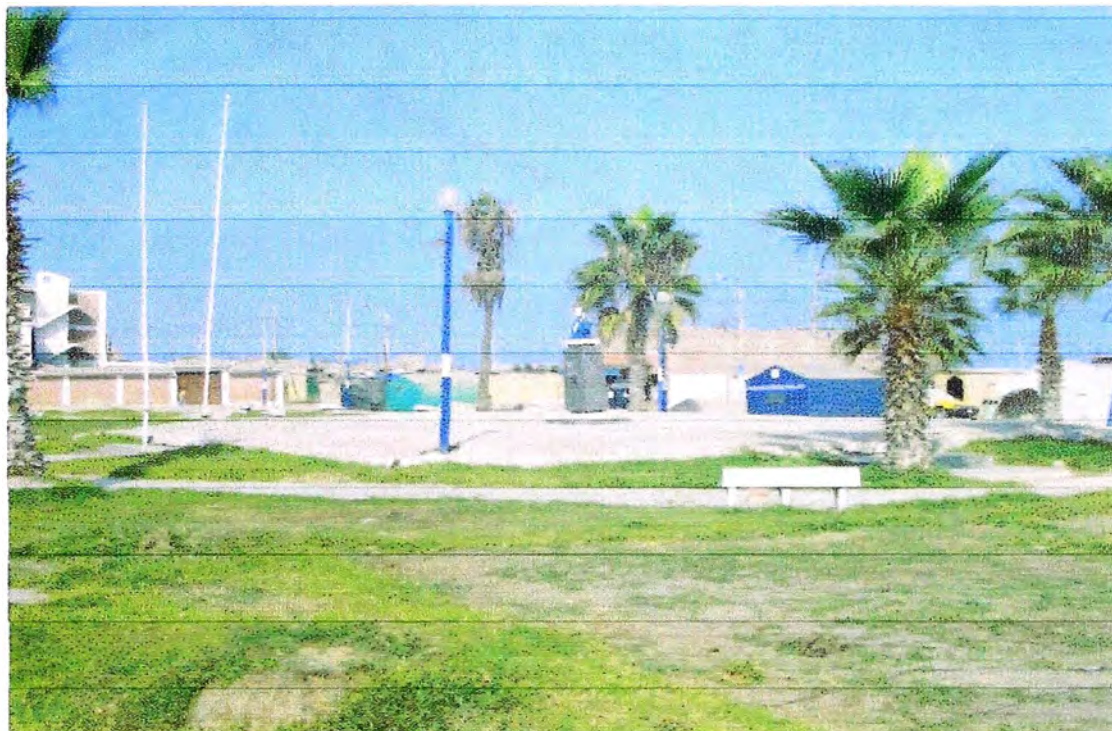
Foto 5; Plaza central de Tambo de Mora, también ubicada sobre suelo licuable.
