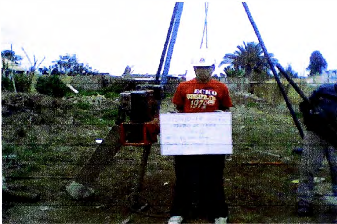
Foto 21; Perforación SPT S-12.
