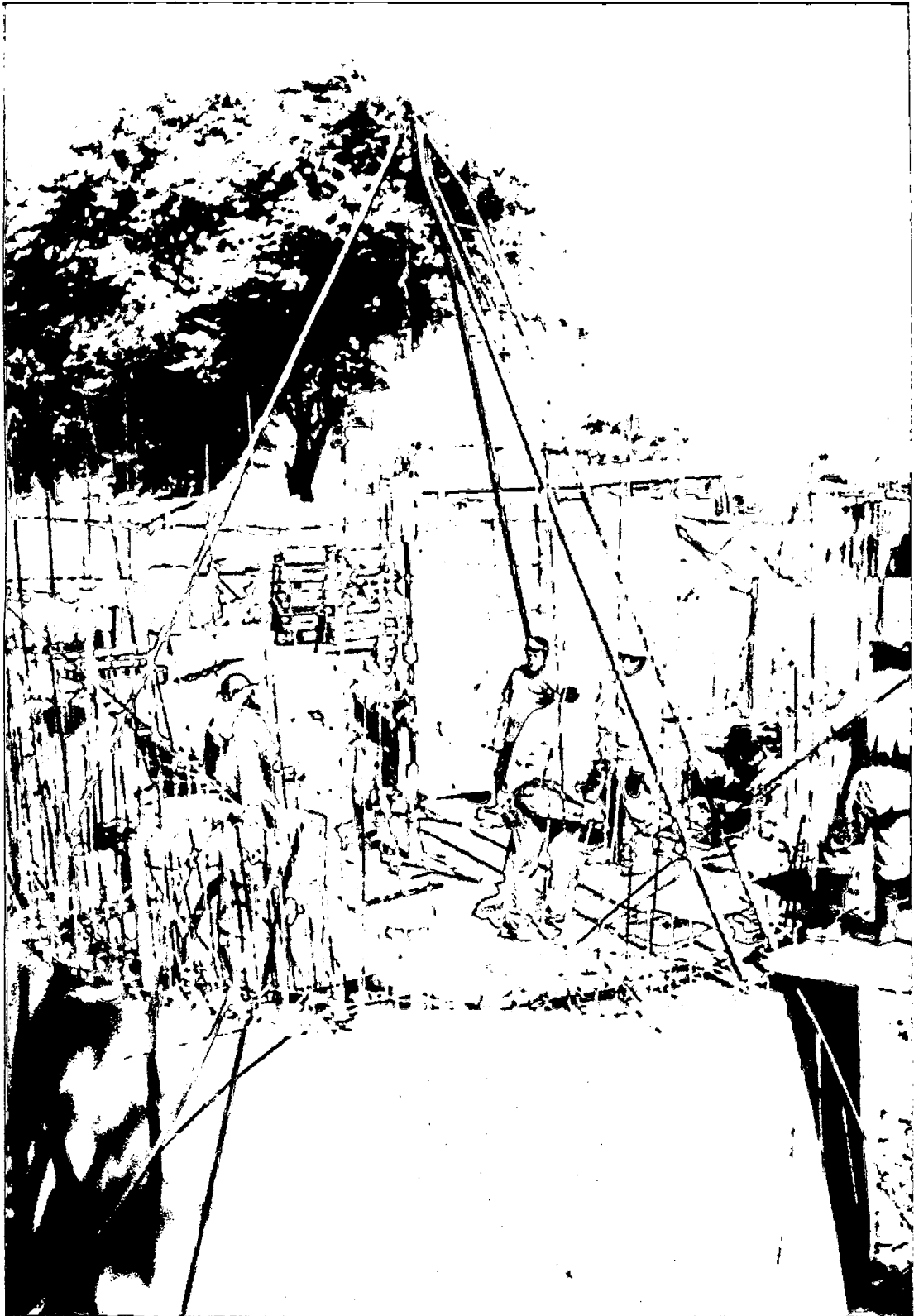
Foto N° 22 Realización de la prueba de Penetración Estandar (SPT), con cuyos resultados se realiza el estudio de factibilidad del hincado de los caissons.
