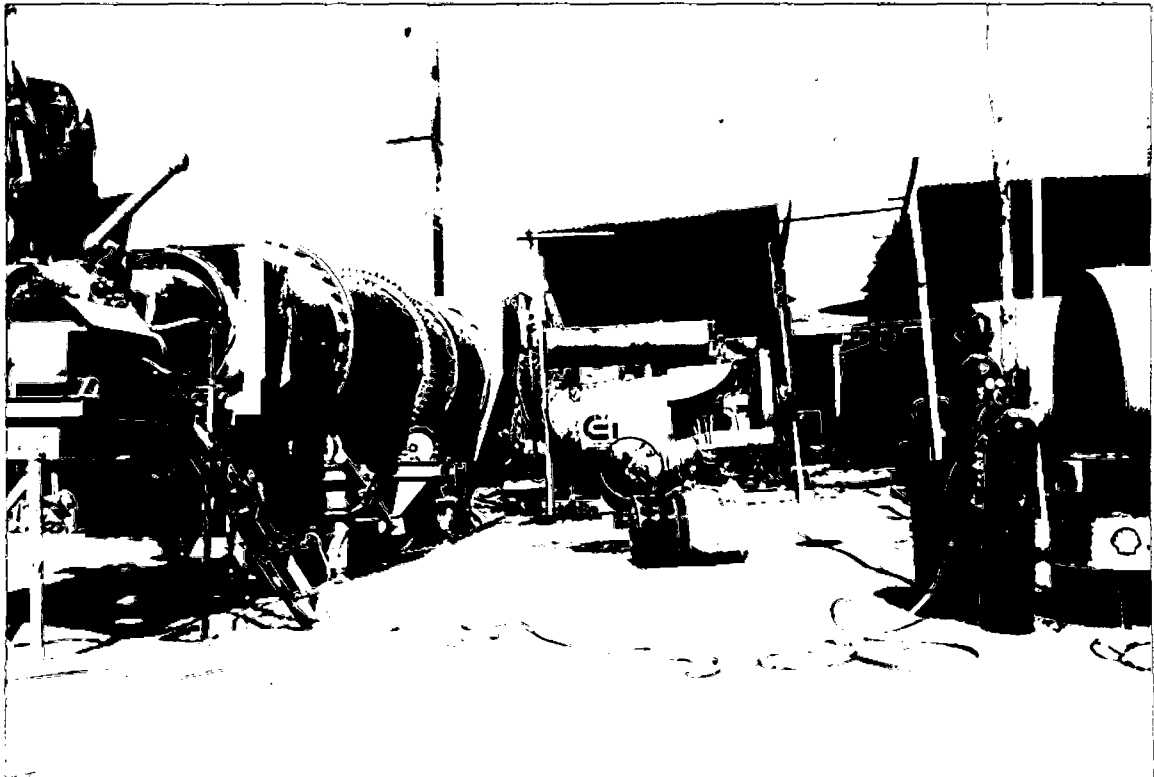
Foto N° 13– Se observa el drum mixer y los tanques de almacenamiento de asfalto de la planta asfáltica.
