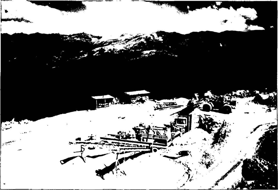
Foto N° 08 – Proceso de producción de agregados en la cantera Km 150+080.
