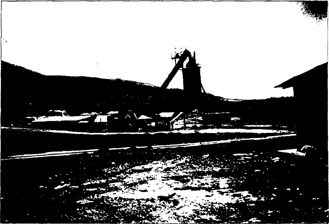
Foto N° 12 –Vista completa de la Planta de Asfalto tipo continuo.
