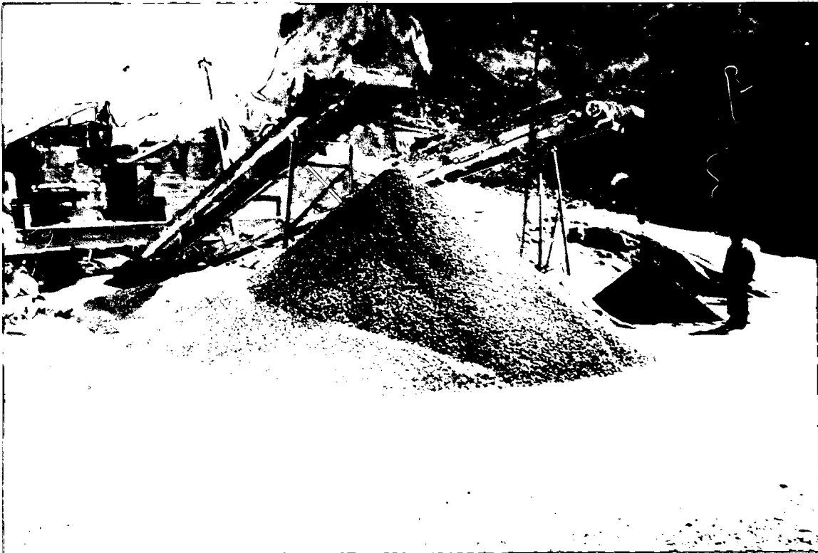
Foto N° 09 – Obtención del agregado grueso y fino en la chancadora secundaria.
