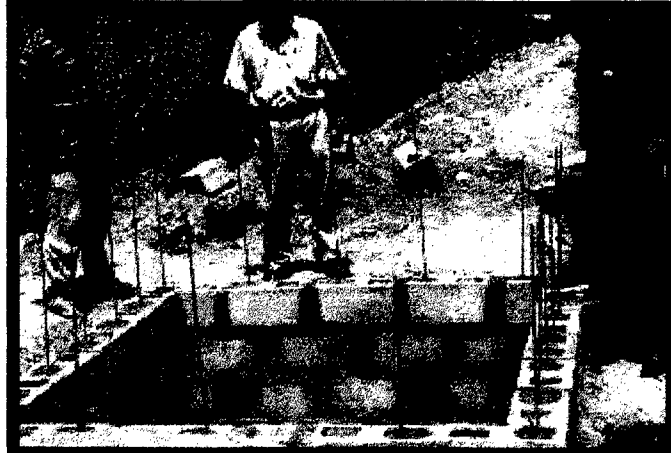
Construcción de "Poso Subterraneo" San Benito - Imperial - Cañete
