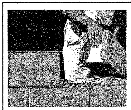
Fig. 1.19. Determinación de la altura de la hilada
