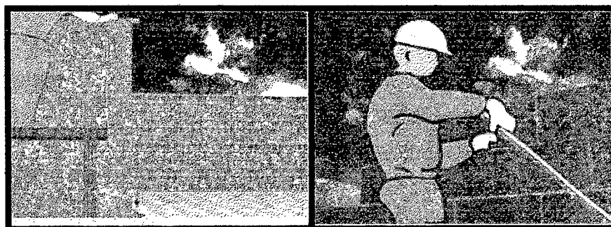
Fig. 7.15. Regla de Aluminio, usada para le verificación de la verticalidad al igual que el uso de la Plomada.
