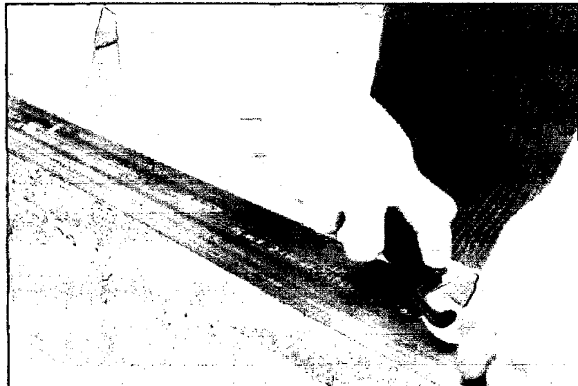
Foto 3.14 Rodillo para fijación de la platina de CFRP
