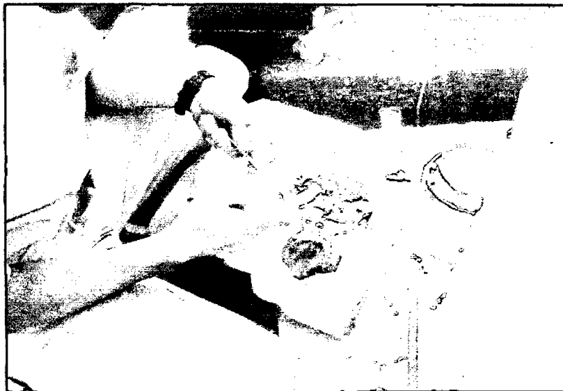
Foto 3.10 Preparación del adhesivo epóxico SIKADUR 30
