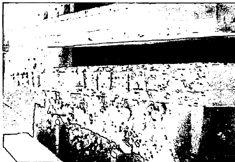
Foto 3.18 Viga sin recubrimiento para la posterior fijación de la platina de acero.
