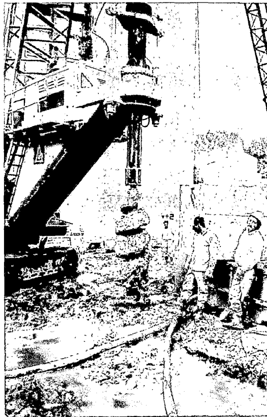
Segunda descarga del material excavado
