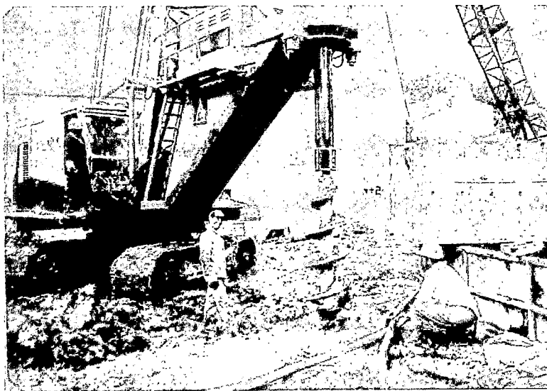
Centrado del taladro fuste donde se procederá al excavado del pilota preexcavado
