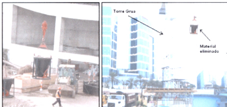
Fotografía 2.6 Segunda etapa de transporte del material excavado.
