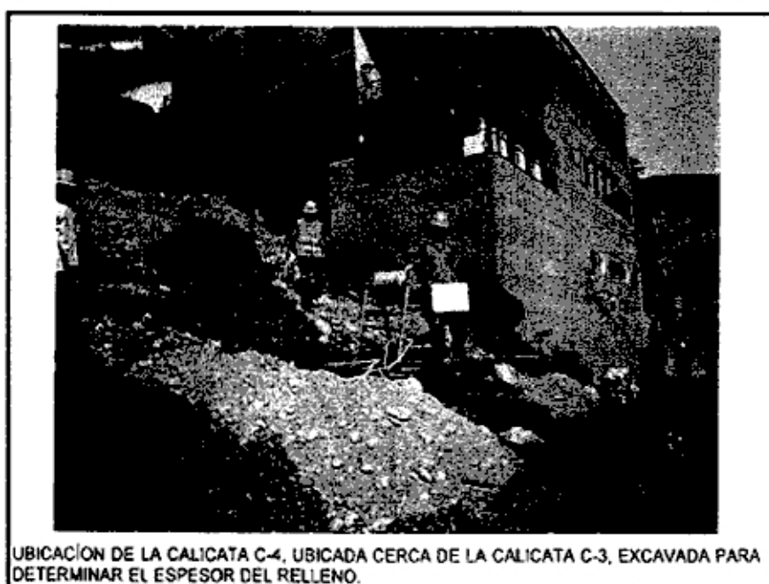
Fotografía 2.3. Ubicación de las calicatas en el talud del acantilado.
