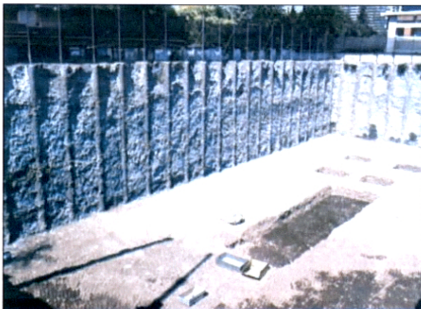
Fotografía 1.26: excavación profunda utilizando pilotes
