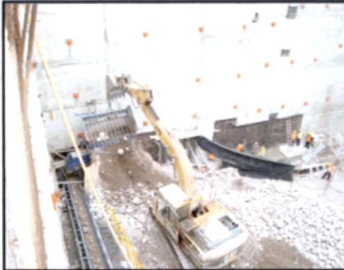
Foto 1.18 Ingresando material por el alimentador
