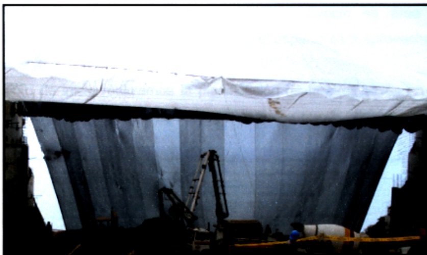
Fotografía 4.7 Instalación de la malla sintética sostenida por una viga metálica
