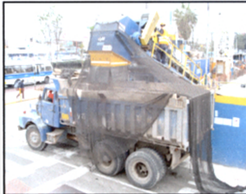
Foto 1.21 Descarga final del material excavado
