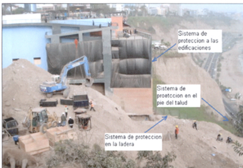
Fotografía 2.9 Sistema de protección utilizado en la excavación – Ampliación Larcomar
