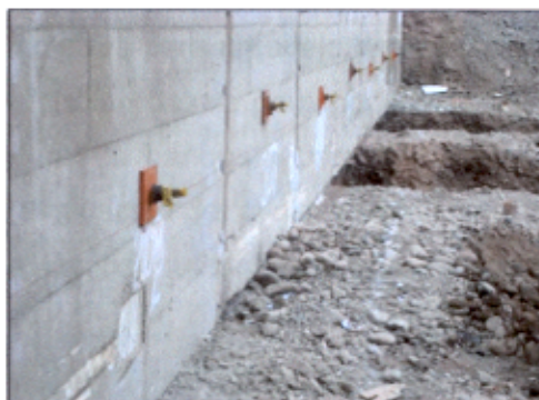
Foto 1.28 Banqueta: Edificio Capital
