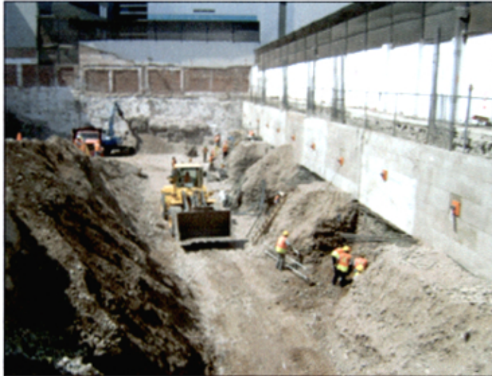
Fotografía 1.30 Distribución de banquetas y rampas
