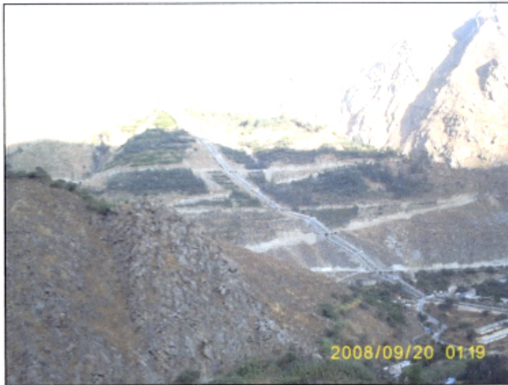
Foto 1.5. Proyecto Construcción de Abastecimiento de agua y generación de energía Lima – Perú (1)
