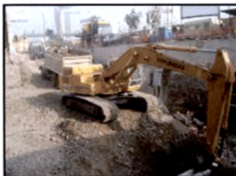
Foto 1.11, 1.12: Desarrollo intermedio de la rampa, utilizando excavadora y volquetes.
