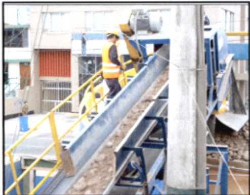
Foto 1.20 Control de la velocidad de descarga
