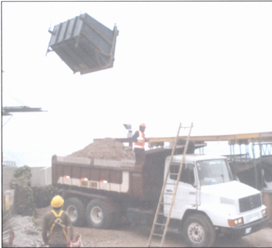
Fotografía 2.7 Tercera etapa vaciado del material excavado al camión de transporte.
