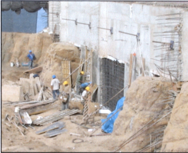
Fotografía 1.29. Excavación obra Construcción de Departamentos – Barranco 2008
