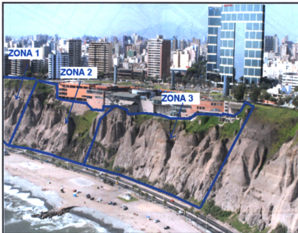
Figura 4.21 Sectorización del talud correspondiente al Centro comercial Larcomar
