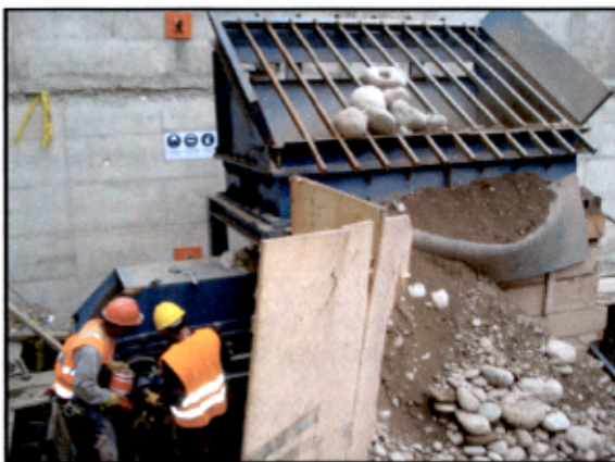
Foto 1.24 Mantenimiento del alimentador
