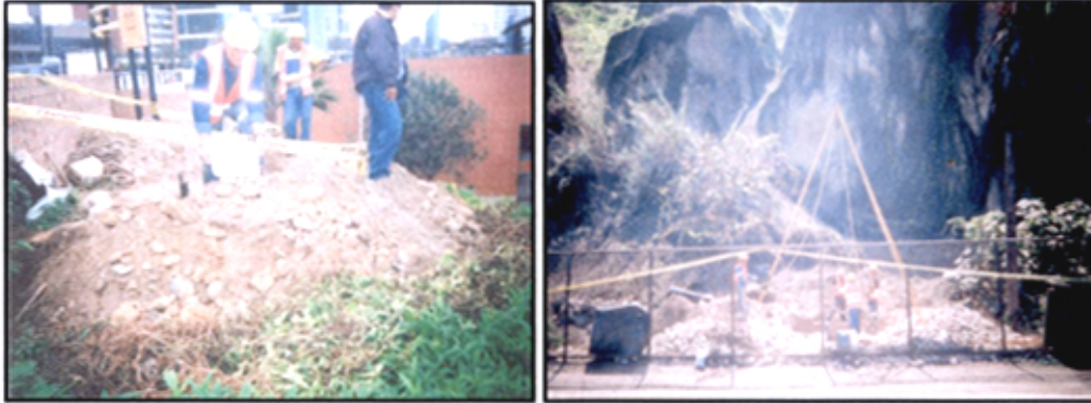
Fotografía 1.34 Ubicación de la calicata CH-1 Foto 1.35 Ejecución auscultación cono Peck CP-1
