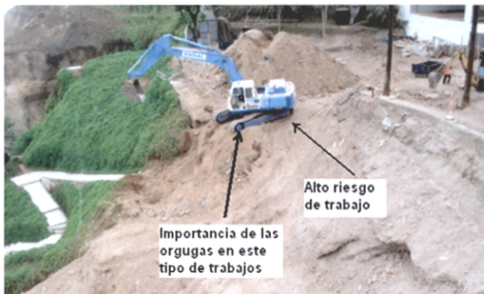
Fotografía 2.8. Importancia de excavadoras sobre orugas en el trabajo en el acantilado.
