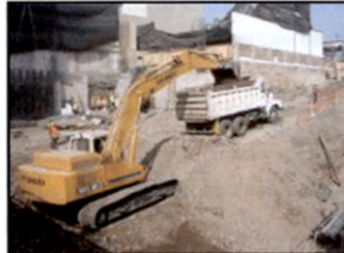
Foto 1.11, 1.12: Desarrollo intermedio de la rampa, utilizando excavadora y volquetes.
