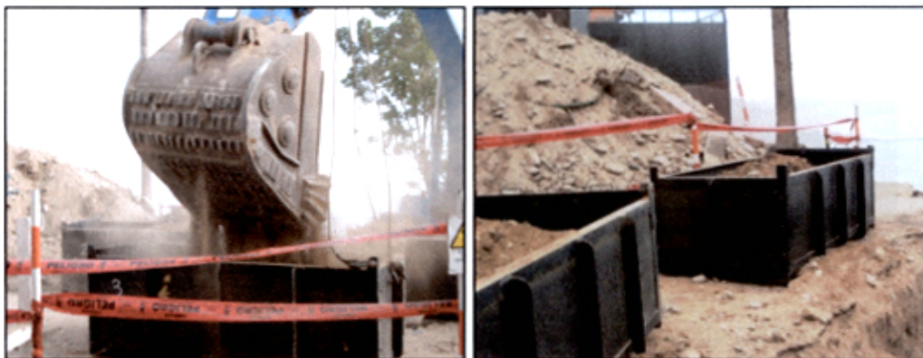
Fotografía 2.5 Primera etapa de llenado del material excavado.
