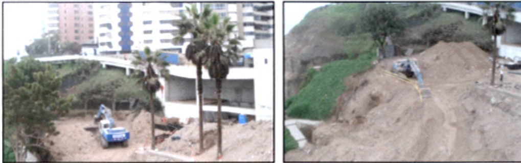
Fotografía 2.4 Acceso y forma de excavación en el acantilado.
