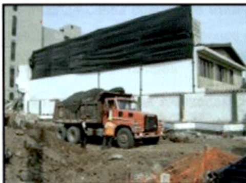
Fotografías 1.9, 1.10: Eliminación inicial de material para la formación de la rampa.
