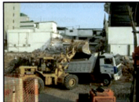
Fotografías 1.9, 1.10: Eliminación inicial de material para la formación de la rampa.
