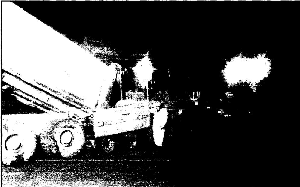
Figura 4.5 Esparcido de material granular (fuente propia)
