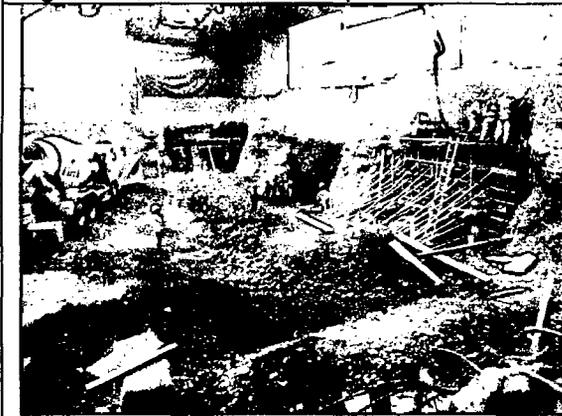
Figura 05, Ejecución de muros anclados
