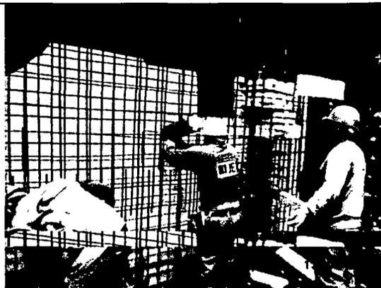
Figura 16, Colocacion de pases p anclaje
