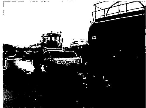
**Foto N° 13:** Nivelación de Base Granular
