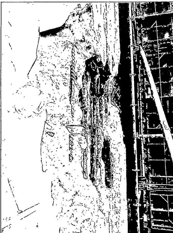
Figura 6: Ejemplo de corrosión combinada de carbonatos con cloruros – Cervecería Pilsen – Callao
