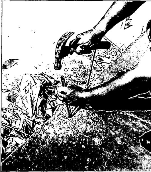
Figura 6.02. Picado de la superficie de concreto
