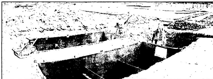
Figura 3.05 Trampas de grasa del sistema de drenaje
