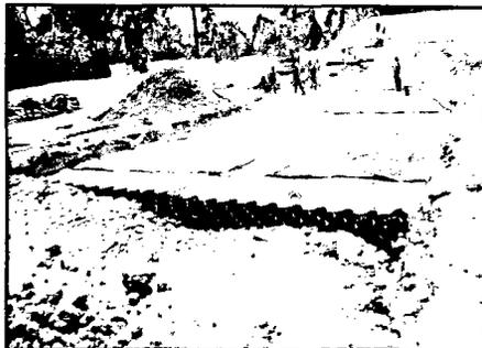
Figura 5.30 Relleno culminado de Geoweb (arcilla roja compactada)
