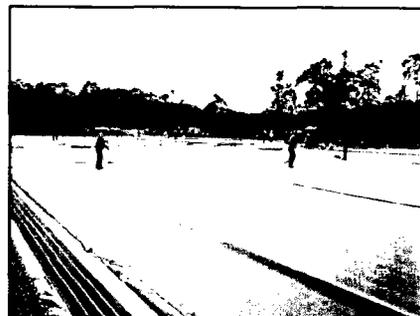
Figura 5.31 Instalación de Geomembrana de HDPE
