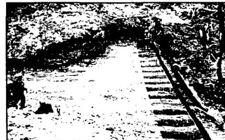
Figura 5.14 Colocación de geomalla y geotextil en relleno estructural.
