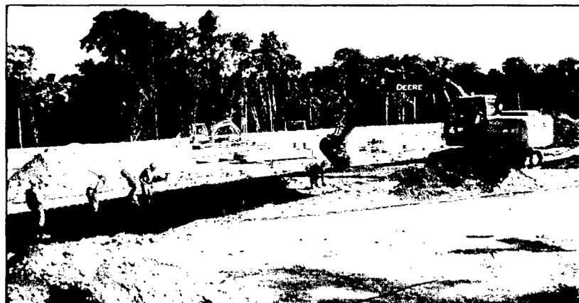
Figura 5.29 Relleno de Geoweb
