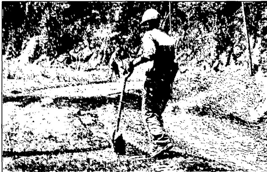
Figura N°2.12: Auxiliares realizando el retiro de bolonería para el compactado
