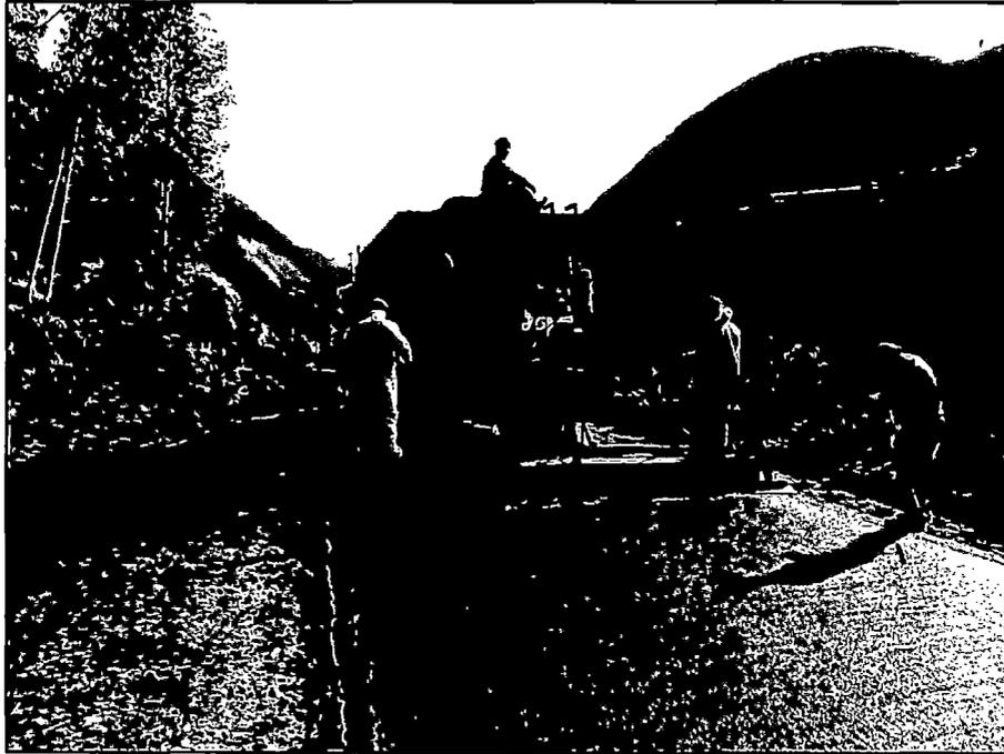
Figura N°2.16 Esparcido de slurry sobre el terreno
