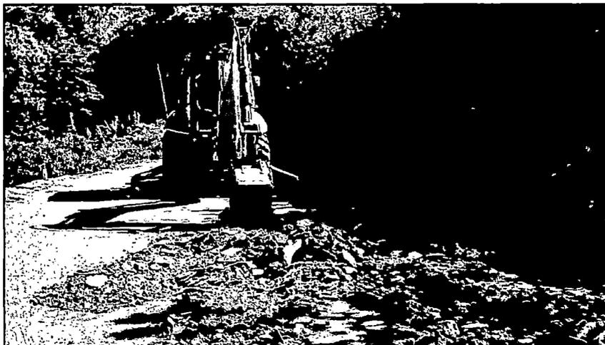
Figura N°5.5. Retiro de capa de Slurry utilizando retroexcavadora
