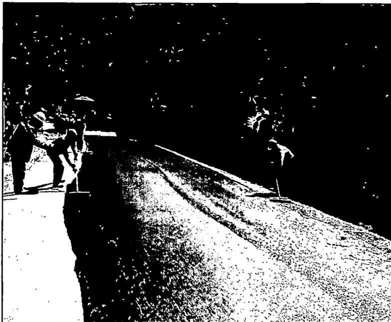
Figura N°1.11: Trabajo de personal de piso en colocación de Slurry Seal
