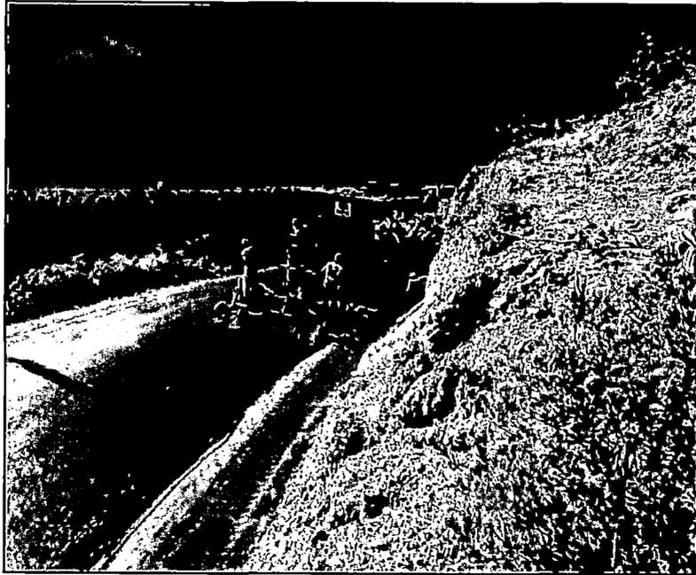
Figura N°1.10: Colocación de slurry seal utilizando Camión distribuidor de Slurry
