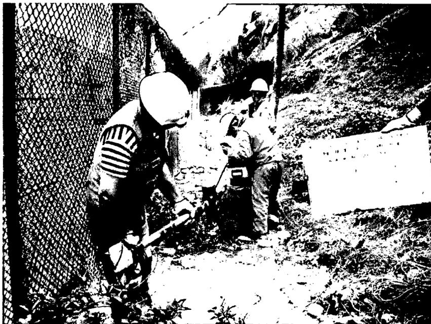
**Fotografía 18:** Momentos del impacto correspondiente al Shot 04, empleado para la generación de ondas sísmicas del sondaje sísmico LW-11.
