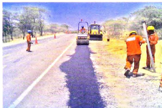
Rodillo compactando el área parchada
