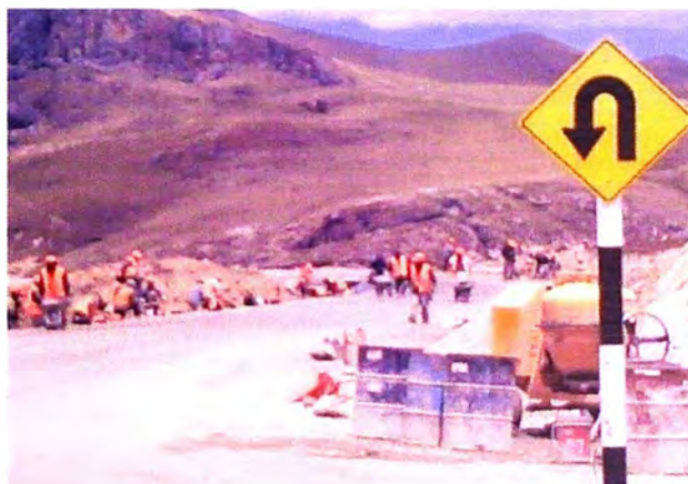
Personal construyendo las cunetas por el tramo final de la obra, a más de 4000 m.s.n.m.
