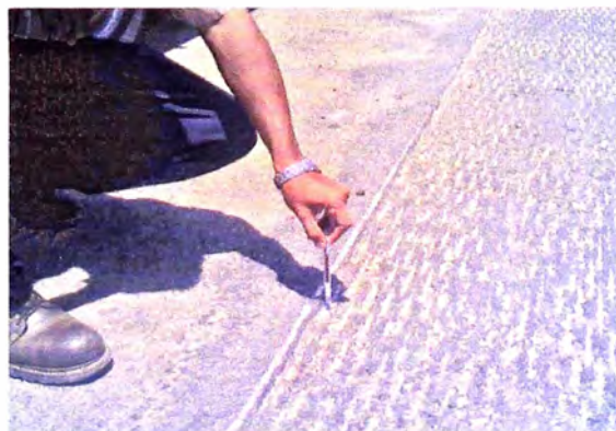
Fresado de 1cm de la carpeta, por causa de exudación en la calzada
