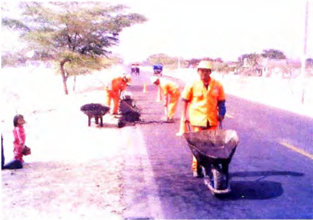
Personal de la PYME EMICAR parchando el borde de la calzada y trasladando la mezcla
