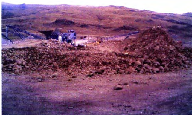
Chancadora preparando el material a ser usado tanto en las cunetas como en los tratamientos
