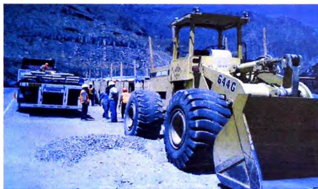
Campamento en la Prog. 72+450 Ruta Nacional 014. Tramo Pativilca-Conochocha. Sector Chucchus
