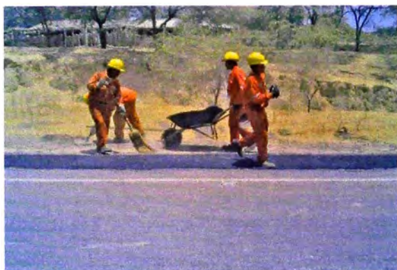
Personal parchando los bordes de la berma
