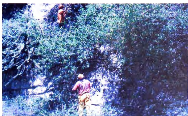
Rocería de los taludes
