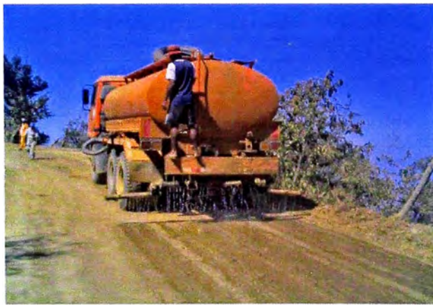
Paso de la Cisterna, con el objetivo de darle la humedad necesaria al material granular
