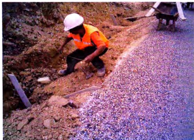
Trabajador verificando las dimensiones que deberá tener la cuneta.
