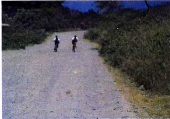
Ruta 002A, cerca a Canchaque, Prog 067+00, vía afirmada
