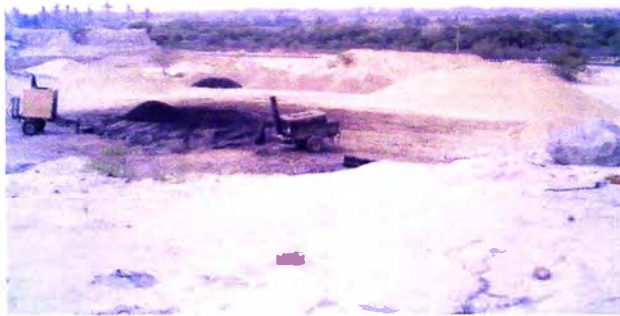
Campamento, en donde se prepara la mezcla en frío, para ser transportada a las áreas a reparar
