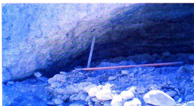
Socavación producida por el cauce del río Fortaleza a la altura del campamento
