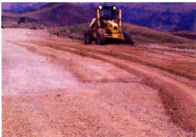
Motoniveladora extendiendo del material granular que recibirá el tratamiento superficial
