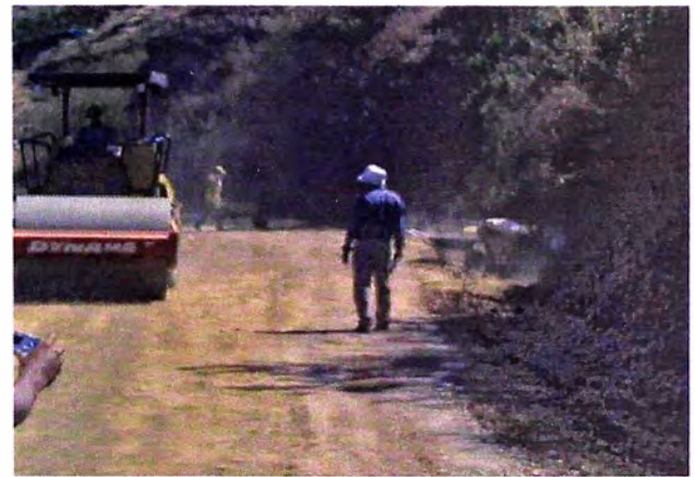
Rodillo, realizando la compactación
