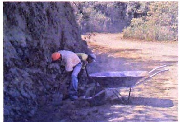
Personal dando el acabado final a las cunetas
