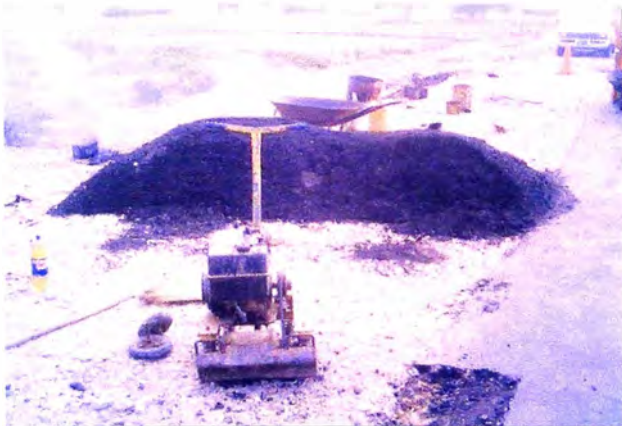
Mezcla C/RC-250 que se utilizará para parchar el borde de la calzada
