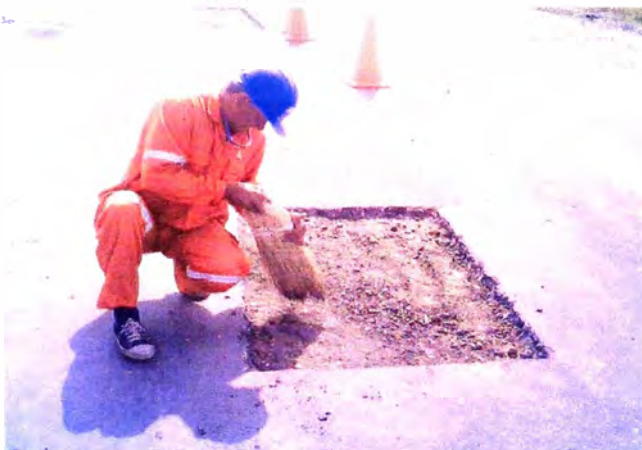
Limpiando el área picada previa a ser reparada
