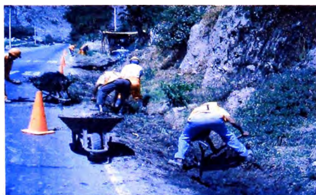
Limpieza de cunetas
