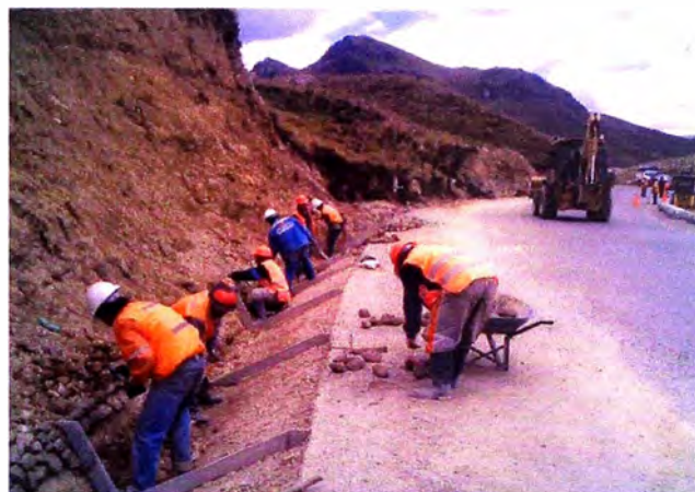
Personal preparando el encofrado de las cunetas
