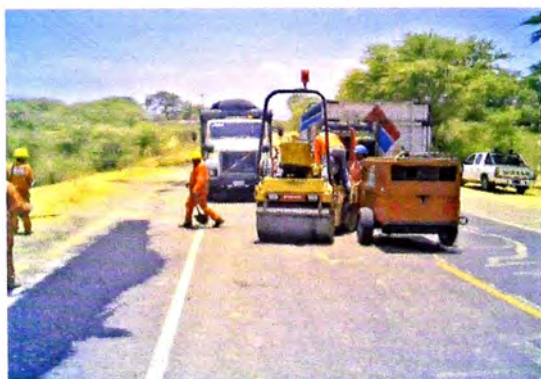
Maquinaria utilizada en los trabajos de Mantenimiento
