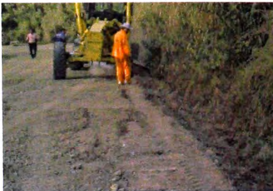
Motoniveladora trabajando la cuneta
