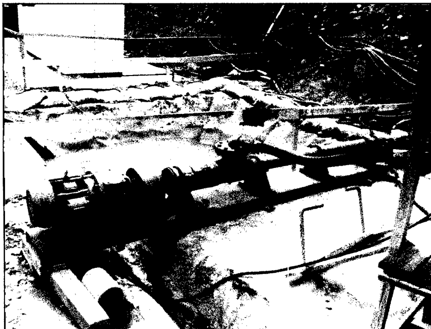
Bomba de inyección Moyno
