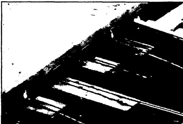
*Figura 5. 7: Acero positivo de Losa convencional*
