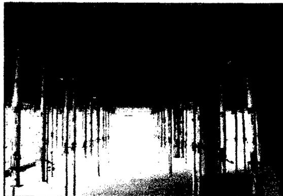
Figura 5. 1: Encofrado de Losa convencional
