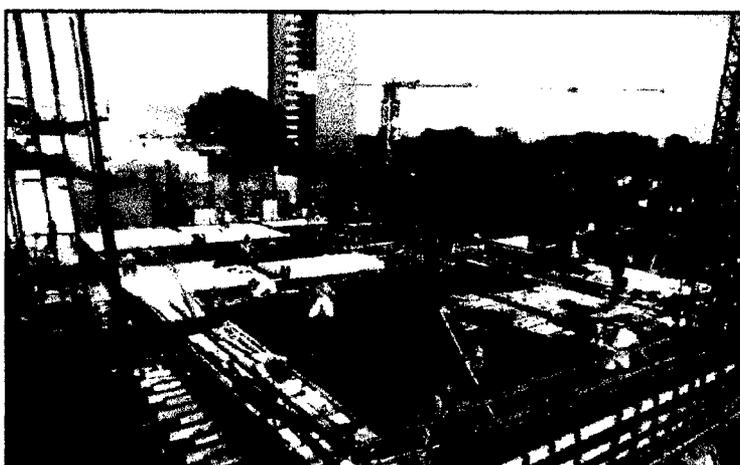
Figura 3. 35: Vaciado de prelasas
