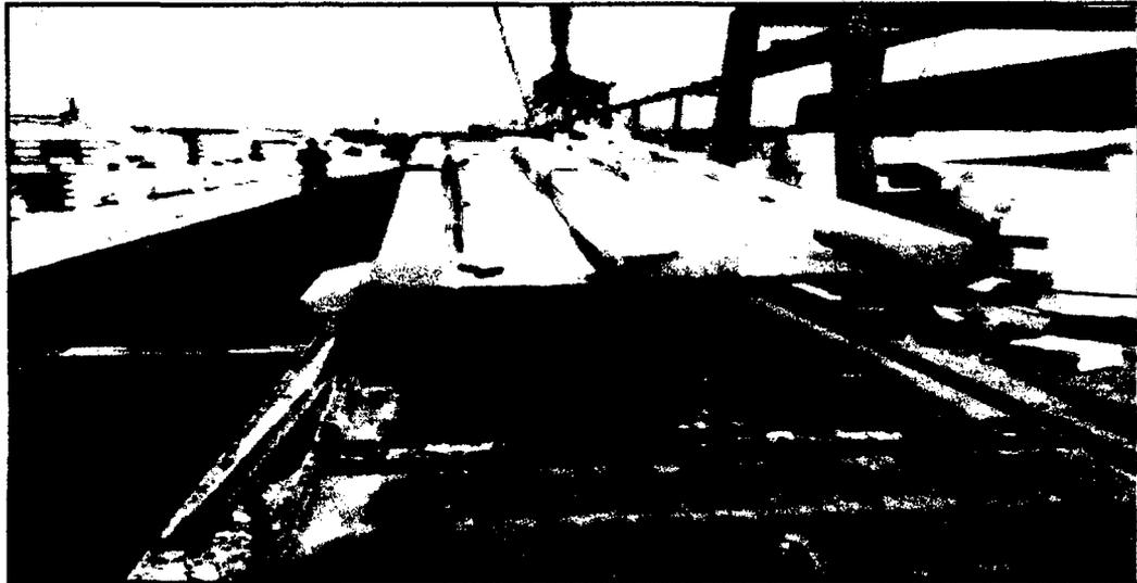
*Figura 2. 7: Desmoldaje de prelosa*
