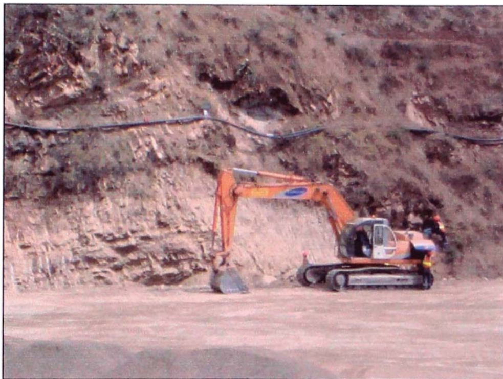
FOTO 17. Excavadora, realizando trabajos de limpieza del estribo derecho.
