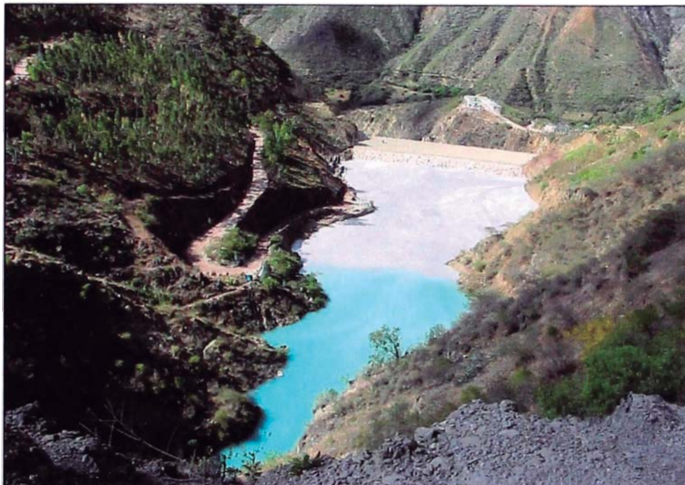
FOTO 1. Vista Panorámica de la Presa de Relaves de Alpamarca, fue construida para depositar relaves del proceso de flotación.
