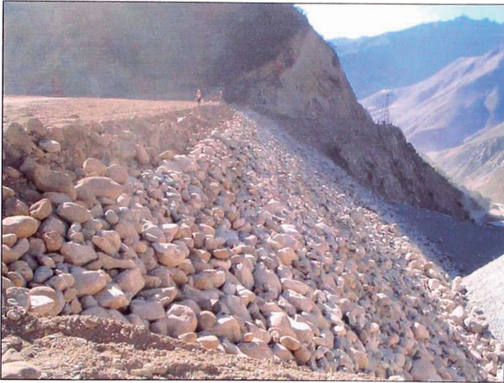
FOTO 13. En esta fotografía se puede observar como queda el espaldón de la presa, una vez colocado el RIP RAP.
