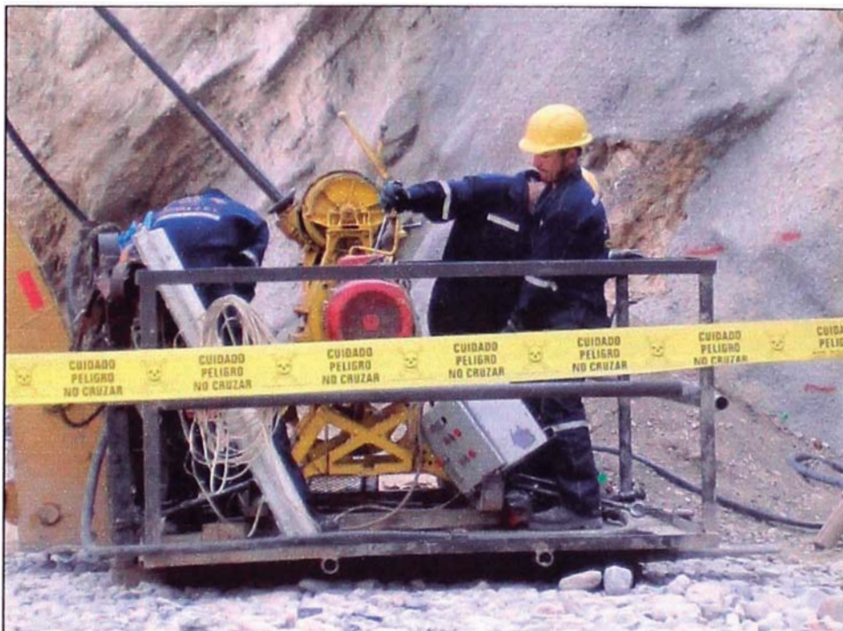
FOTO 20. En la canastilla de la grúa se colocaba el equipo de perforación y el personal que lo iba a realizar.
