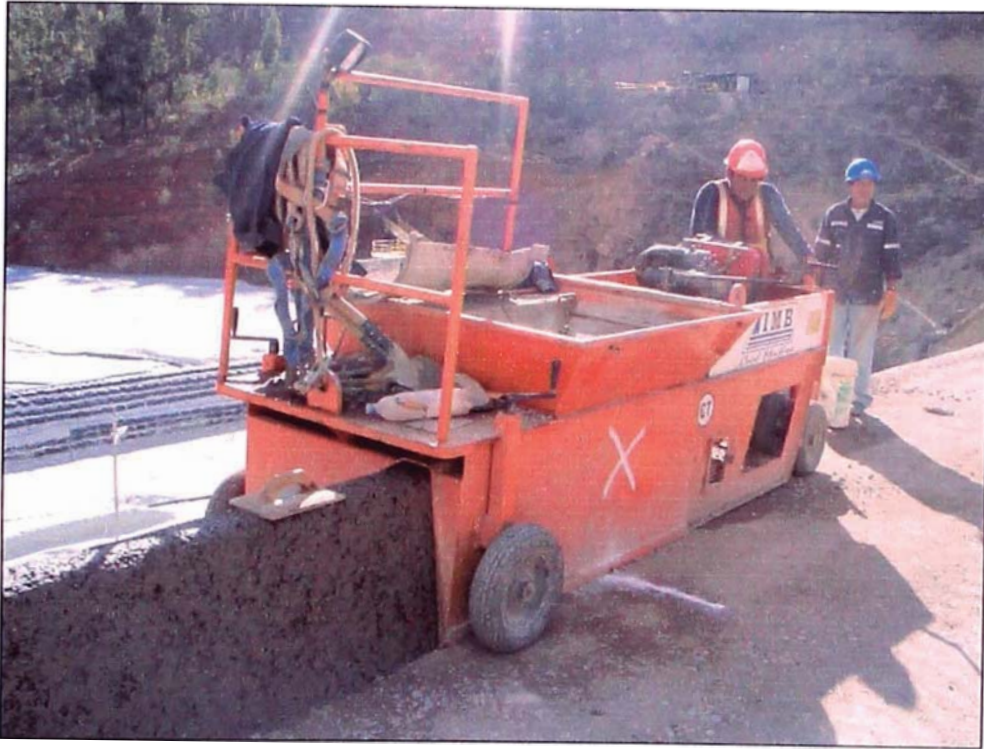
FOTO 25. Maquina Extrudadora, con lo cual se podía colocar el concreto con la rapidez deseada.
