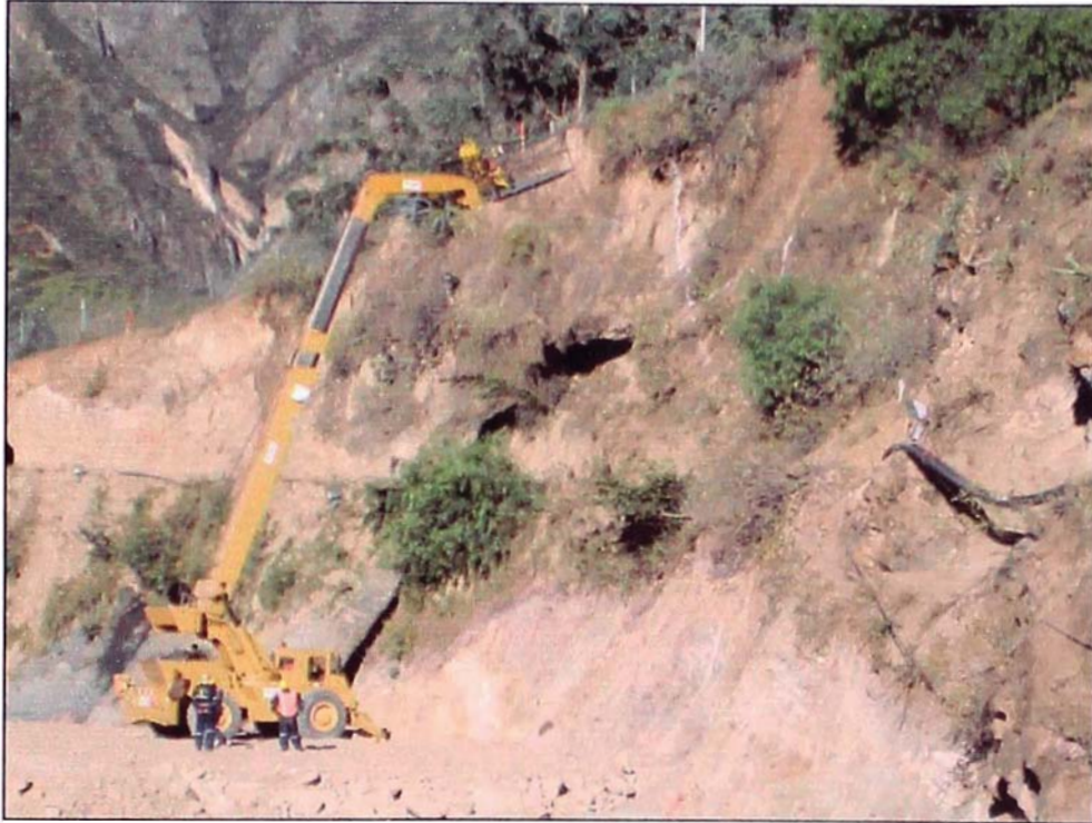
FOTO 21. Brazo levantado de la grúa alcanzado el objetivo a inyectar.
