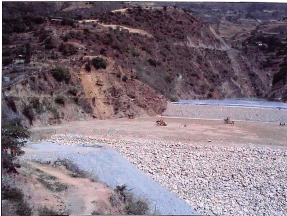
FOTO 6. Equipos Trabajando en la conformación del cuerpo de la presa.
