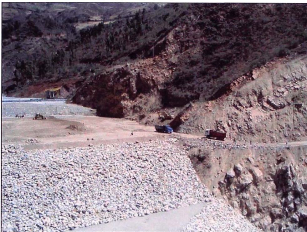
FOTO 9. Para tener los frentes operativos, el transporte de los materiales de préstamo se realizaban de tal manera que en el turno del día, se transportaba todos los que conforman el cuerpo de presa, dejando para el turno noche el transporte masivo de grava.
