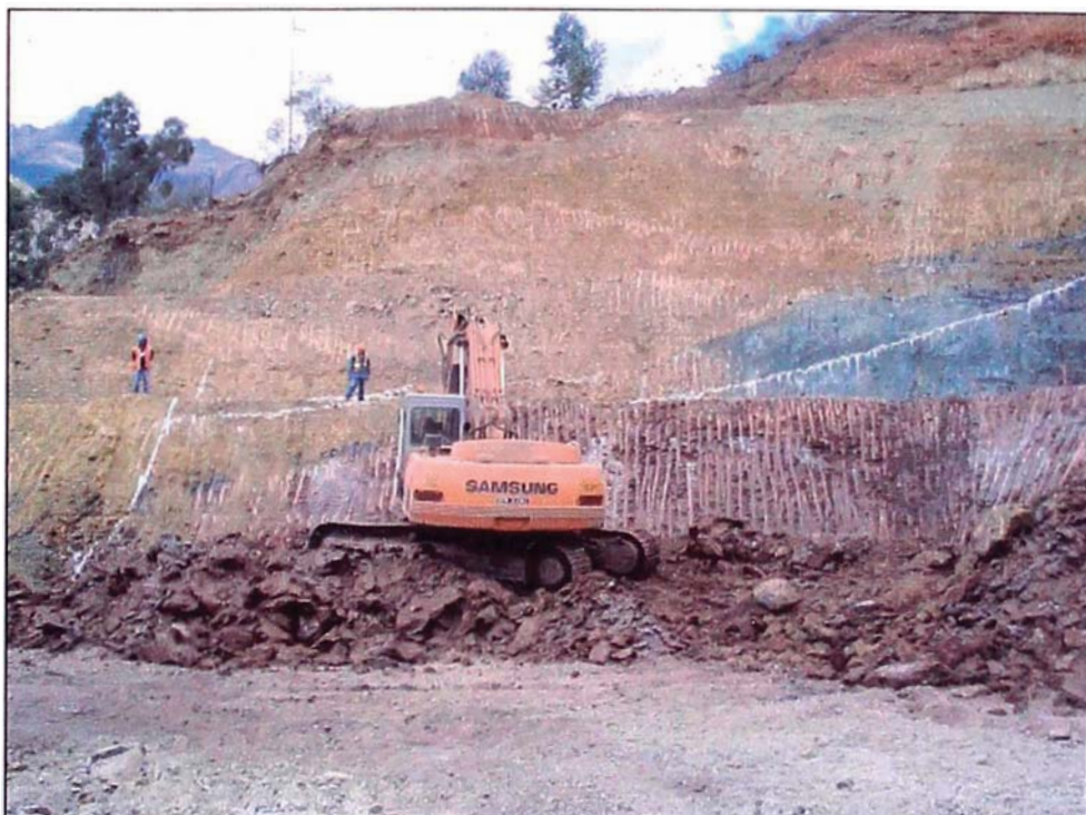
FOTO 18. El Objetivo de la limpieza era eliminar la tierra vegetal y orientar los puntos de agua que afloraban a la superficie.
