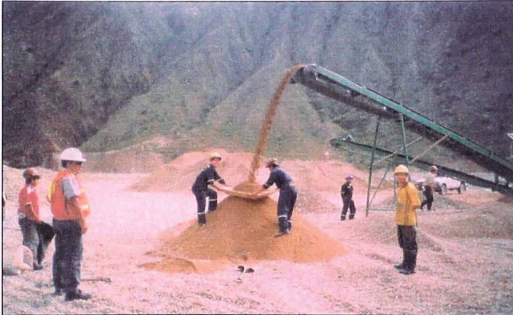
FOTO 31. En esta vista se puede apreciar como se obtenía el filtro en la zaranda eléctrica de Piaz.
