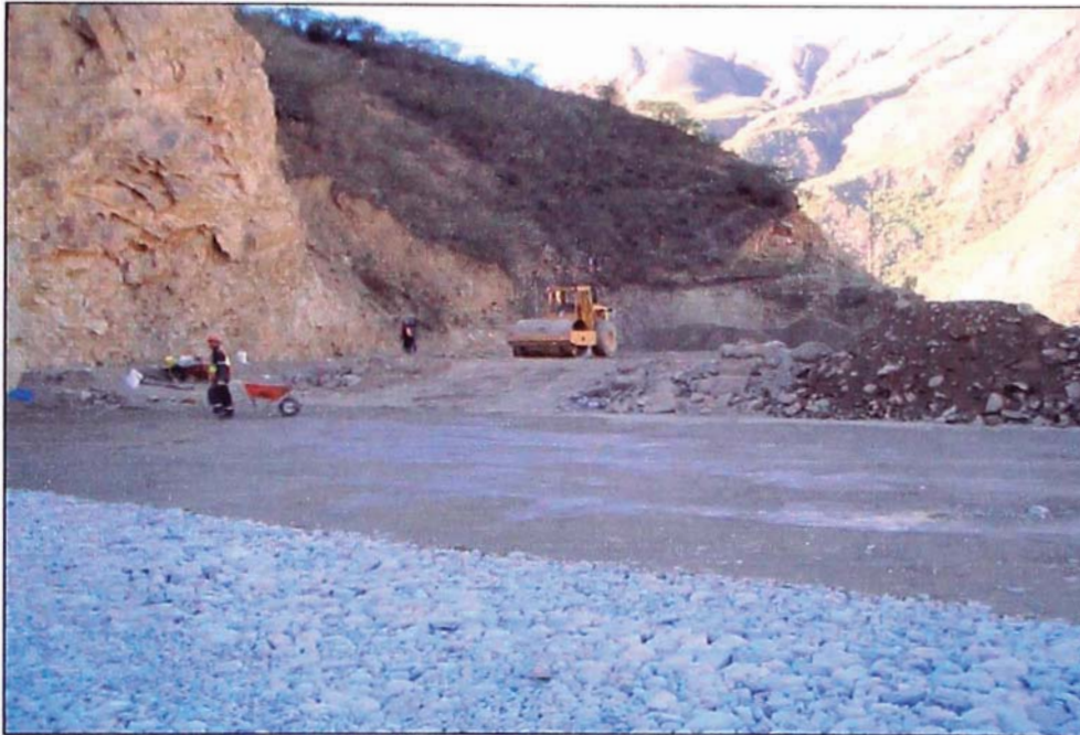
FOTO 11. Se aprecia Rodillo compactando el acceso a la presa, lo cual da una mejor fluidez al tránsito.
