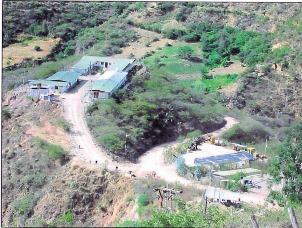
FOTO 5. Campamento de Matibamba, es donde se concentro al personal que trabajaba en la Presa de Relaves.
