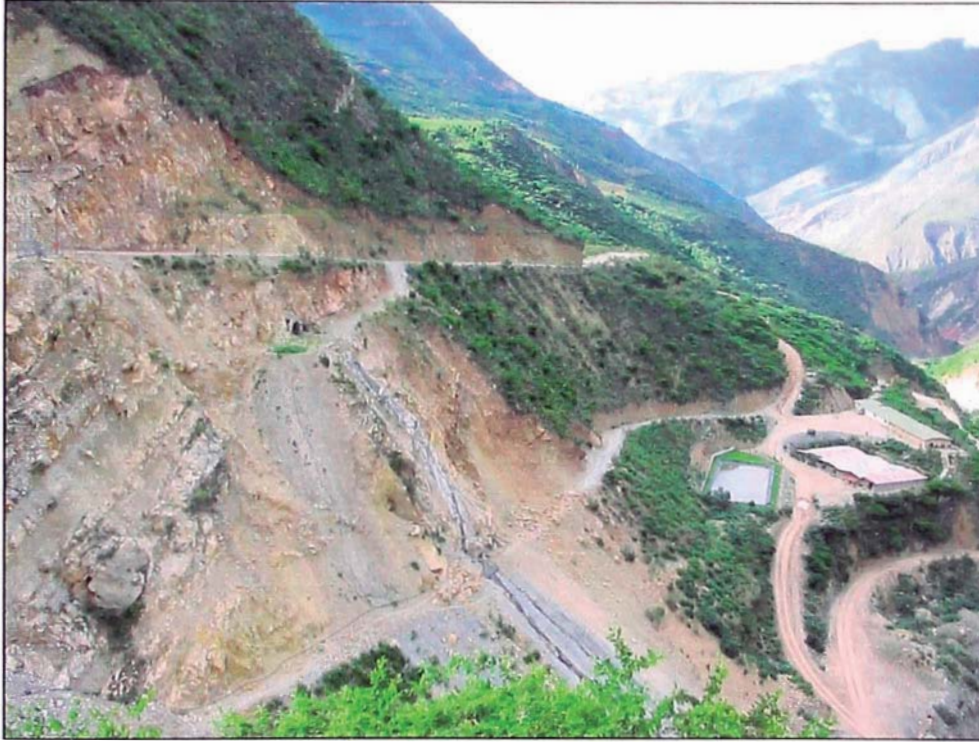
FOTO 3. Los accesos fueron construidos antes de iniciar el grueso de las obras en la presa, y fueron modificados conforme aumentaba la altura de la presa.
