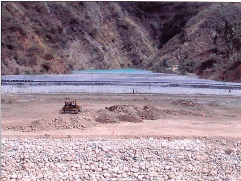
FOTO 8. Se puede observar al Tractor D-8 trabajando en la conformación de la capa de grava, la cual es aproximadamente de un espesor de 0.50 m.
