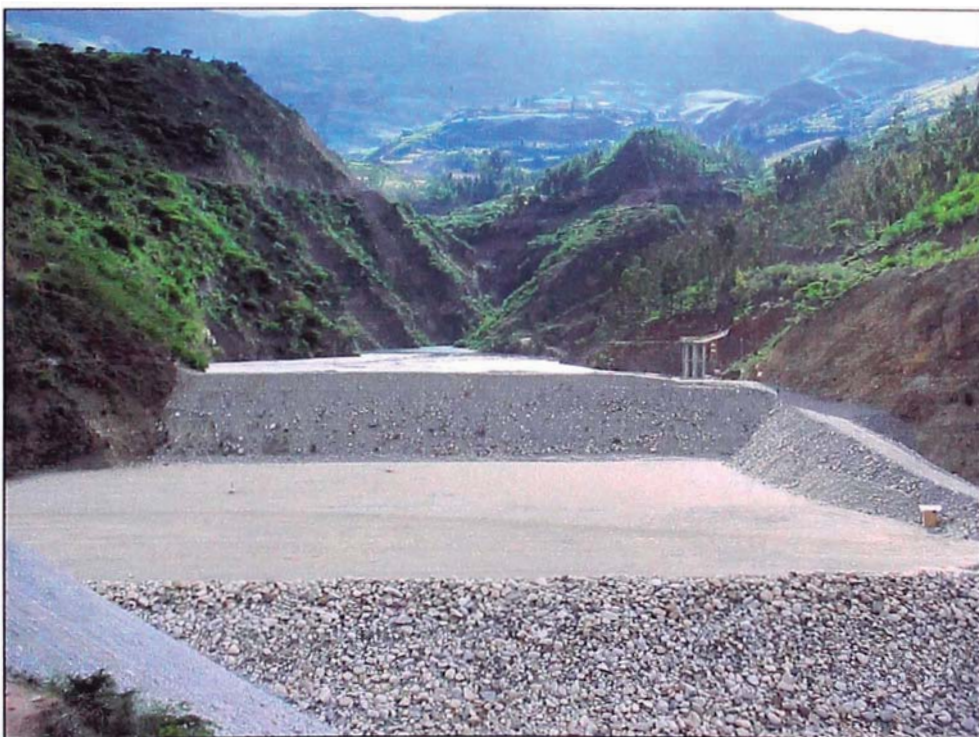
FOTO 2. El cuerpo de la Presa de relaves de Alpamarca esta constituido por material de préstamo proveniente de canteras.
