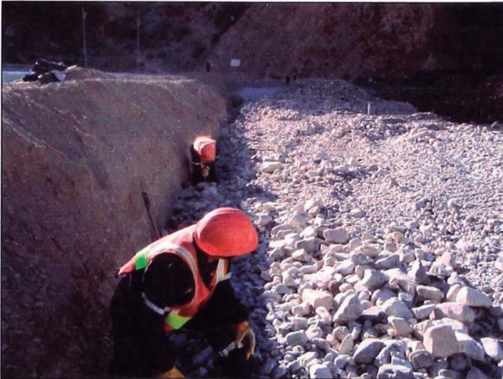
FOTO 15. La colocación del dren en el contacto con la grava se realizó en forma manual, de esta manera no se contaminaba el material a colocar.
