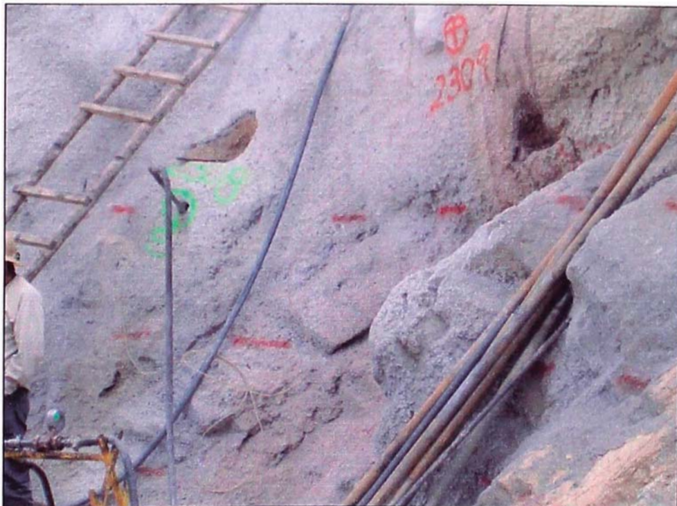
FOTO 22. Malla de perforación, la cual fue determinada por el tipo de roca y los esfuerzos a que iba a estar sometido la roca.
