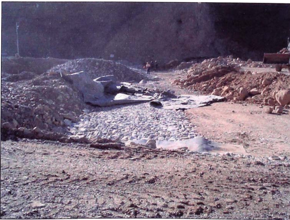
FOTO 14. Colocación del dren en el cuerpo de la presa.
