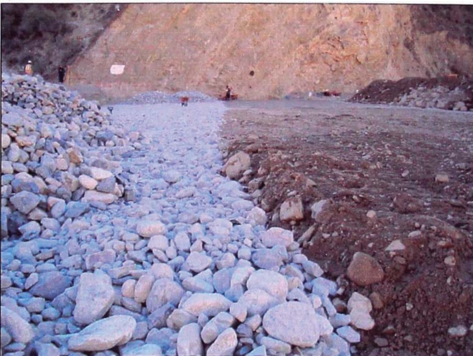
FOTO 16. El dren en el proceso de clasificación era lavado en el río Yuracyacu para eliminar los finos.
