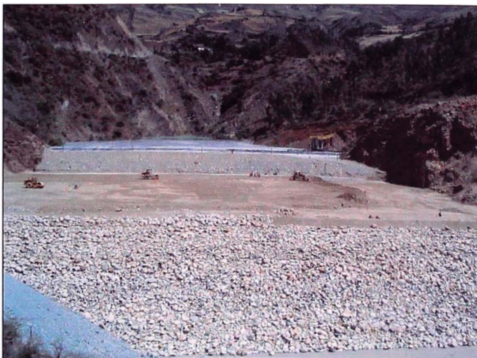
FOTO 10. En esta imagen se puede observar a los equipos trabajando en la conformación de la capa, Tractor D8 y 2 Rodillos.
