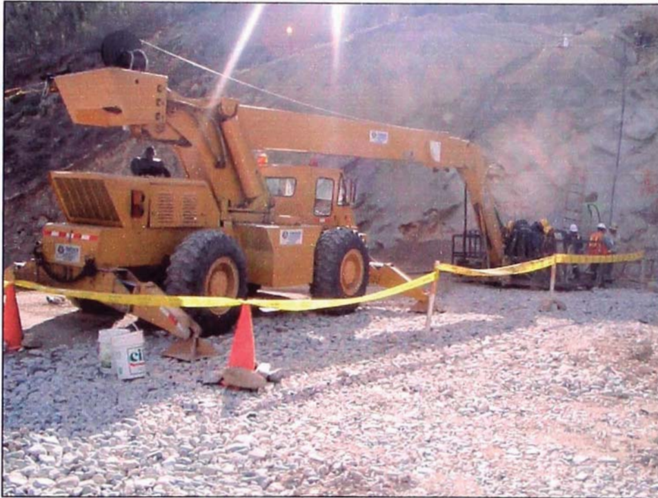
FOTO 19. Para realizar los trabajos de Inyecciones se utilizo una grúa portátil.
