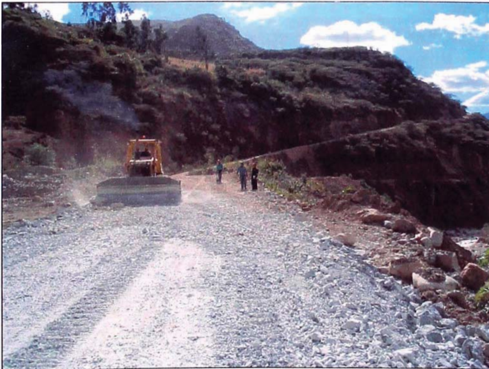
FOTO 4. Tractor D6, trabajando en la habilitación de los accesos.
