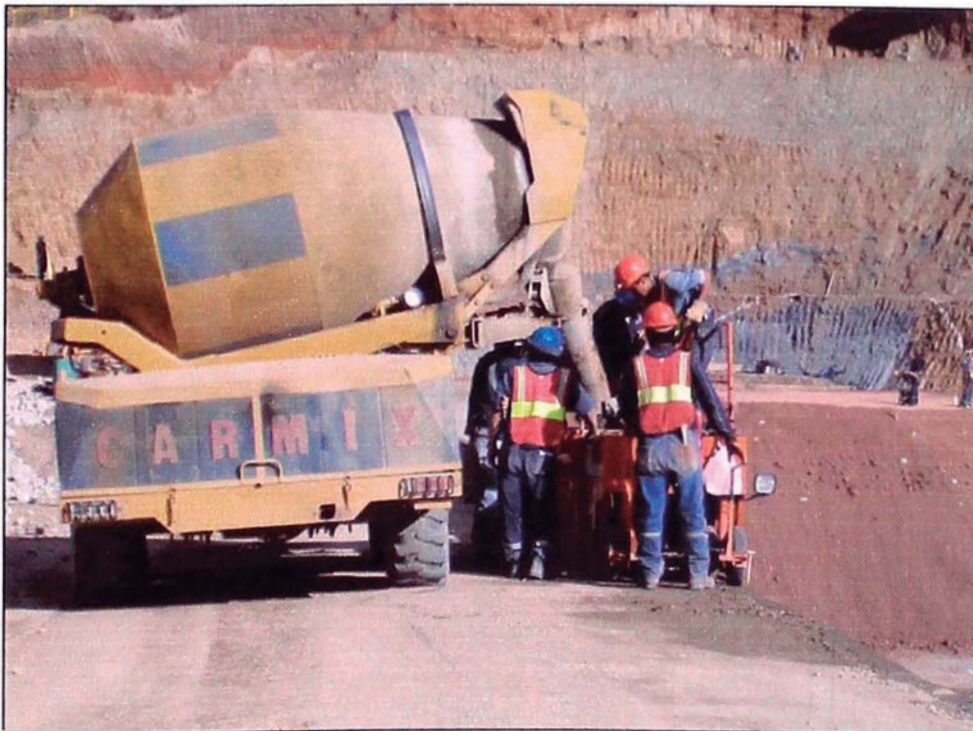
FOTO 24. Colocación del concreto extrudado en el espaldon de la presa.
