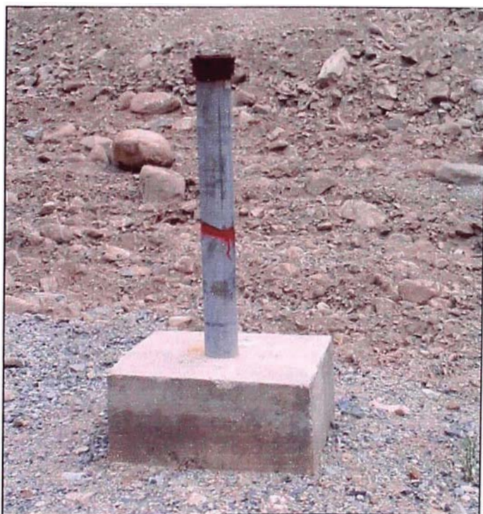
FOTO 28. Una vez terminado los trabajos de conformación de la presa se protegía los piezómetros en la forma que se visualiza.
