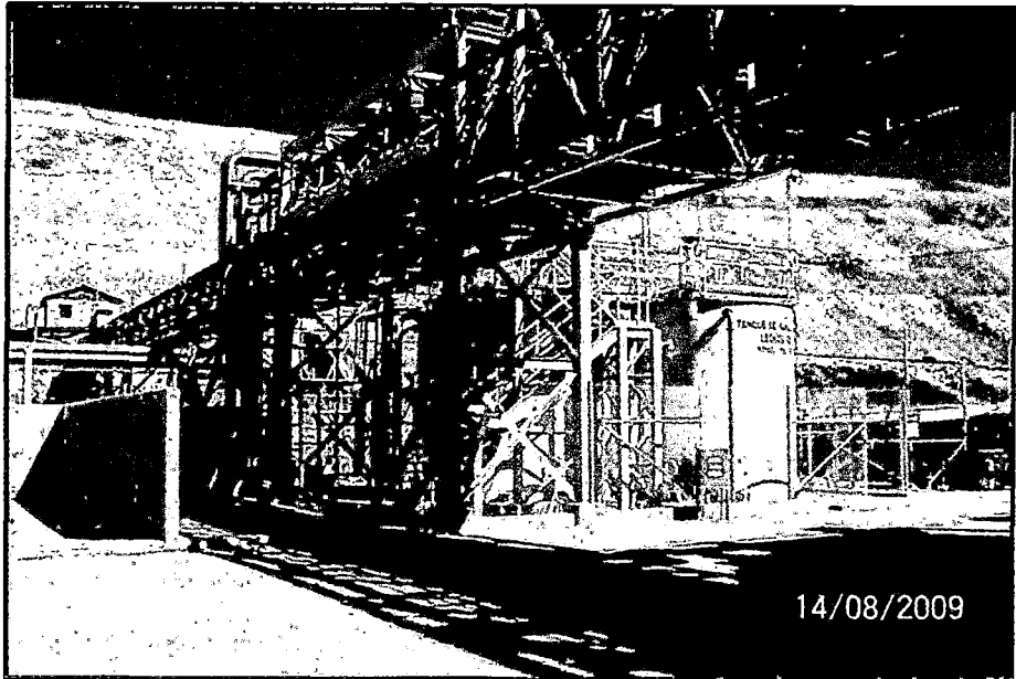
Figura 13: Líneas de lechada de cal - Zona Este
