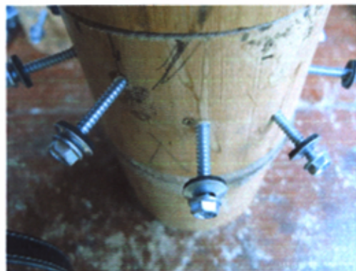
Fotografía N°.4.33 y N°.4.34: Tornillos auto roscantes de 1.5" y colocación helicoidal.
