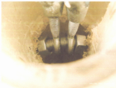
Fotografía N°.4.12 y N°.4.13: Deformación apreciada en perno transversal de \frac{1}{2} " de aproximadamente 1 cm.
