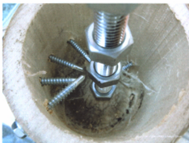
Fotografía N°.4.35 y N°.4.36: Colocación de perno interior y tornillos auto roscantes.
