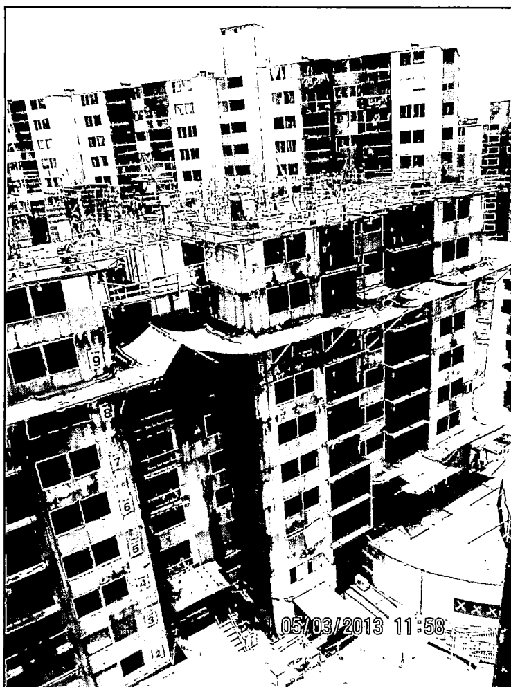
Figura N°2.13 Construcción de edificio de 15 pisos. Parque Central Club Residencial
