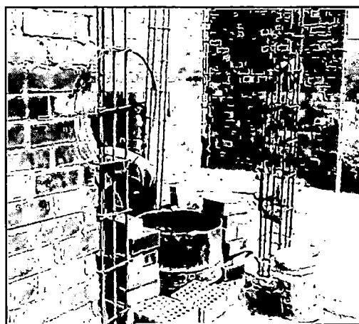
Figura N°2.6 Albañilería confinada.
