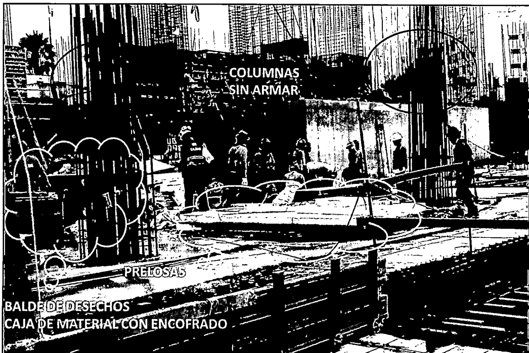
Figura N°5.22 Estado inicial de la obra Leuro.
