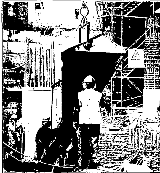
Figura N°3.17 Vaciado de concreto en Edificio Corporativo GyM.
