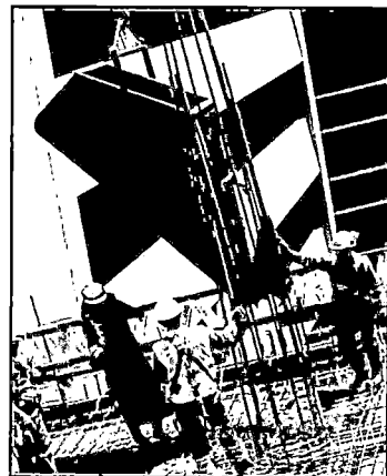
Figura N°4.28: Cuadrilla vaciando concreto Fuente: Fotografía tomada en obra
