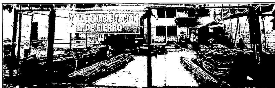
Figura N°4.1 Zona de habilitación de acero. Parques de San Martín
