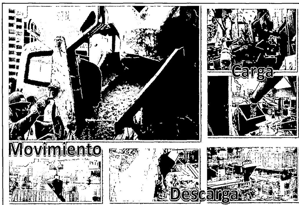
Figura N°5.28 Esquema para el proceso de vaciado de concreto en la obra Leuro.
