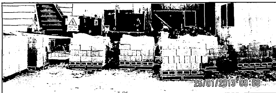
Figura N°4.5 Bloques de concreto. Parques de San Martín
