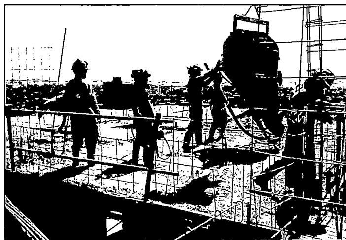
Figura N°4.26 Cuadrilla de vaciado en la zona de producción
