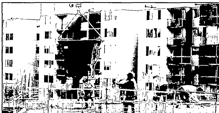
Figura N° 4.32: Cuadrilla de vaciado en la zona de producción.
