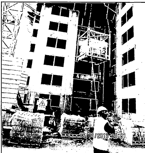
Figura N°4.6 Traslado de bloques de concreto. Parques de San Martín
