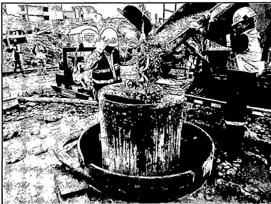
Figura N°5.17: Vaciado del pilote
