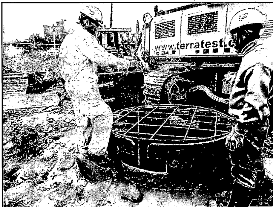
Figura N°5.10: Lectura de la profundidad de la perforación
