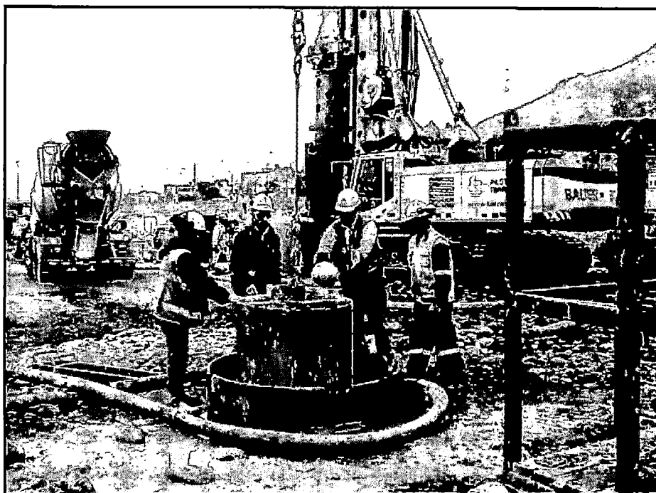
Figura N°5.16: Colocación de la pelota antes de iniciar el vaciado
