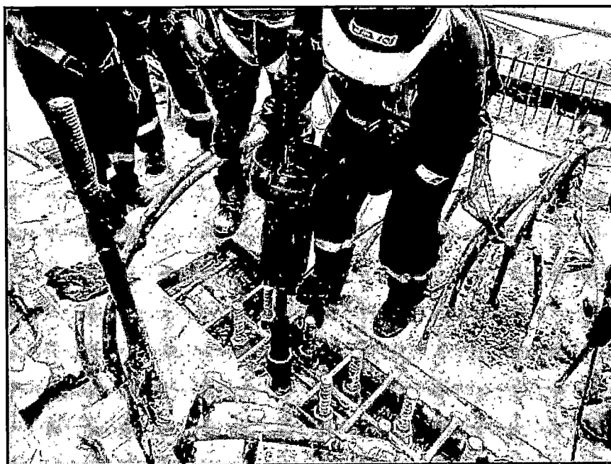
Figura N°5.61: Colocación de la silla
