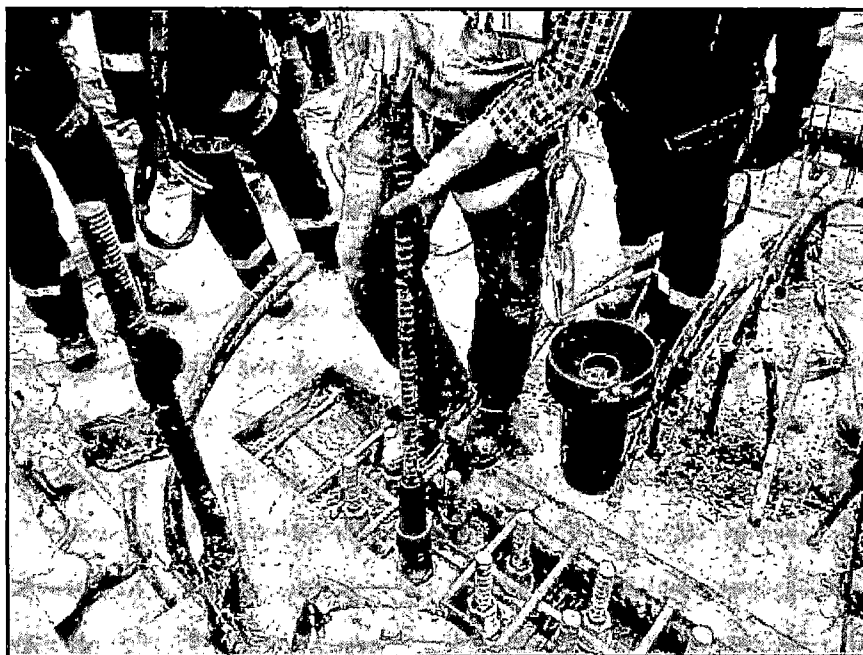
Figura N°5.60: Colocación de la barra de extensión
