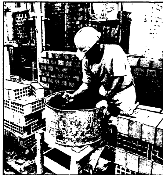
Figura N°5.14 Batido mezcla. Fuente: Propia
