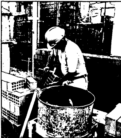
Figura N°5.13 Cortar ladrillo. Fuente: Propia
