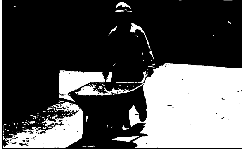
Figura N°2.3 Transporte de concreto para contrapiso. Fuente: Elaboración Propia
