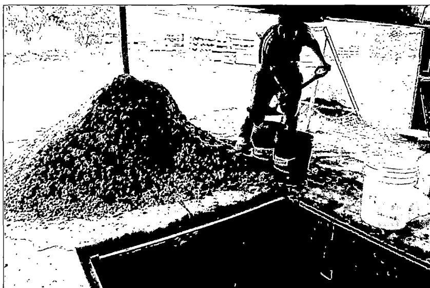
Figura N° 4.18. Material de relleno estructural con el óptimo contenido de humedad
