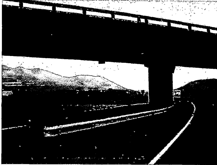
Figura 3.04: Fotografía de Puente Huaral
