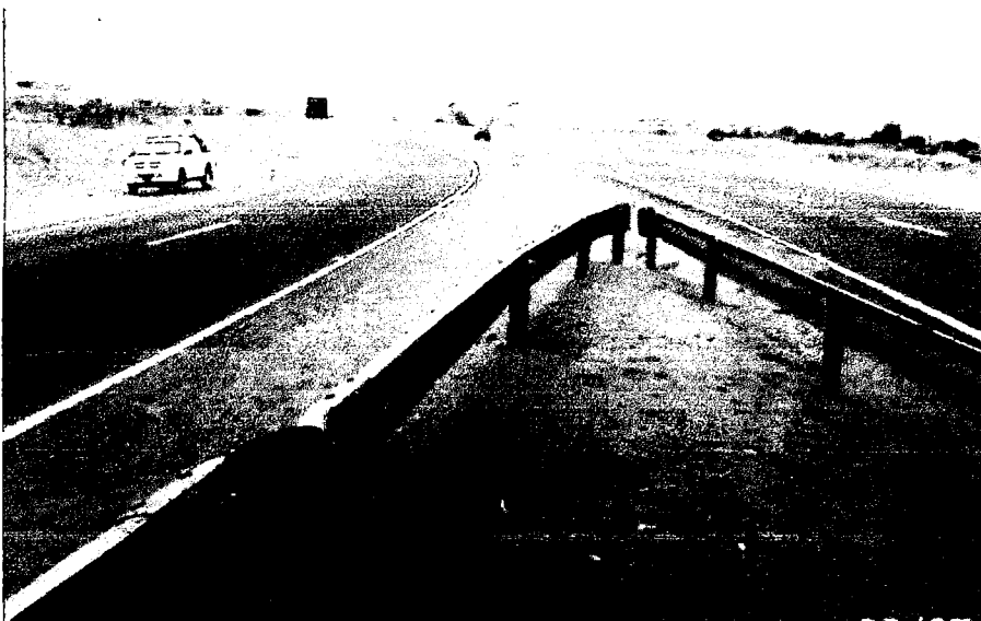
FIGURA 4.01: VISTAS DEL OBSTACULO EN PUENTE HUARAL
