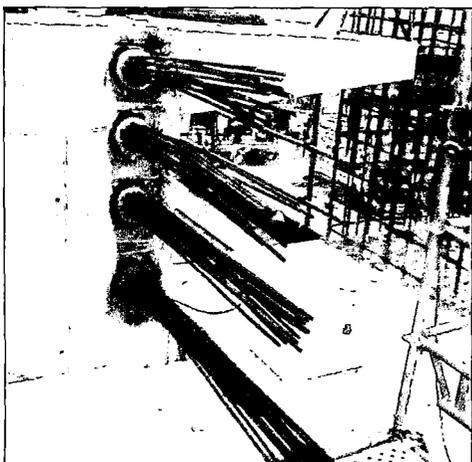
Figura N° 5.74. Bloques de anclaje. (Fuente: Propia)
