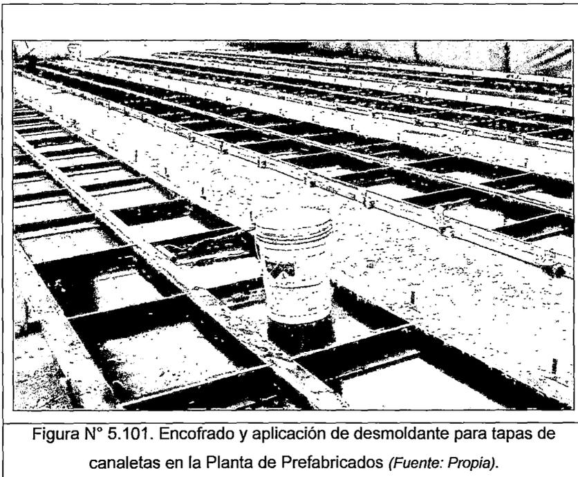
Figura N° 5.101. Encofrado y aplicación de desmoldante para tapas de canaletas en la Planta de Prefabricados (Fuente: Propia).
