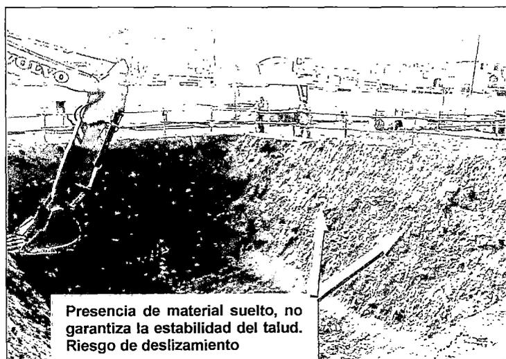
Figura N° 5.02. Situación de inestabilidad en los taludes longitudinales.
