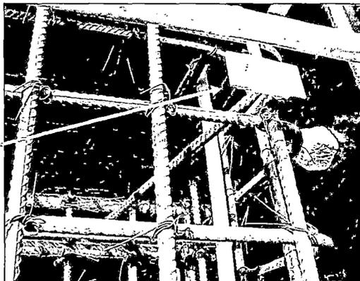
Figura N° 5.31. Sistema de protección contra corrientes de fuga en cabezales del Cruce Santa Rosa. Cabezal U33 (Fuente: Propia)
