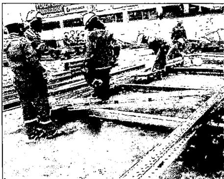
Figura N° 5.47. Pre-armado de cerchas MK en piso. (Fuente: Propia).
