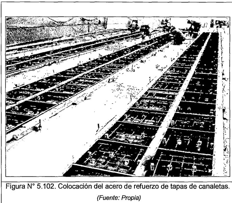
Figura N° 5.102. Colocación del acero de refuerzo de tapas de canaletas.
