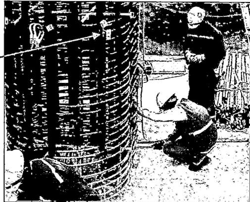
Figura N° 5.20b. Trazo y replanteo de ejes y recubrimientos de la columna (Fuente: Propia).
