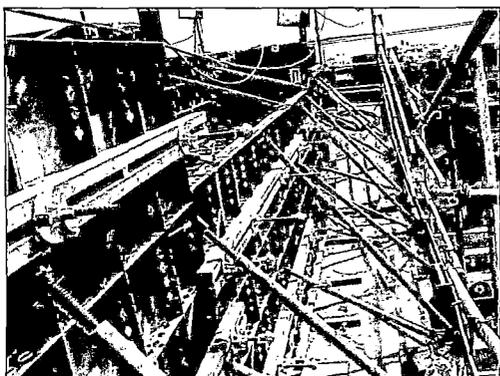
Figura N° 5.32. Encofrado de vigas cabezales empleando Paneles COMAIN. Cabezal U33 (Fuente: Propia)
