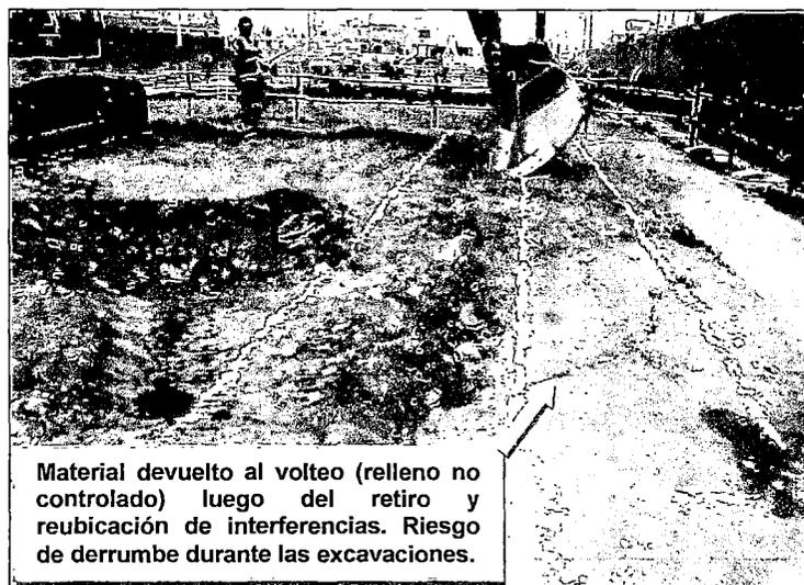
Figura N° 5.01. Presencia de rellenos no controlados
