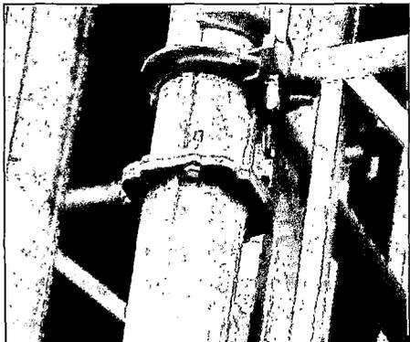
Figura N° 5.37. Unión entre puntales mediante tornillos (Fuente: Propia).
