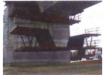
Desencofrado del tablero mediante tráctel
