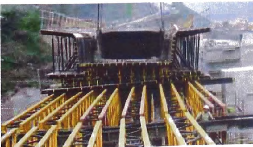
Ejecución de tablero con peralte
