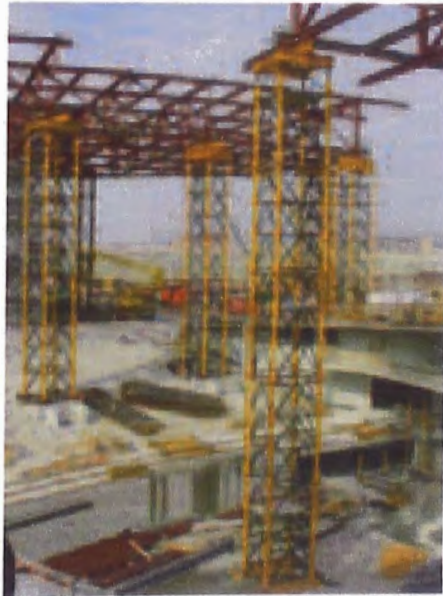
Cimbra T-500 como torre de apeo en Edificio FORUM, Barcelona, España
