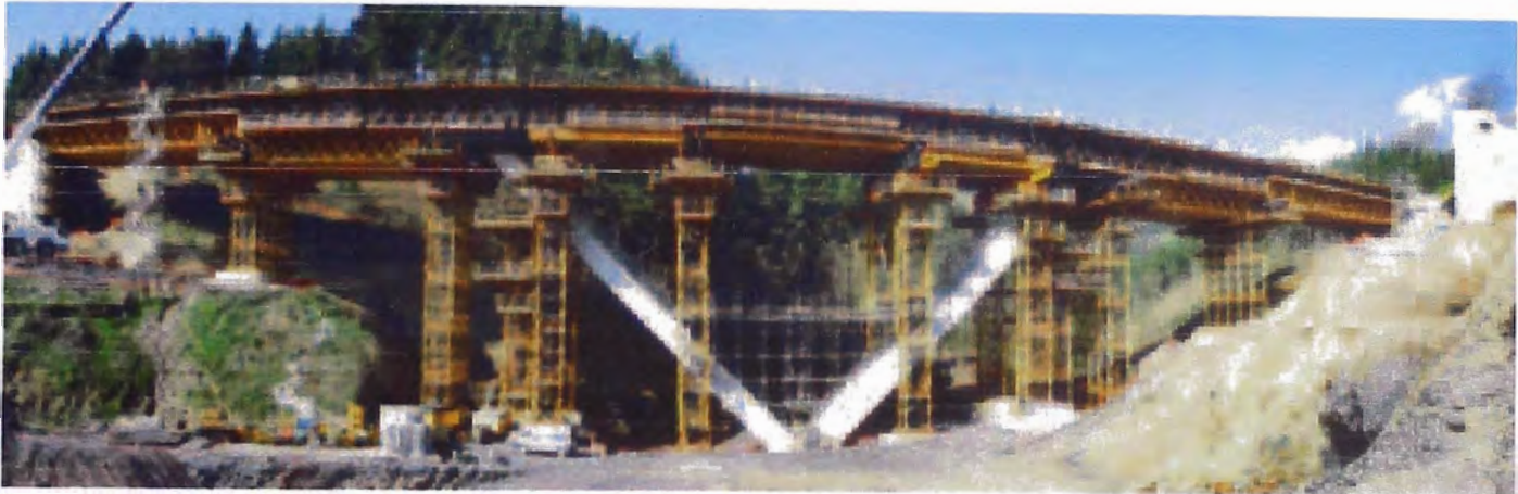
Cimbra T-500 en el Viaducto de Basagoiti, Aretxabaleta, España
