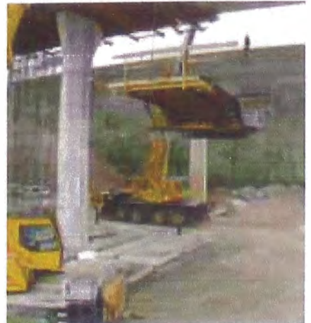
Desencofrado del tablero mediante grúa
