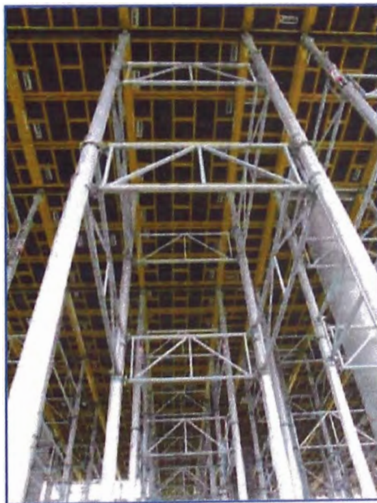
Figura 1.1 Puntales ALUPROP con marcos de arriostramiento
