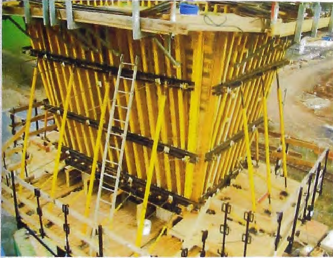
Encofrados a medida con elementos estándares
