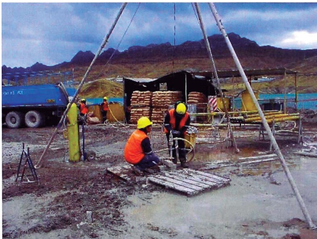
Foto 22: Instalación y desinstalación de obturadores dentro y fuera de los taladros de inyección con asistencia de un trípode.
