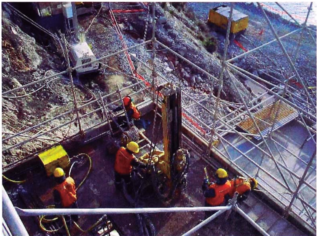
Foto 13: Perforadora de peso liviano Atlas Copco Diamec 262. Perforación desde la plataforma de andamios sobre el plinto en el estribo derecho.
