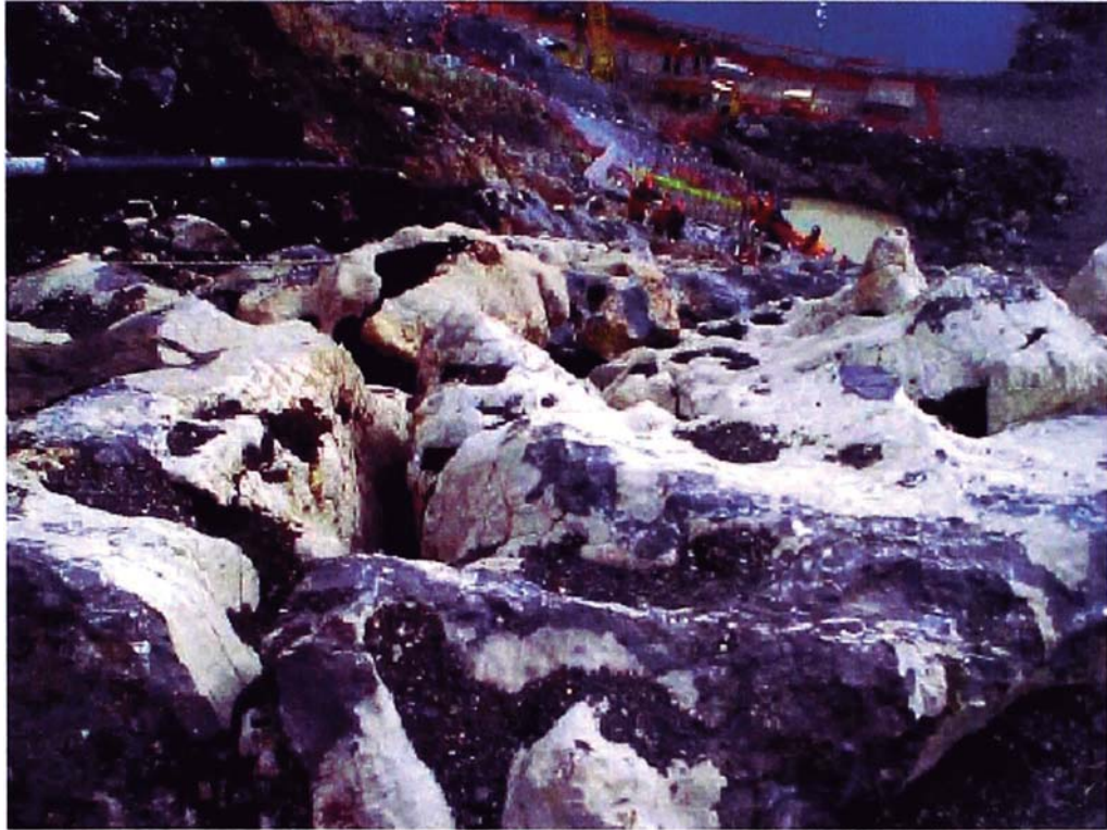
Foto 36: Condiciones Kársticas en el Plinto del Estribo Derecho.
