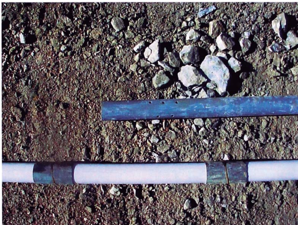
Foto 24: Puertos de salida de mezcla del Tubo Manguito cubiertos con caucho, comprendidos por un arreglo de huecos de 5 mm de diámetro espaciados en intervalos de 50 cm a lo largo del tubo manguito.
