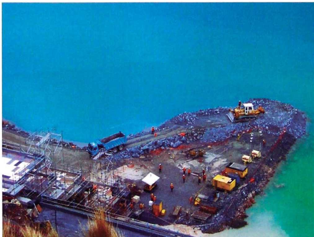
Foto 3: Estribo Derecho. Extensión y construcción de la plataforma de trabajo "Espigón". Intercepción de la zona de Filtro y extensión de la cortina.
