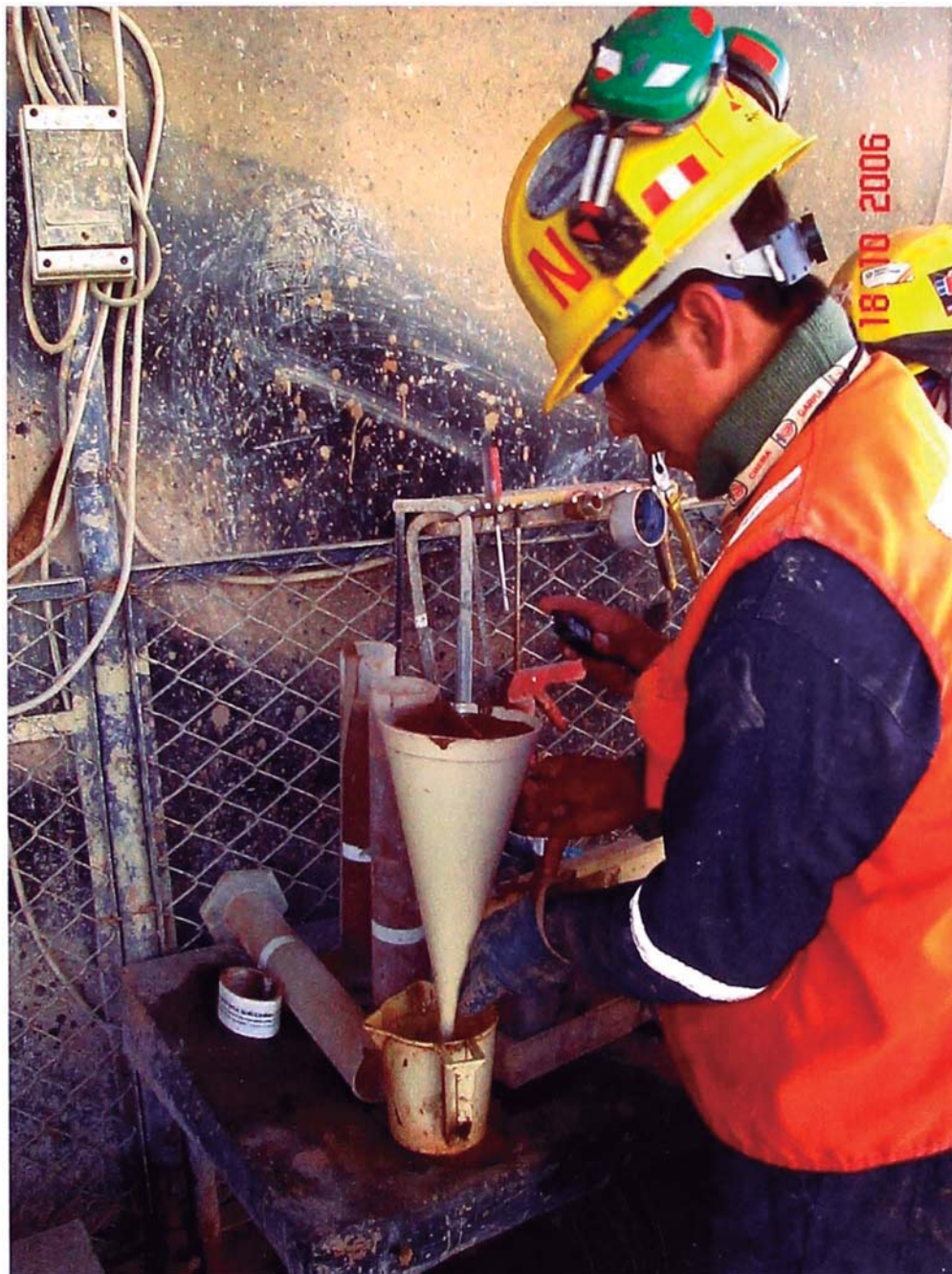
Foto 30: Control de calidad de la viscosidad de la mezcla utilizando el cono de Marsh.
