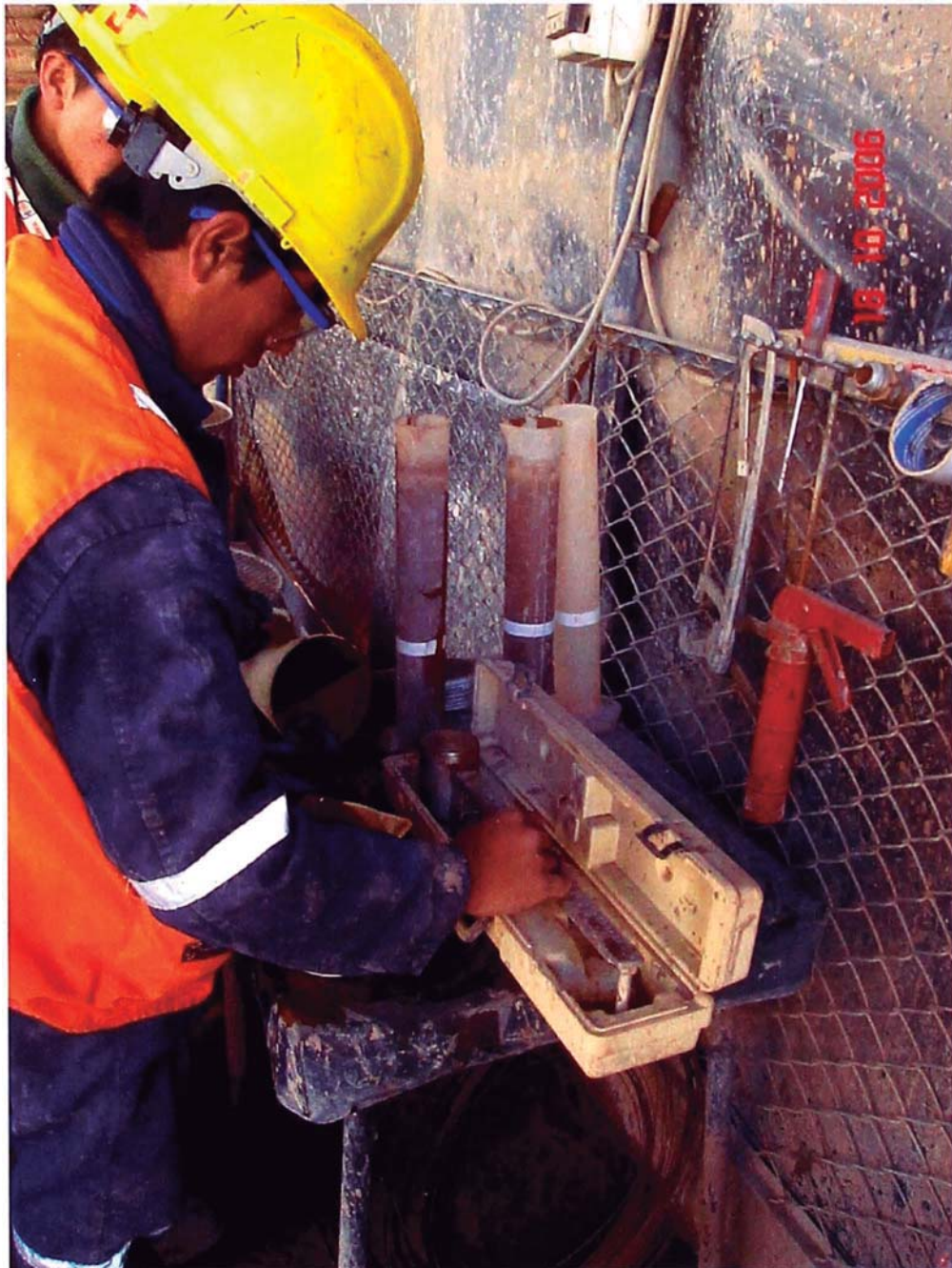
Foto 31: Control de calidad de la densidad de mezcla, utilizando la balanza de lodos.
