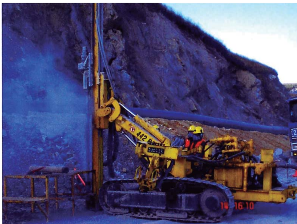
Foto 10: Equipo de perforación Atlas Copco Track Drill AP-442.
