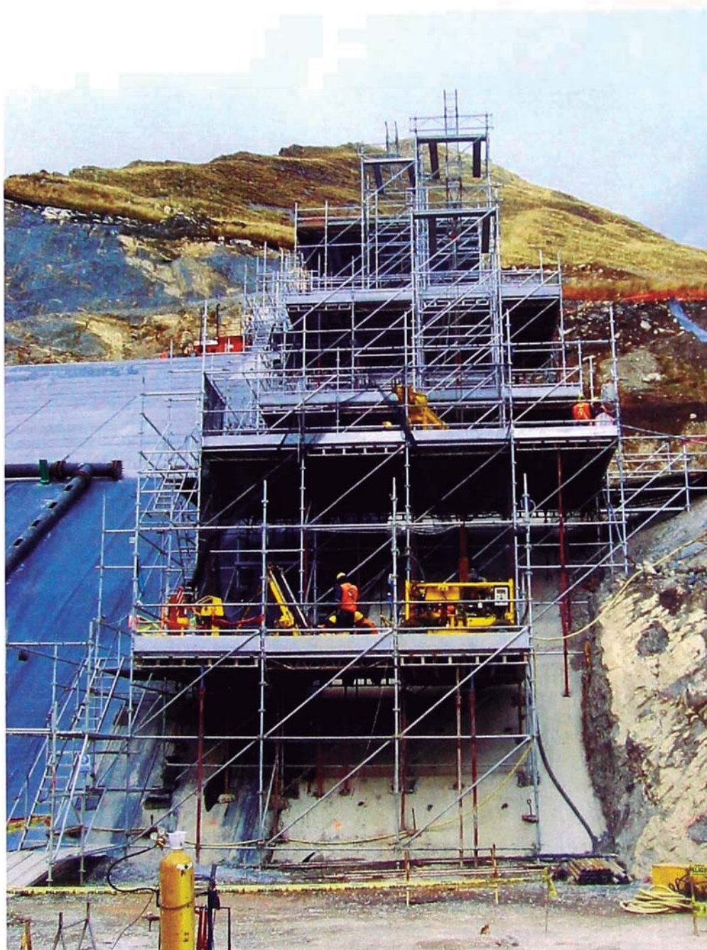
Foto 5: Perforación e inyección sobre el plinto del estribo derecho realizado desde andamios anclados independientemente.
