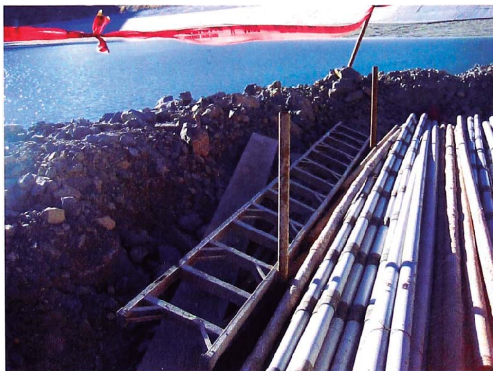
Foto 23: TAM (tubos manguitos) a ser instalados dentro de los taladros de inyección para los propósitos de inyección de suelos o rocas con fracturas muy a extremadamente cerradas.
