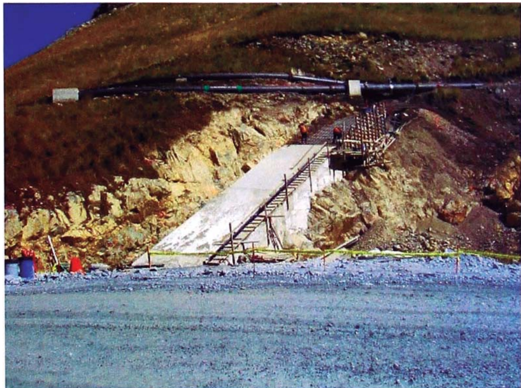
Foto 2: Construcción del Plinto reforzado en el estribo izquierdo.
