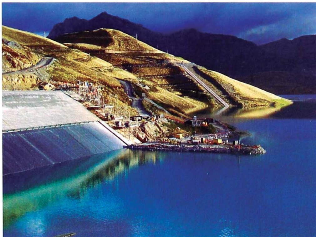
Foto 4: Vista del plinto del estribo derecho y de la plataforma de trabajo "Espigón", desde la cresta de la presa de relaves.
