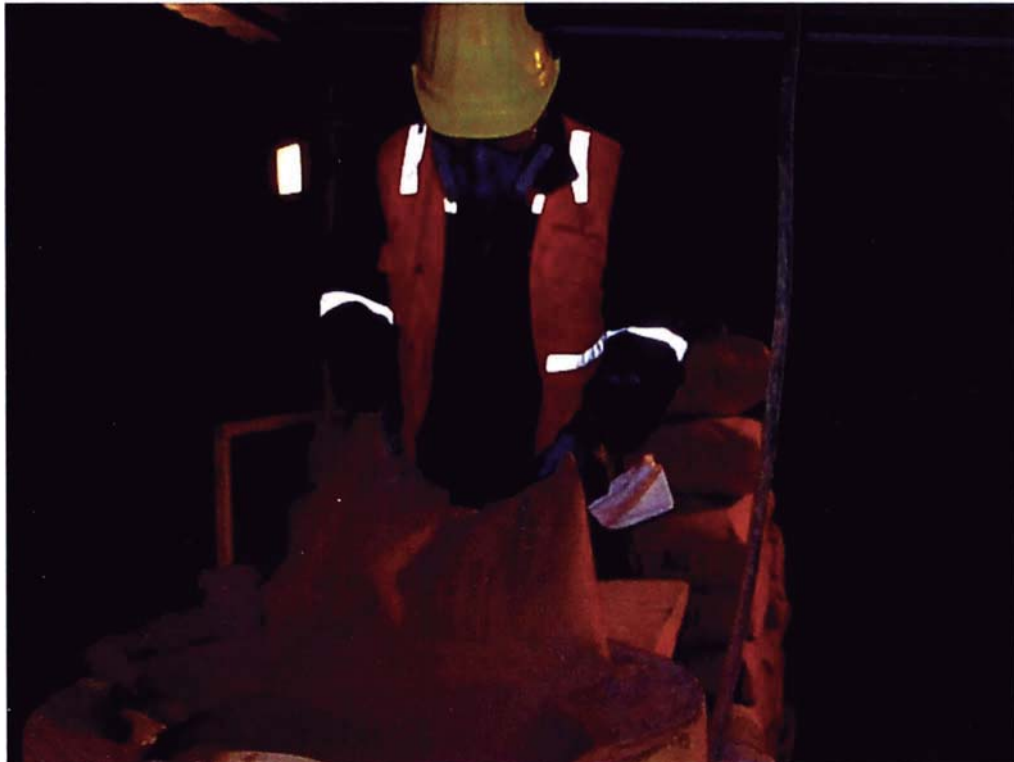
Foto 28: Adición del cemento puzolánico Atlas tipo 1P dentro del mezclador coloidal. Notar el uso de un respirador particular.
