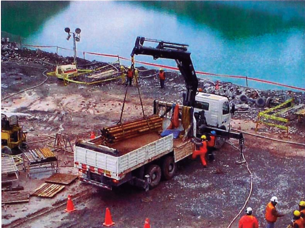
Foto 6: Camión con grúa tipo HIAB utilizado para la movilización de materiales hacia y desde el patio de depósito sobre el estribo izquierdo.
